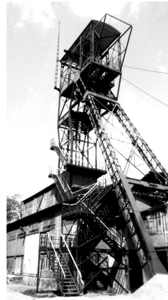
1.18 Schacht Carnall in Zabrze, Oberschlesien, Polen
