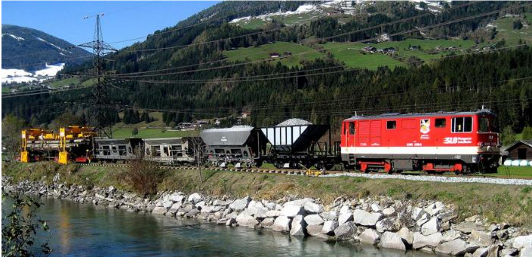
Abbildung 14: Wiederaufbau des Streckenabschnitts Mittersill – Krimml [43]
