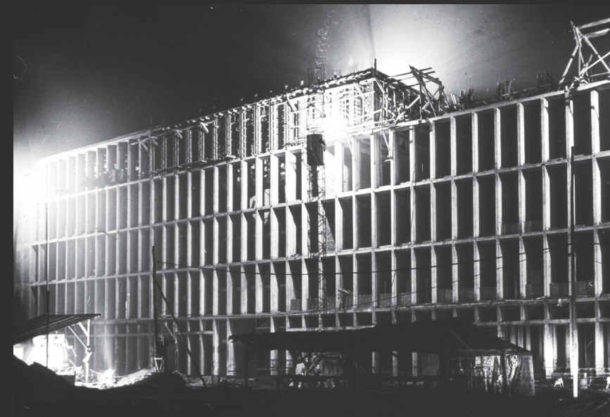
Erichtung der Raumrasterkonstruktion
