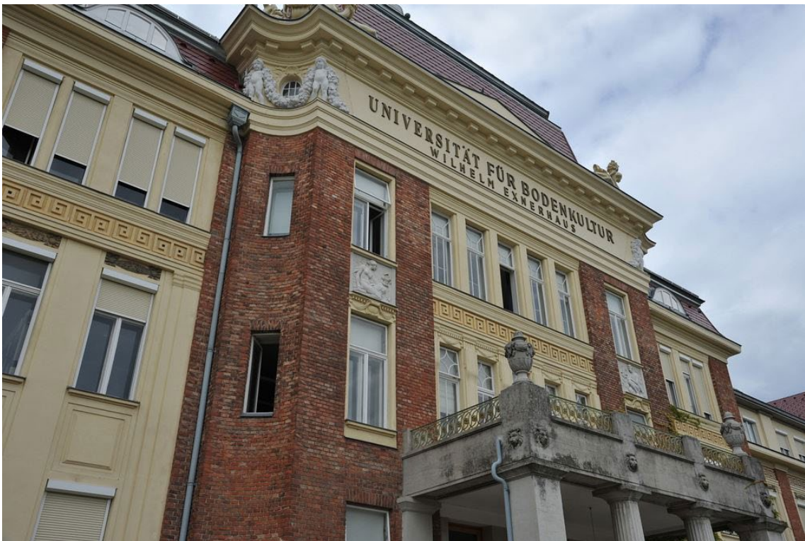
Abb. 10 Wilhelm Exner-Haus, Wien, Österreich, 2012
