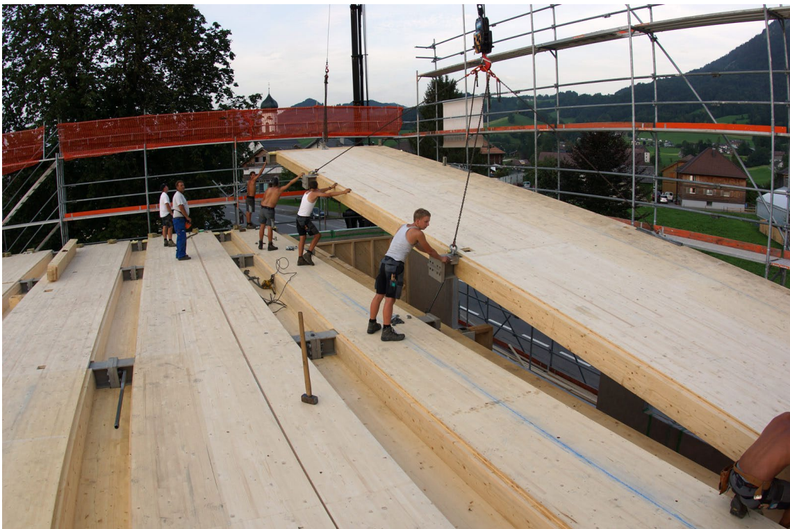
Abb. 16 Typische Baustelle, wo vorgefertigte Holzelemente einfach gefügt werden
