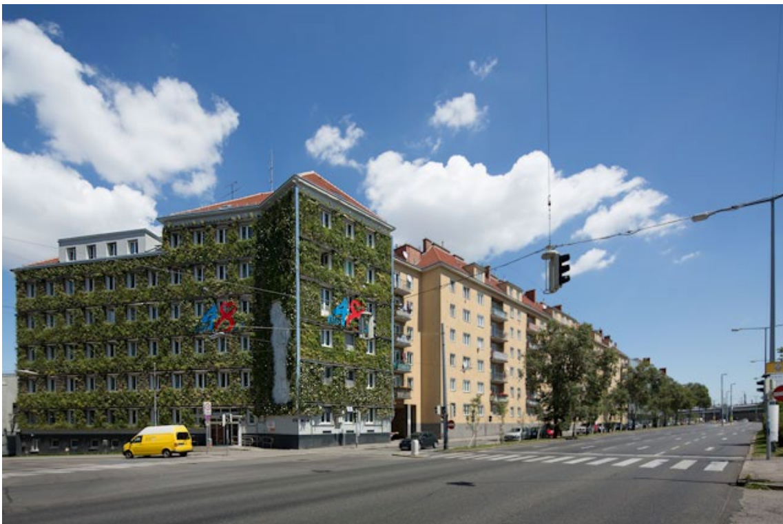
Abb. 27 Verwaltungsgebäude der MA 48, Wien, Österreich, 2010
