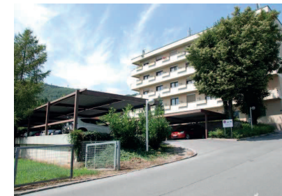
Abb. 33 | Ansicht Nord-Ost im Sommer
