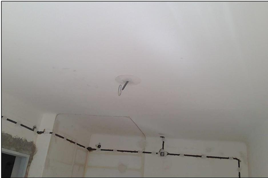
Abbildung 5-59: Leitungsverlegung in bestehender Decke inkl. Verputzen<sup>67</sup>
