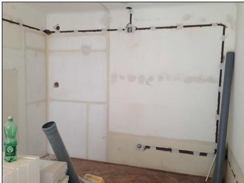
Abbildung 5-94: Leitung in bestehender Wand eingeschlitzt<sup>79</sup>
