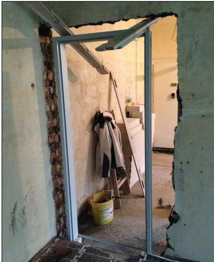
Abbildung 5-137: Neuherstellung Innentürzarge<sup>95</sup>
