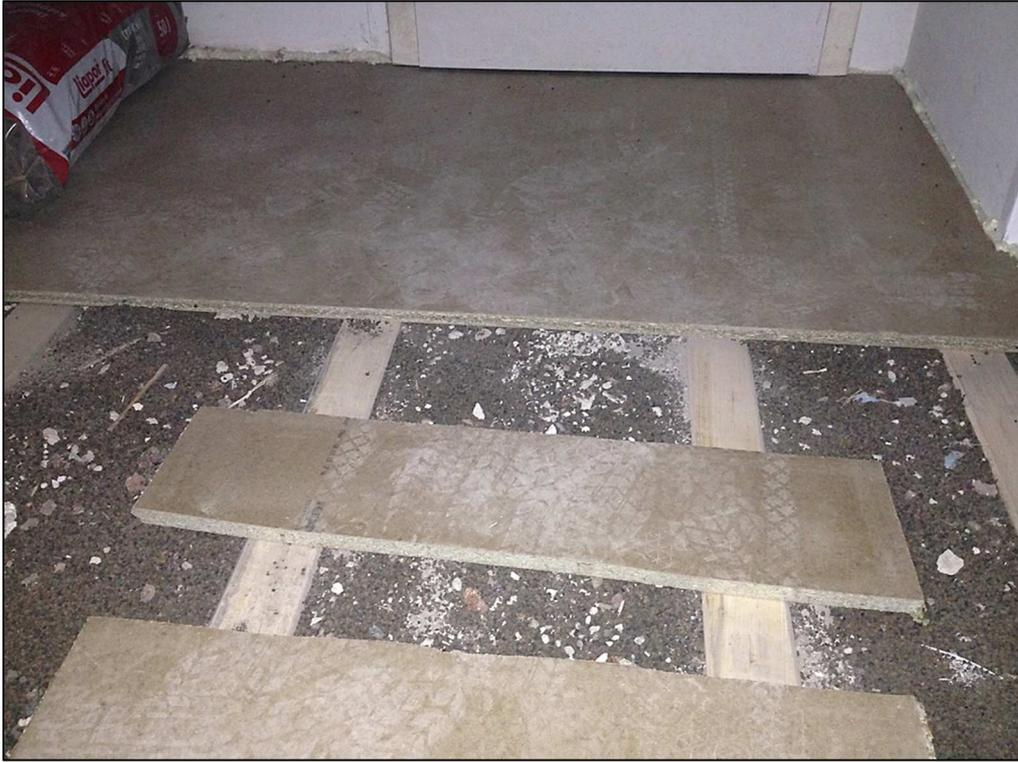
Abbildung 5-14: Holzunterboden neu herstellen inkl. Blindboden<sup>47</sup>
