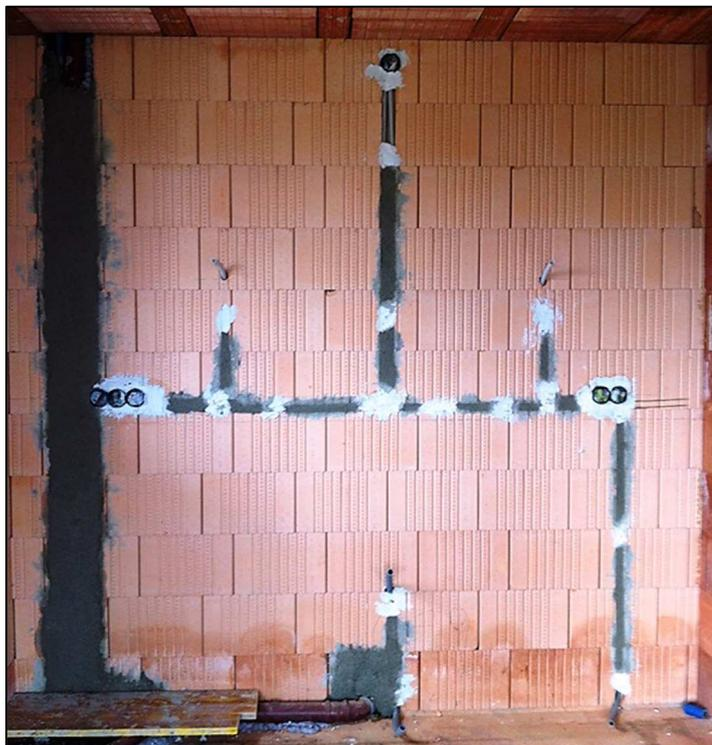
Abbildung 5-118: Ziegelmauer mit eingeschlitzten Leitungen<sup>86</sup>
