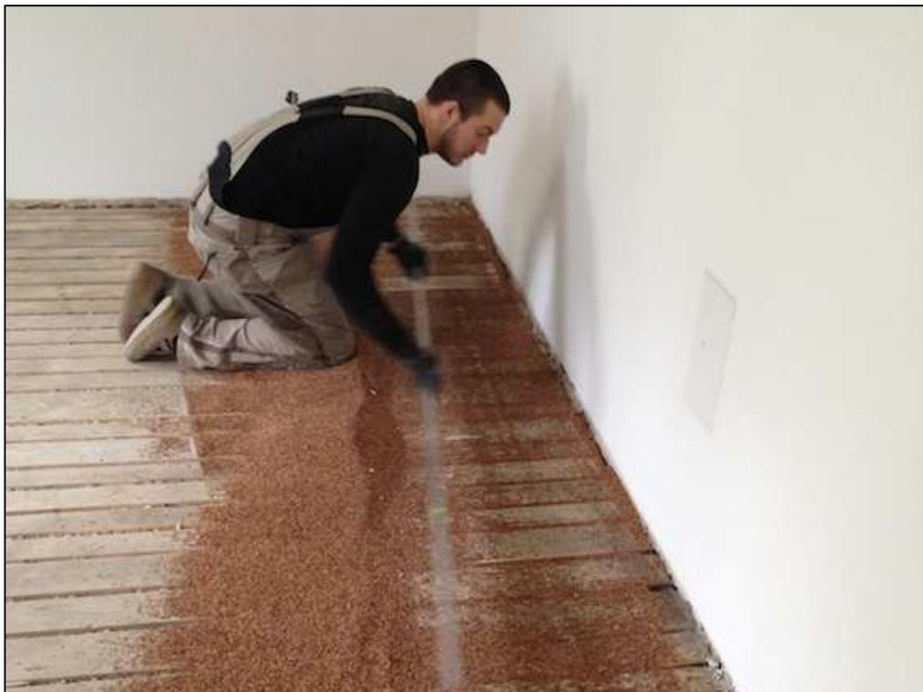
Abbildung 5-13: Holzunterboden instandsetzen. Verwendung von Perlite<sup>46</sup>
