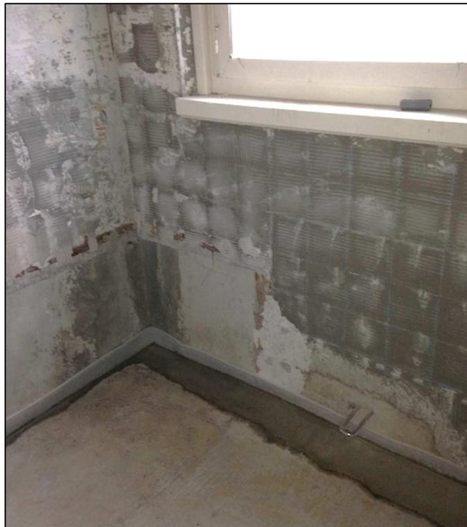
Abbildung 5-33: Kleinflächige Estrichsanierung<sup>56</sup>
