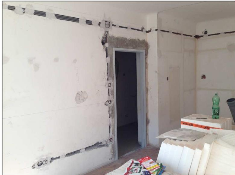
Abbildung 5-119: Leitungsverlegung in bestehender Wand<sup>87</sup>
