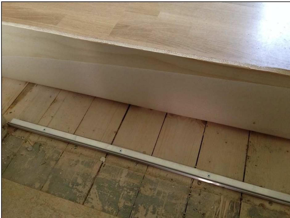
Abbildung 5-23: Fertigparkettboden auf Holzunterbodenkonstruktion verlegt<sup>50</sup>
