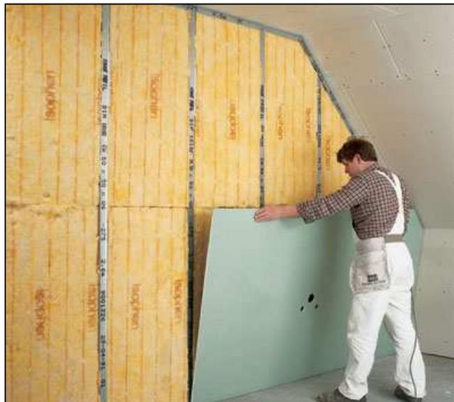
Abbildung 5-105: GKB-Wand als Zwischenwand herstellen<sup>83</sup>
