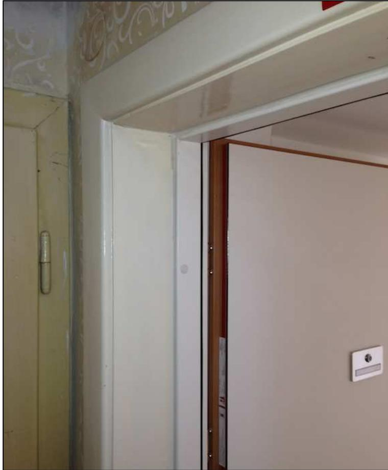
Abbildung 5-138: Instandgesetzte Innentürzarge<sup>96</sup>
