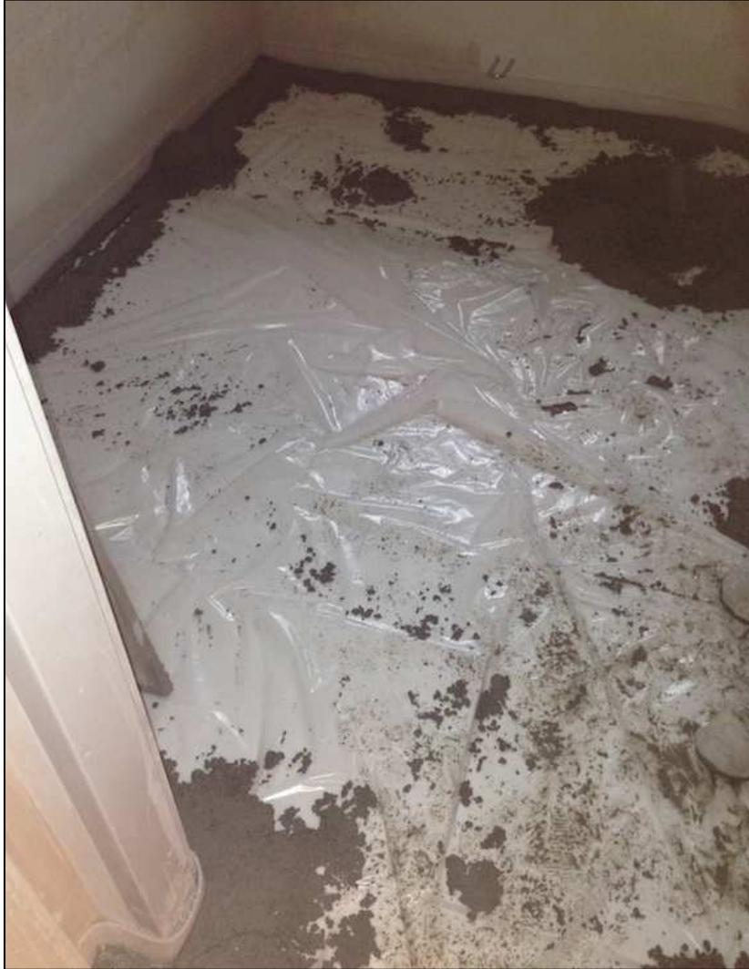
Abbildung 5-34: Estricherneuerung<sup>57</sup>
