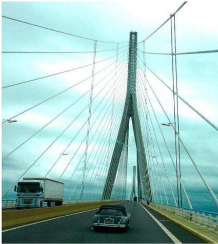
Abbildung 2.12: Stabilisierungsseile an der Pont-de-Normandie [6]
