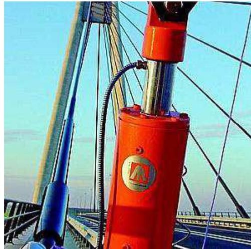
Abbildung 2.13: Schrägseildämpfer [7]
