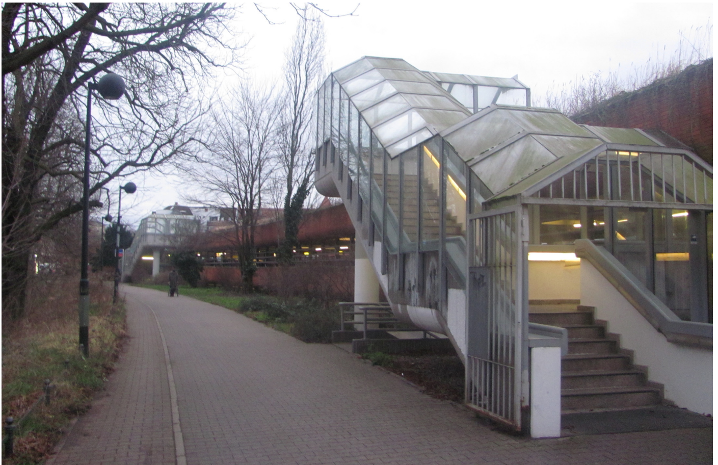
Parkhaus am Mühlengraben ( Quelle: Eigene Aufnahme )
