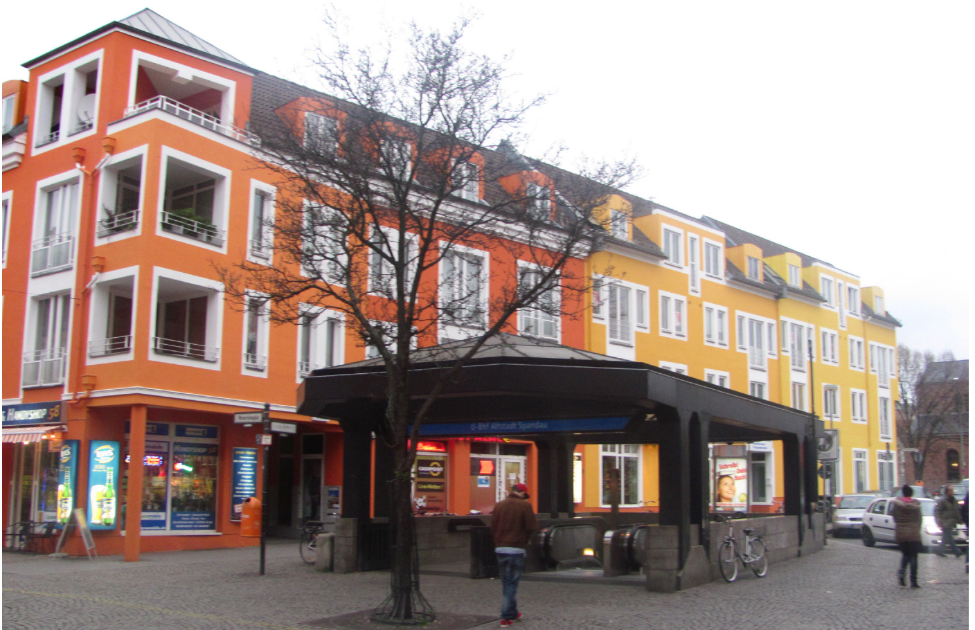
Versperrung der Ladenzone durch U- Bahn- Eingang (Quelle: Eigene Aufnahme)
