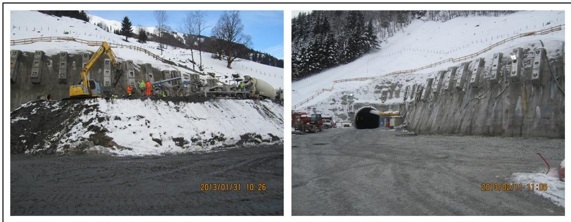
Abbildung 20: Bereich "links" (L: Abtrag verbleibender Berme; R: fertiggestellt) [18]
