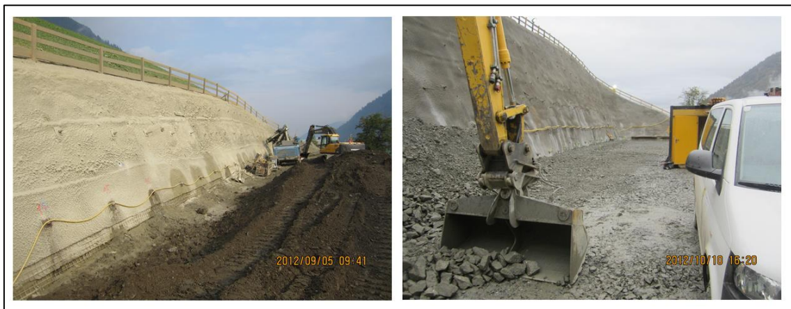
Abbildung 17: Bereich "rechts" (L: Aushub, R: fertiggestellt) [18]
