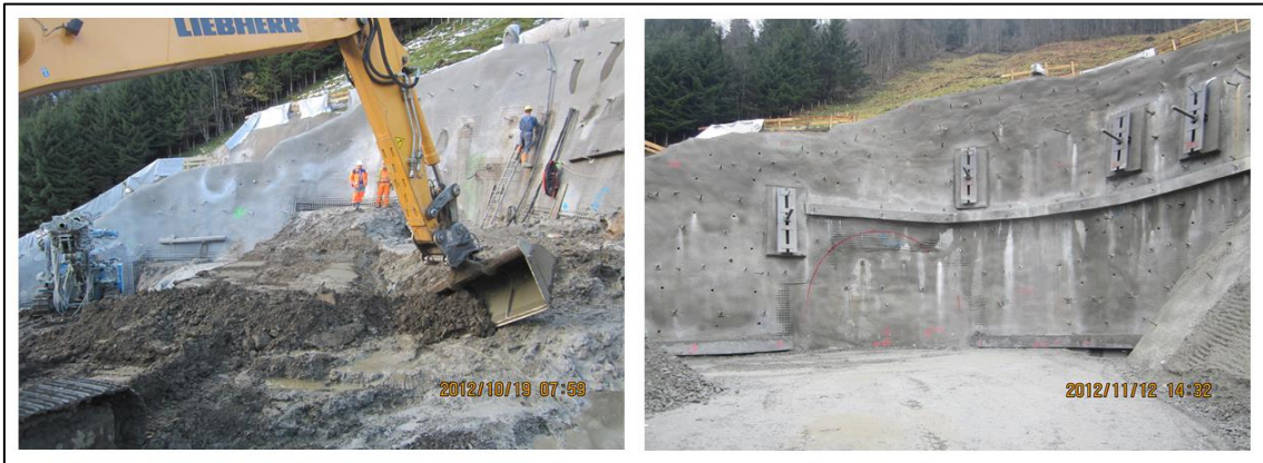
Abbildung 18: Portalbereich (L: Aushub, R: fertiggestellt) [18]
