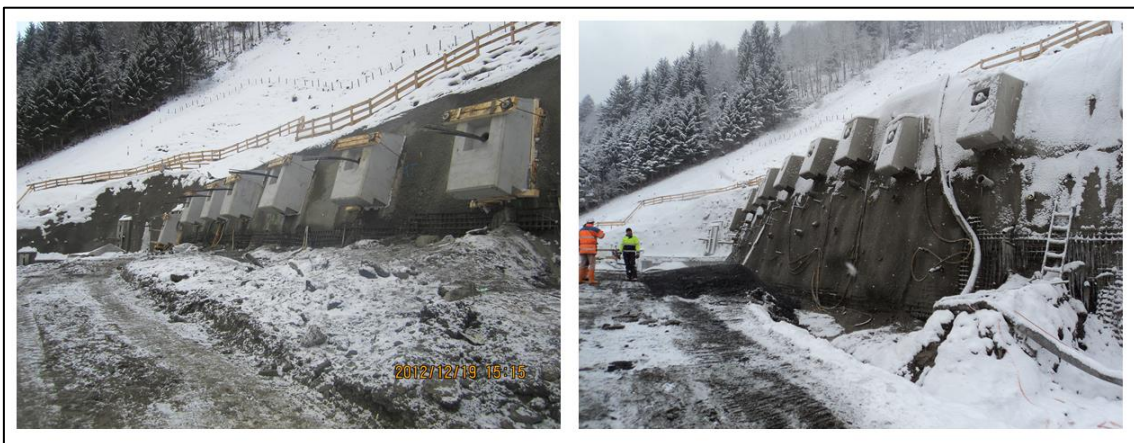
Abbildung 19: Bereich "links" (L: 1. Abtragungsebene, R: 2. Abtragungsebene) [18]
