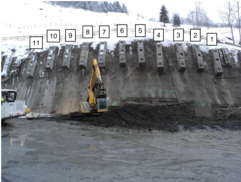
Abbildung 51: Ankerblöcke 1 bis 11 [18]
