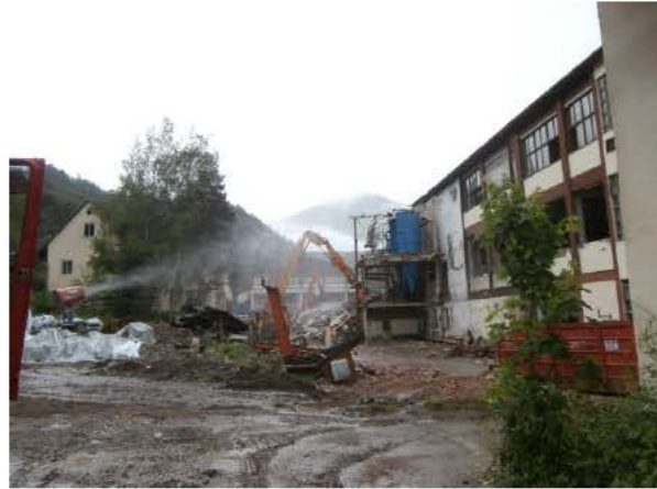
Abb.106: vor dem Abriss A3 Hauptgebäude und Portierhäuschen mit Lager Abb.107: nach dem Abriss des Portierhäuschens und weiterer Abbruch des Hauptgebäudes, Staubprävention durch eine Schneekanone
