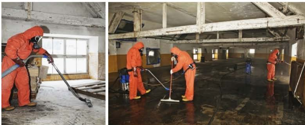
Abb.89-90: Absaugung der Böden von gefährlichen Stäuben und Losematerialien und anschließende Reinigung
