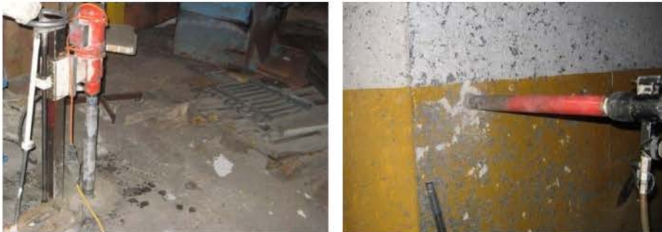
Abb.85-86: Probenahmen zur Prüfung der Bausubstanz
