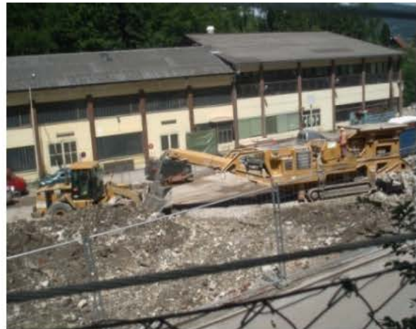
Abb.96: Aufbereitung der Baumassen (Transportschnecken-Zerkleinerung)
