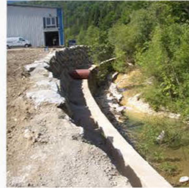
Einleitung der Hangwässer in die Feistritz
