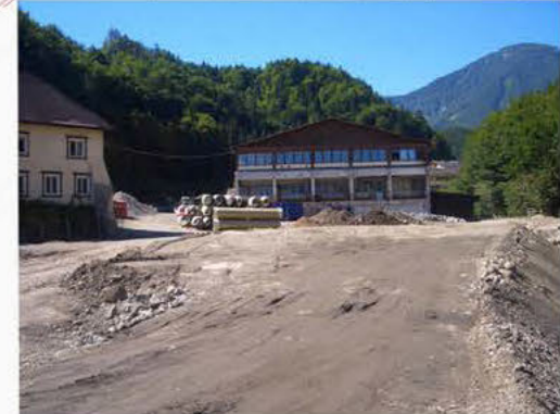
Beginn der Geländekorrektur, Anschüttungen, Ausbildung der Geländeneigung (Gefälle)
