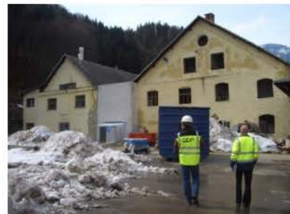
Abb.95: Freigabe für den Abbruch
