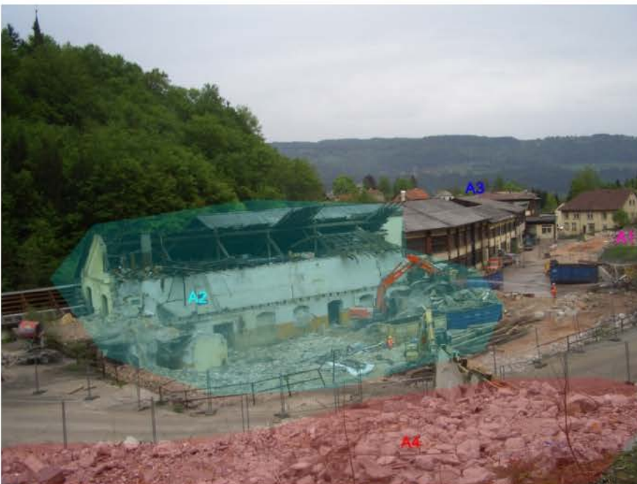
Abb.102: Blick zu den 4 Abbruchzonen, A4 PVC Fertigung II, Blick von Süden
