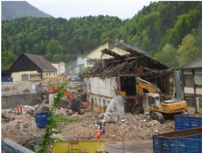
Abb.101: Abbruch der ehemaligen Schlosserei
