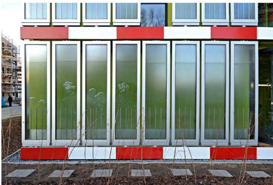
Abb.140: Geschossanordnung der Fassadenelemente
