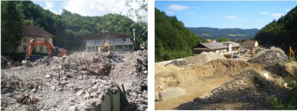
Abb.110-111: Baumassenrestverwertung am Areal, Massenbilanzermittlung durch die Baufirma Mörtl Bau GmbH
