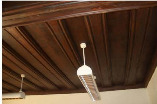
Abb.77: 1.OG Holzbohlendecke-wertvollste des Gebäudes aus dem 16.Jht
