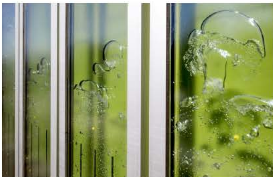
Abb.144: Turbulenzen in der Bioreaktorfassade zur Verhinderung von "Biofouling", Belebung der Fassade durch die aufsteigende Luftblasen
