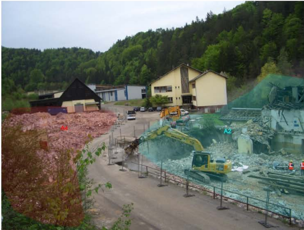
Abb.103: Bereich A4 und A2, Blick von Norden
