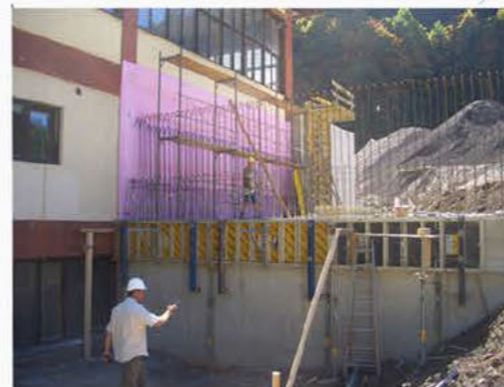
Bau der Stützmauer
