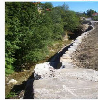
Steinschichtung entlang der Feistritz bis zur Anrainerbrücke
