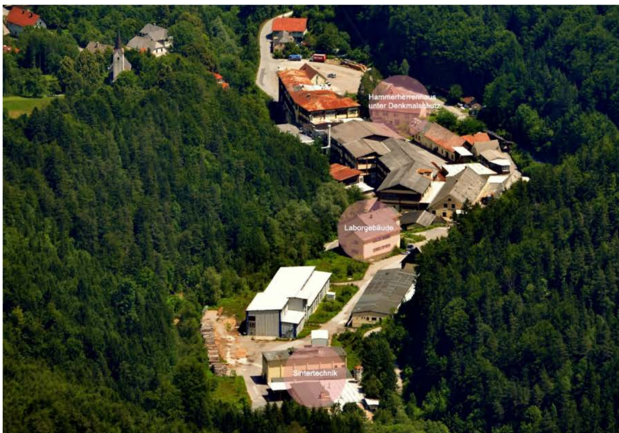
Abb.71: Luftaufnahme vom Areal vor dem Gebäudeabbruch, Bestandsaufnahme, zur Verfügung von Fr. Bürgermeisterin Sonya Feinig
