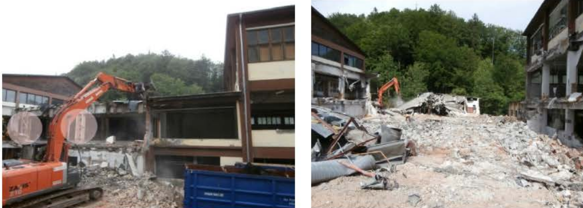
Abb. 104-105: Holzunterkonstruktionen beim Abbruch des vorderen Abschnitt des Hauptgebäudes (Gebäude 2)
