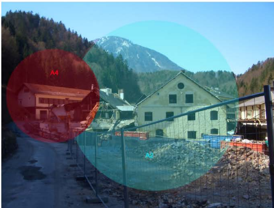
Abb.100: Blick auf die Abbruchzonen A2(PVC-Fertigung I, Heizraum und ehemalige Schlosserei) und A4 (PVC-Fertigung II), von Norden
