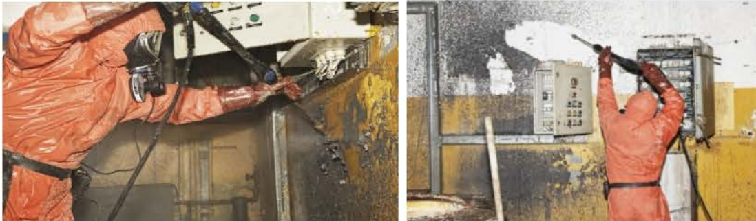
Abb.87-88: Reinigung der Wände von Bleirückständen bei der Dekontamination der ehemaligen Betriebsgebäude
