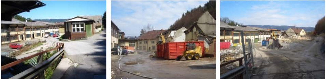
Abb.97: vor den Abbrucharbeiten A1, Abb.98-99: bei und nach dem Abbruch A1
