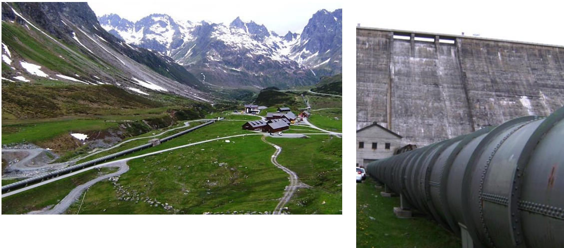
Abbildung 4: derzeitige Druckrohrleitung Obervermuntwerk I, links Blick in Fließrichtung, rechts Blick gegen die Fließrichtung: Druckrohrleitung und Staumauer Silvrettasee
