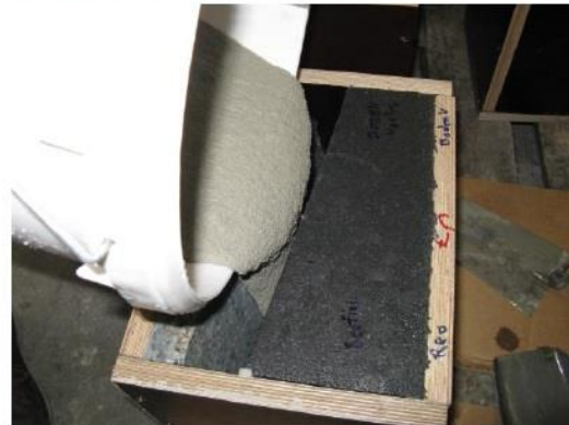
Abbildung 4: Befüllen einer Wachsbron-Form (3-D Flächen-Schalung und Konterschaltung aus 2 verschiedenen Wachsbron Mischungen)
