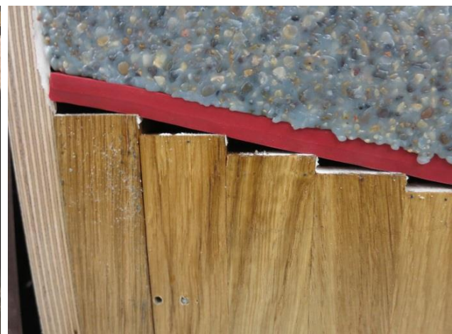
Abbildung 85 Pixelglättung Elastomermatte
