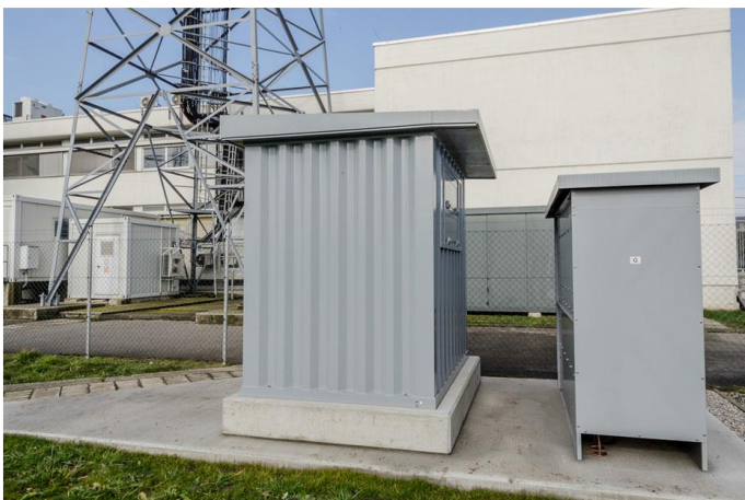
Abbildung 16: Gehäuse der KNOPE-Zuschaltlogik (links) und des Widerstands (rechts) [4]
