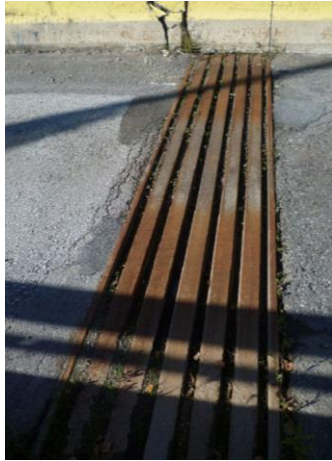
Verschmutzte Fahrbahnübergangskonstruktion
