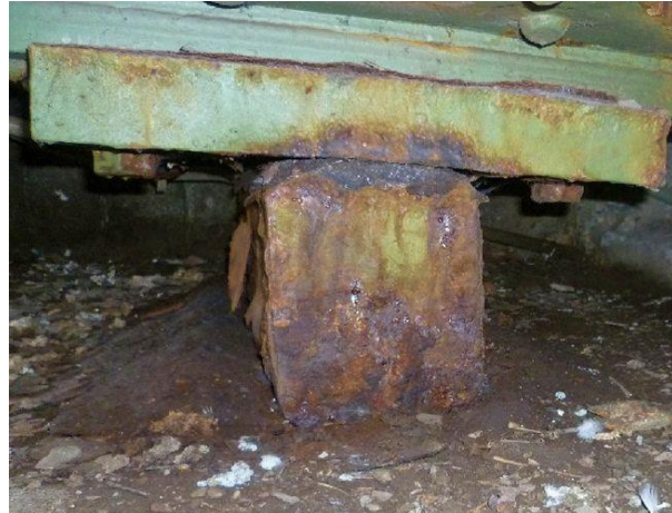
Korrodiertes Stahllager
