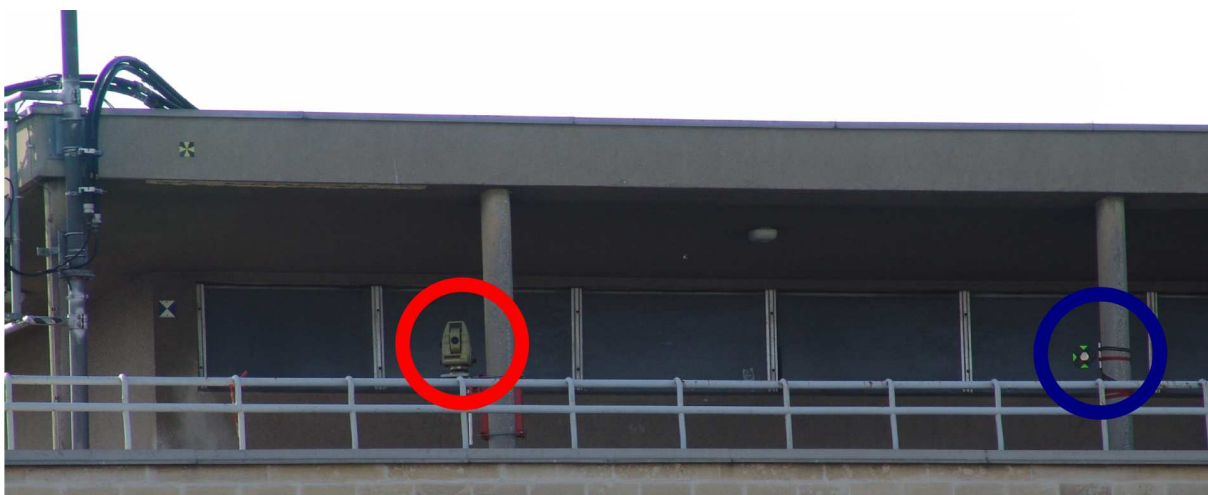
Abbildung 8-6: Totalstation (rot) und Prisma Referenzstrecke (blau) auf Chemiegebäude montiert
