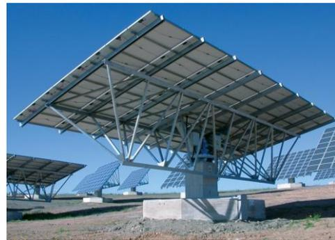
Abbildung 28: Nachgeführte PV-Anlage
