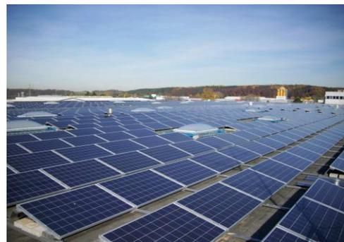
Abbildung 30: Flachdachaufstellung einer PV-Anlage
