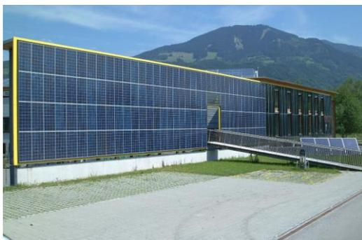
Abbildung 31: Fassadenintegration einer PV-Anlage
