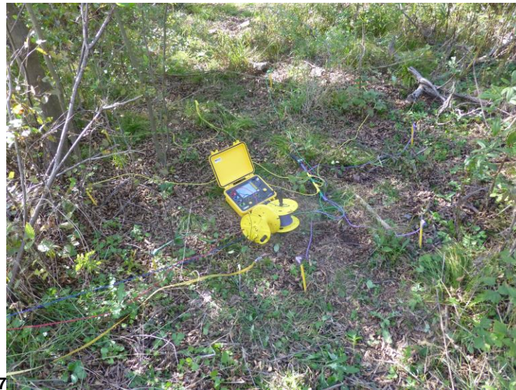
Abbildung 6-10 Erdungsmessung bei Erdungsanlage 1
