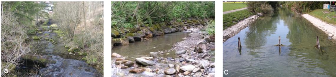
Abbildung 88, Abbildung 89 und Abbildung 90: a) natürliche Uferstruktur; b) einseitige Uferverbauung;<sup>88</sup> c) durchgehende Uferverbauung (Sattnitz)
