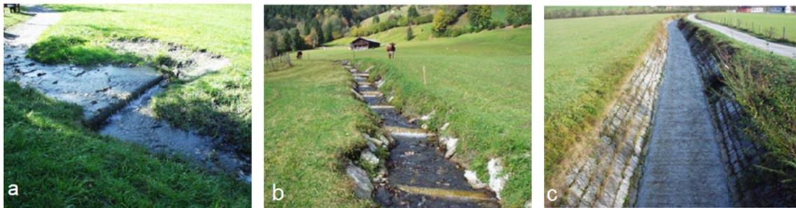
Abbildung 85, Abbildung 86 und Abbildung 87: a) naturnahe Sohle mit einzelnen Sicherungsmaßnahmen; b) Sohle mit regelmäßigen Sohlsicherungsmaßnahmen; c) Künstliche Sohlpflasterung<sup>87</sup>
