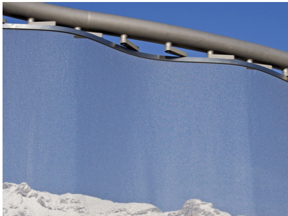
Abb. 111: Wellenförmige Befestigung des Ringgeflechtes
