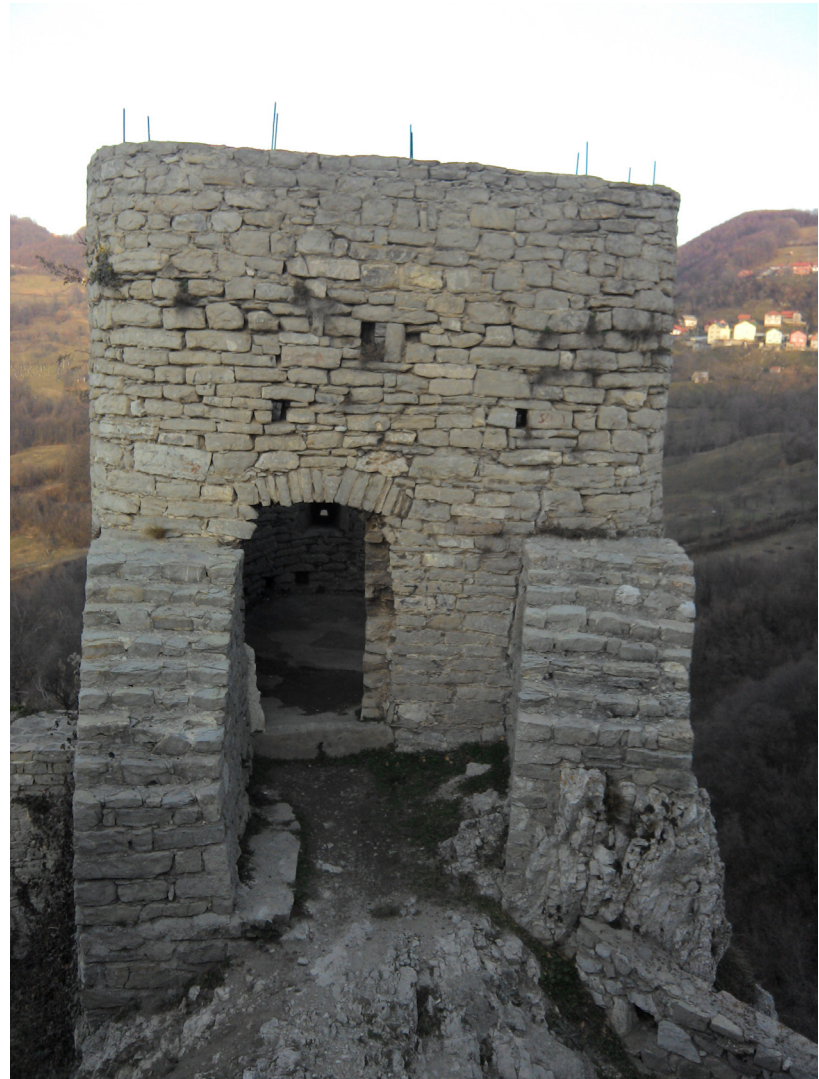
Abb. 36: Eingangsbereich von Turm II. In dieser Aufnahme ist die rausstehende Bewerung am oberen Abschluss der Mauer zu sehen.
