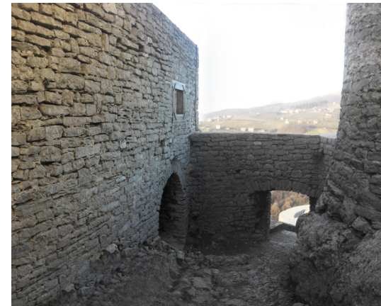
Abb. 119: Zugangsbereich zum Palast
