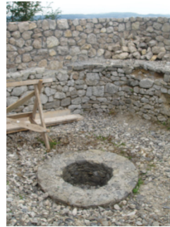
Abb. 42a: Baustelle am Turm III im Juli 2014
