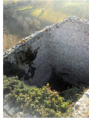
Abb. 27: Die Ruine vor der Burg
