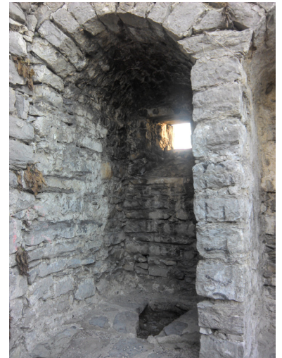
Abb. 52: Nische die im Mittelalter als Toilette diente
