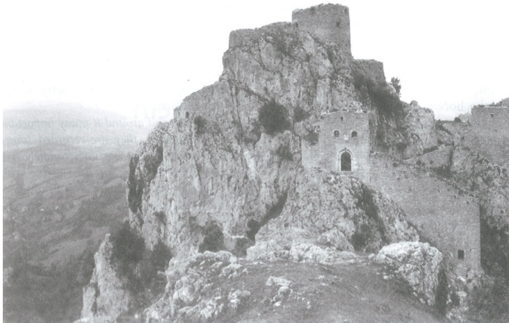
Abb 59. : Srebrenik 1977 vor der Rekonstruktion der Brücke
