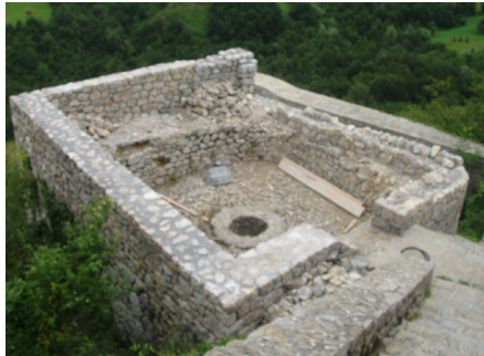
Abb. 42: Baustelle am Turm III im Juli 2014
