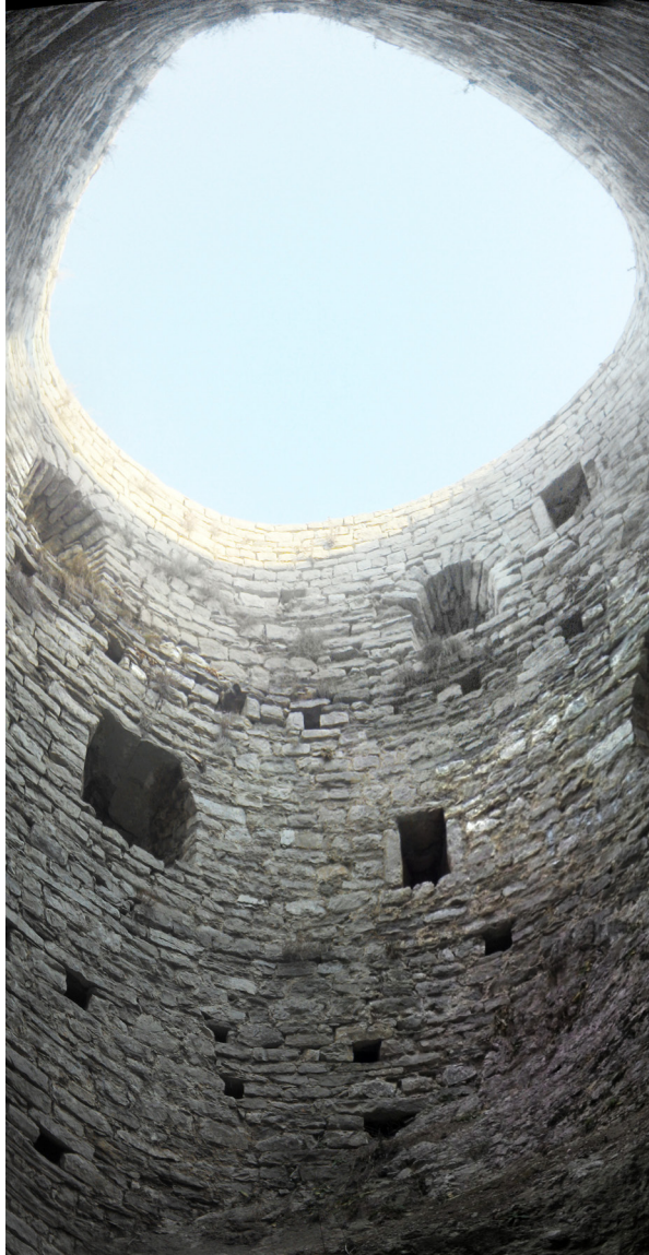
Abb. 44: Innenraum Turm IV
