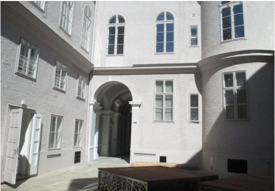
Fotos Nr. 2.2 Fotos nach Umbaumaßnahmen im Mai 2015
