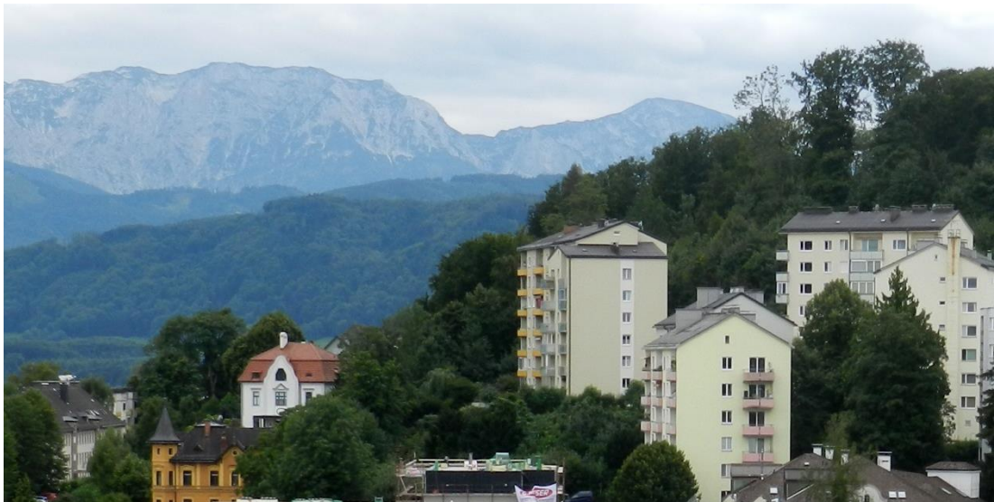
Abbildung 36: Die sogenannten Ruston-Hochhäuser am Hochkogel
