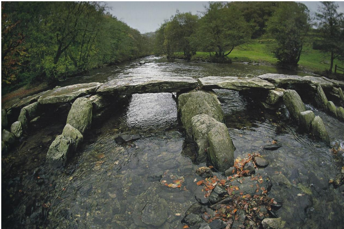
Abbildung 1: Brücke über Fluss Barle.
