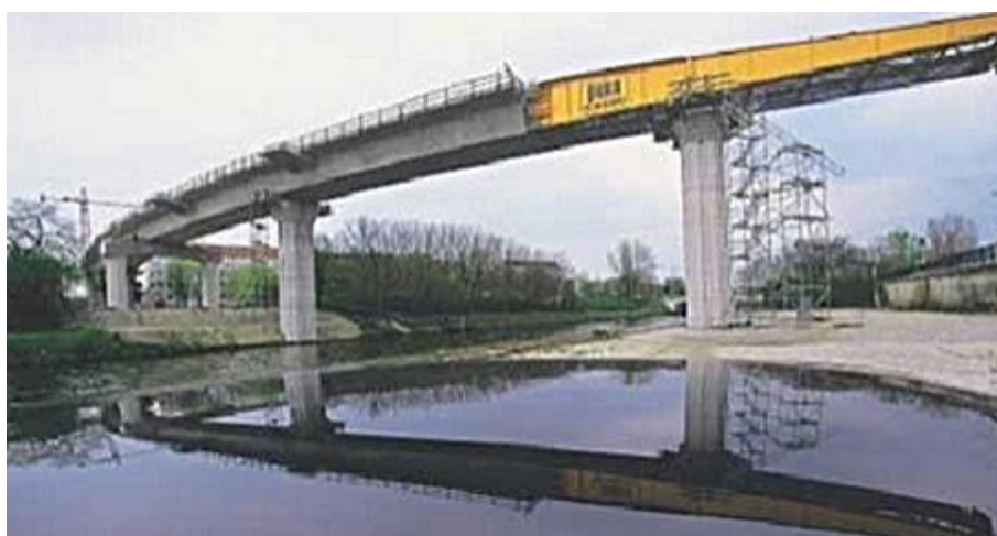
Abbildung 40: Taktschiebeverfahren.
