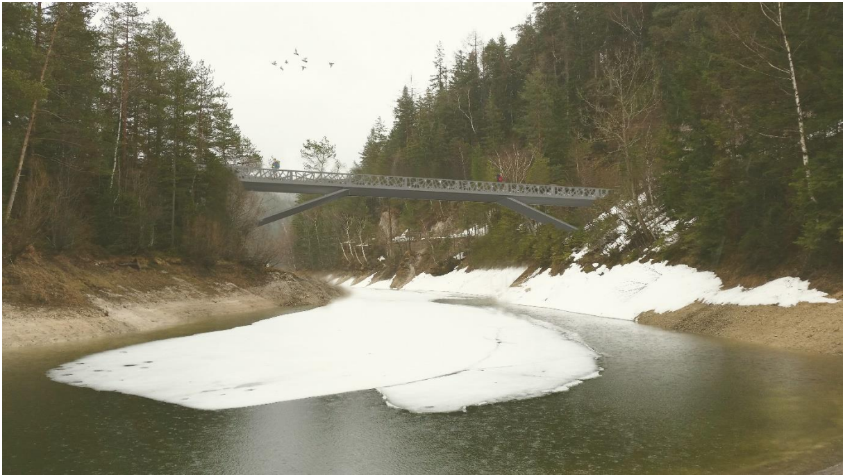
Abbildung 108: Ansicht seitlich in Fließrichtung.
