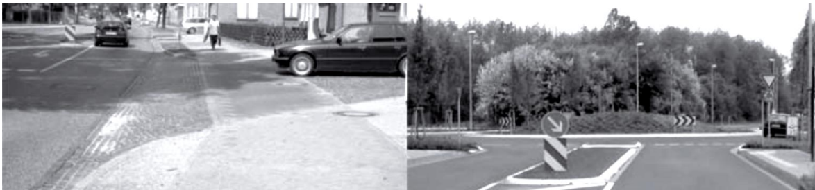
Abbildung 2-4 Gehwegüberfahrt (links) und nicht abgerückte Querungsanlagen (rechts). [5]
