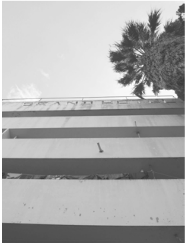
Abbildung 4.28. Bestand Dach und Fassade
