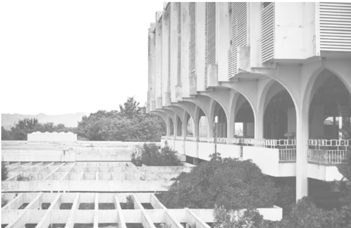
Abbildung 3.50. Detail Träger, Haludovo
