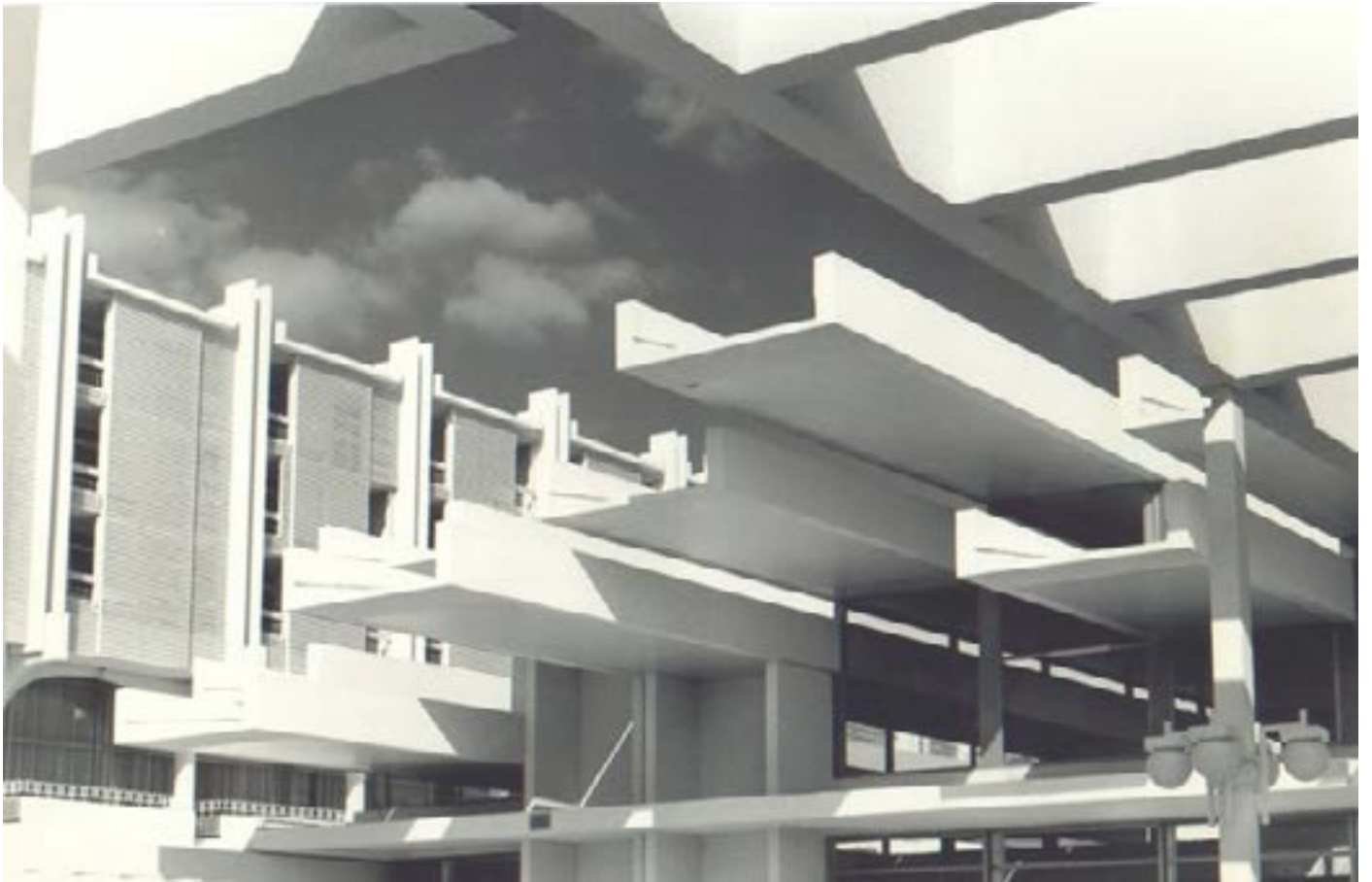
Abbildung 3.49. Detail Träger, Haludovo
