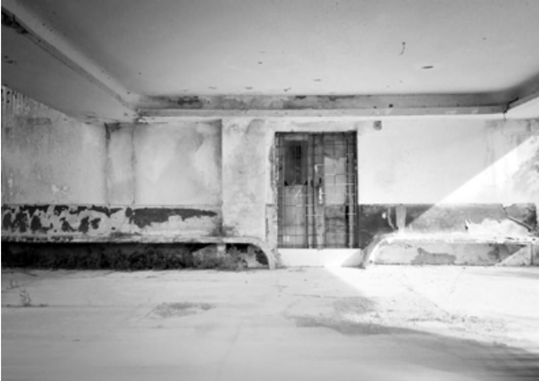
Abbildung 4.13. Sitzbank aus Stahlbeton
