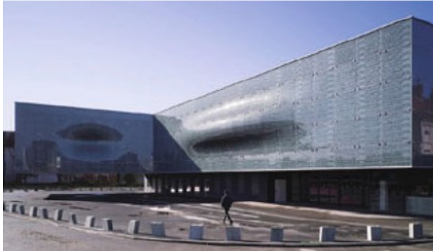
Abbildung 1: Fassade des Museums in Pas de Calais [2]
