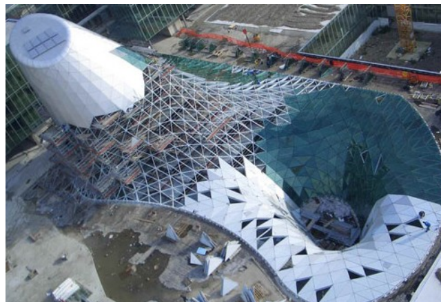
Abbildung 6: Luftaufnahme des Logo im Bauzustand [5]
