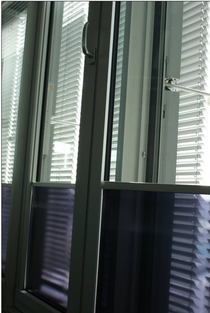
Abbildung 100: Blendschutz integriert in der Innere Fassade
