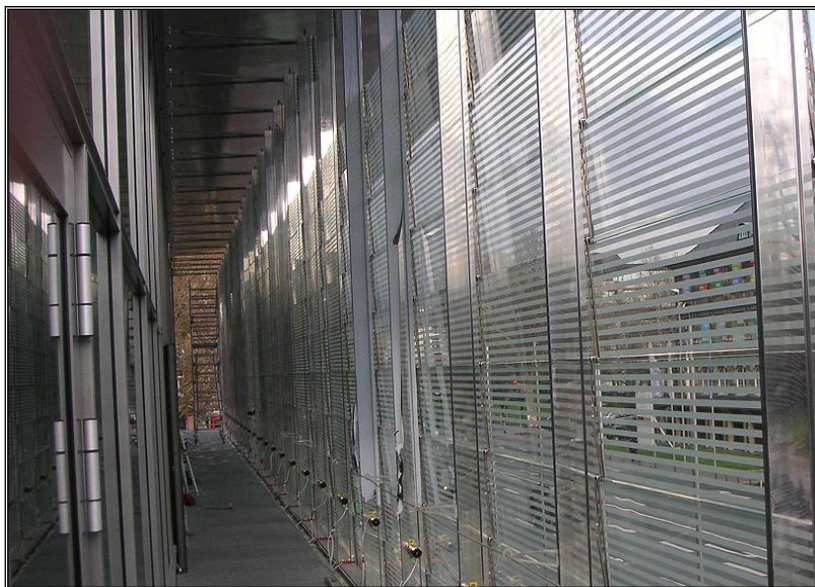
Abbildung 7: Zweit-Haut-Fassade mit Glaslamelle, /18/
