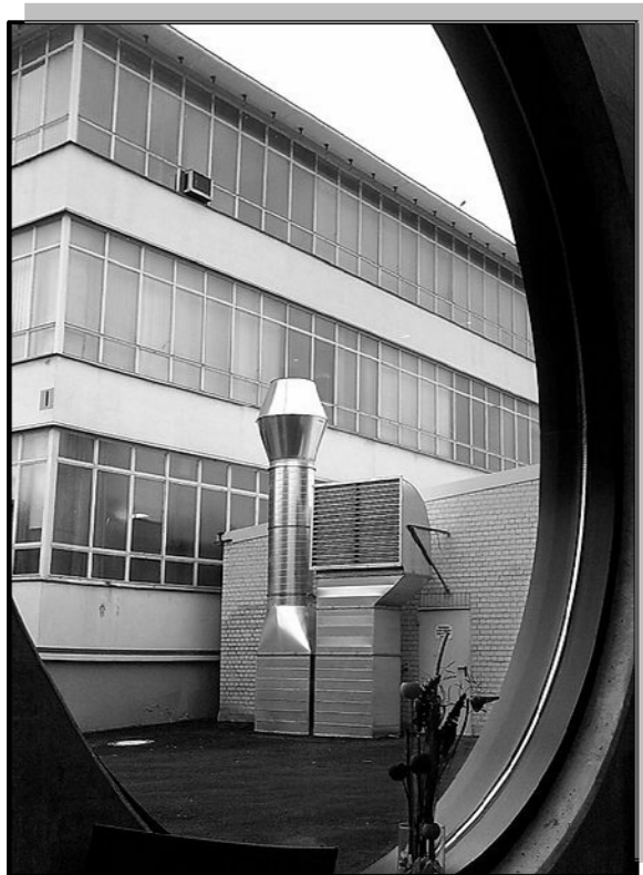
Abbildung 1: Glas-Fabrikhalle aus 1903, Blick aus der Cafeteria des Steiffmuseums auf eine der Produktionshallen, /7/
