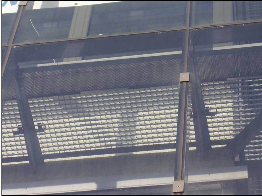
Abbildung 68: Begehbarer Gitterrost im Fassadenzwischenraum, bzw. Luftdurchgang zwischen den Geschossen
