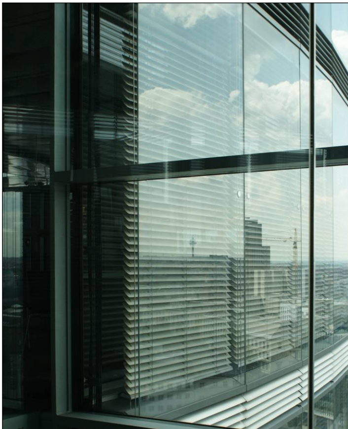
Abbildung 99: Sonnenschutzsystem- Jalousien zur Lichtlenkung
