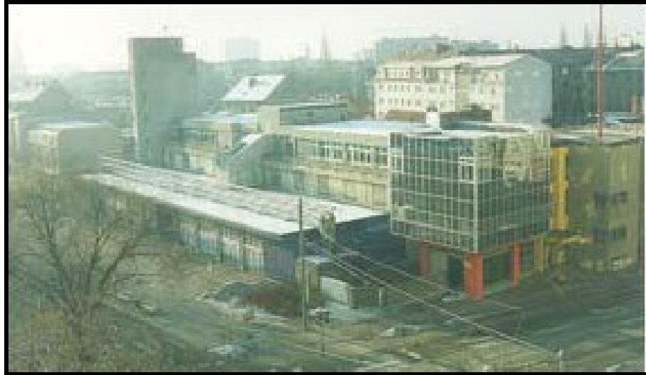
Abbildung 75: Bürogebäude der Feuerwehr /100/
