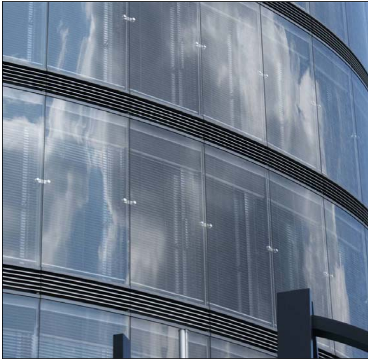
Abbildung 102: Fassadenansicht: Be- und Entlüftungsöffnungen
