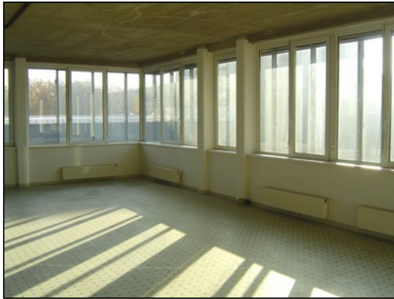
Abbildung 64: Innere Fassade (Primärfassade) /74/
