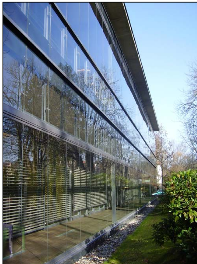
Abbildung 85: Fassadenteile: die Innere- und die Außenfassade, bzw. der Fassadenzwischenraum
