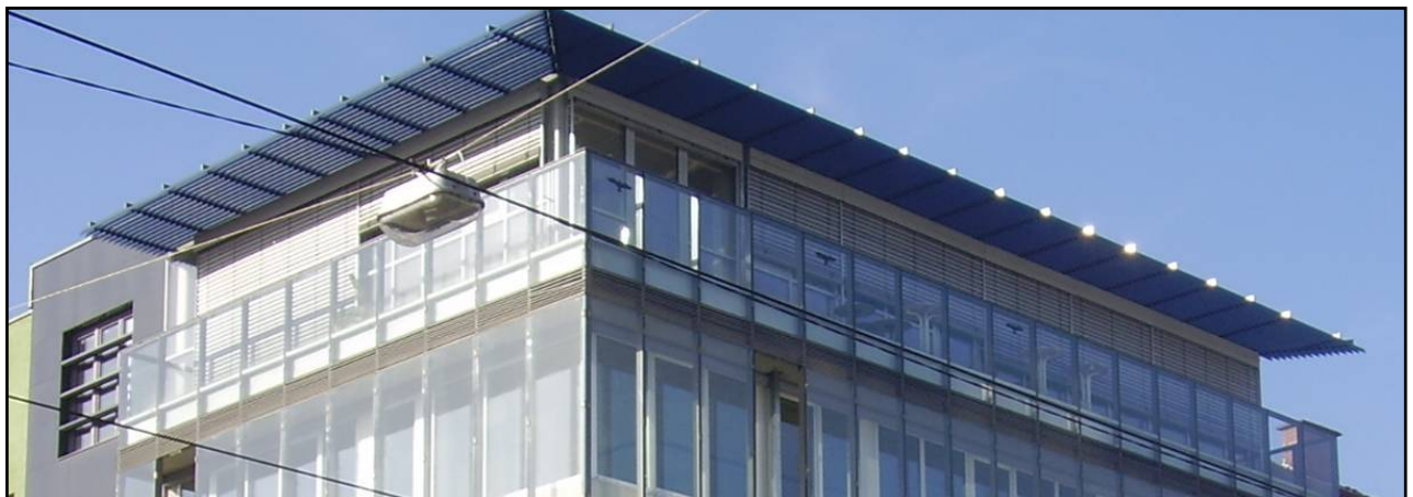
Abbildung 67: starrer Sonnenschutz-Dachvorsprung
