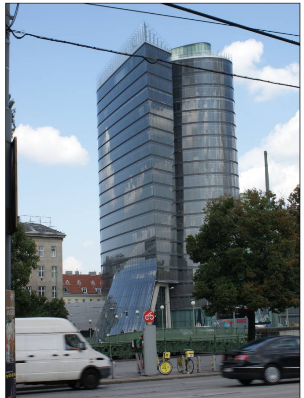
Abbildung 105: Die Straße vor dem Objekt
