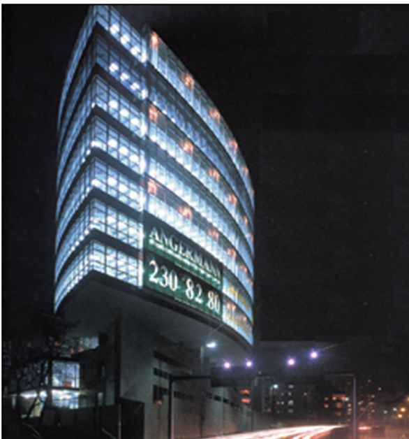
Abbildung 15: Bürogebäude am Halensee in Berlin, Arch.: Leon und Wohlhage, 1996 /9/
