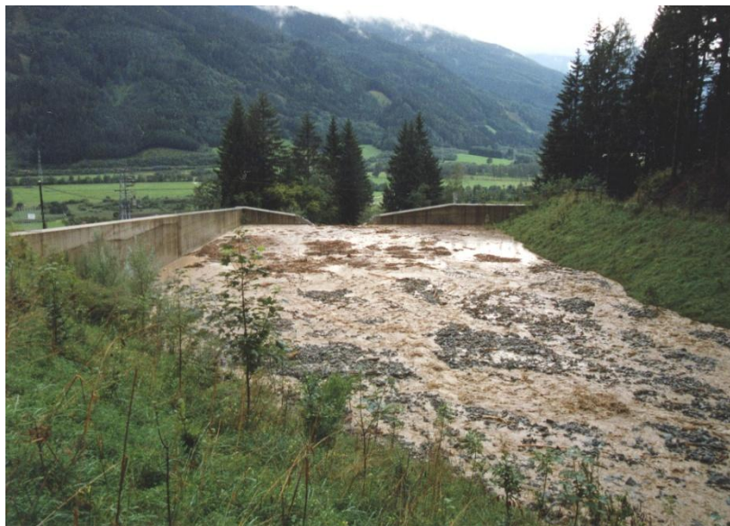
Abb. 14: Geschleibebecken der WLV in Funktion [4]
