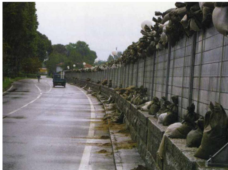
Abb. 25: Mobilelemente auf dafür vorgesehener Ufermauer ergänzt um zusätzliche Sandsäcke [87]
