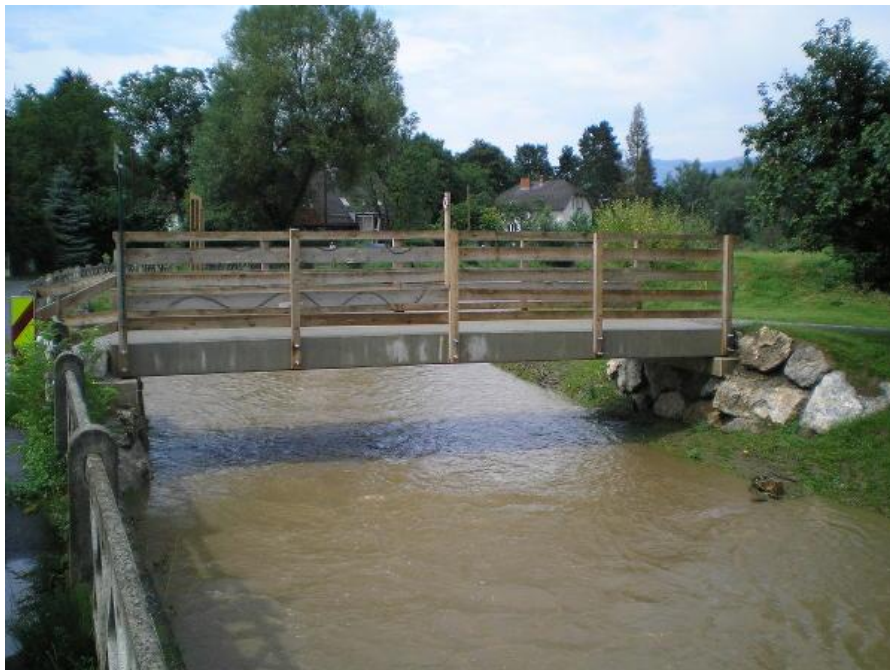
Abb. 63: Ausgebaute Bereiche zeigen Wirkung [47]
