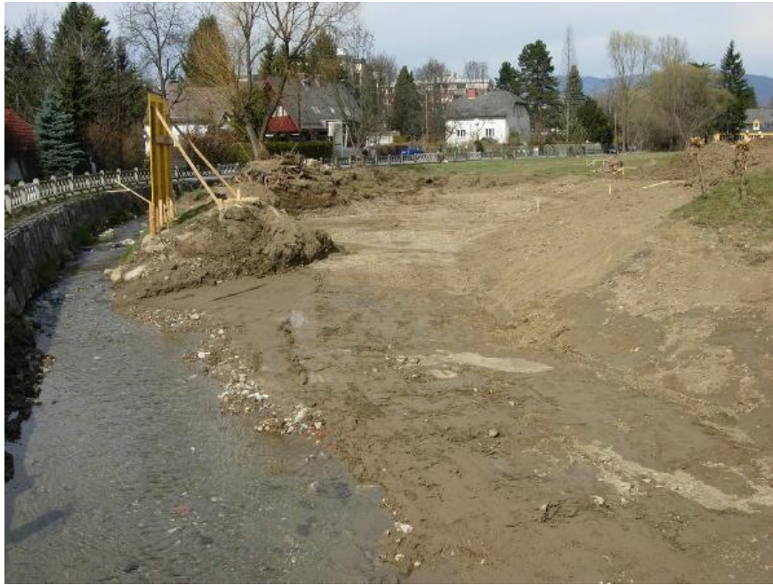
Abb. 62: Gerinneaufweitungen am Schöckelbach im Bereich Schöckelbachweg [47]
