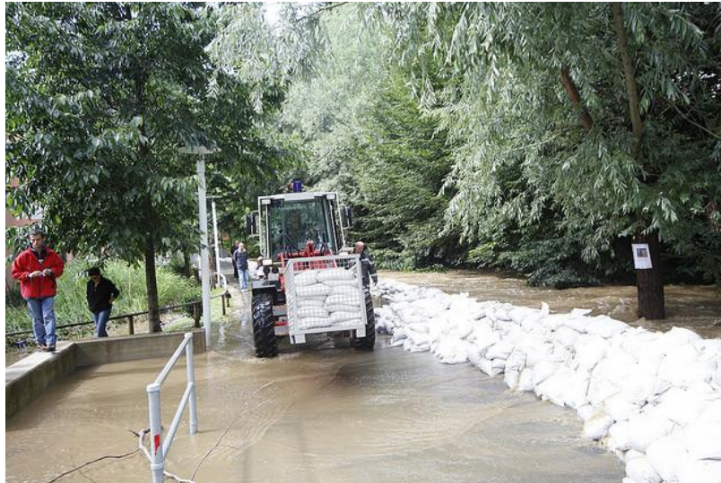
Abb. 19: Sandsackdamm in Graz-Andritz im Zuge des Hochwassers am 18. Juli 2009 [28]
