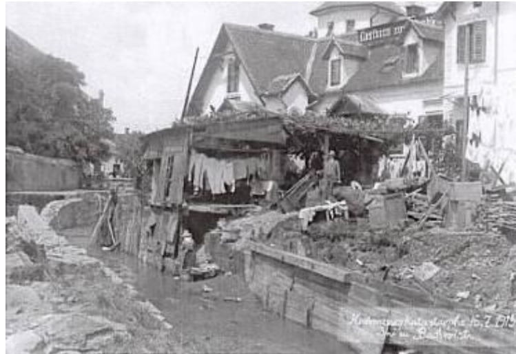
Abb. 5: Schwere Schäden nach einem Hochwasser am Leonhardbach im Jahr 1913 [52]
