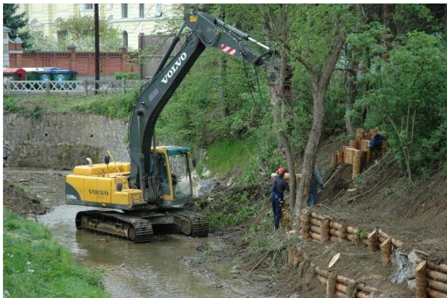
Abb. 64: Ufersanierungsarbeiten am Leonhardbach [85]
