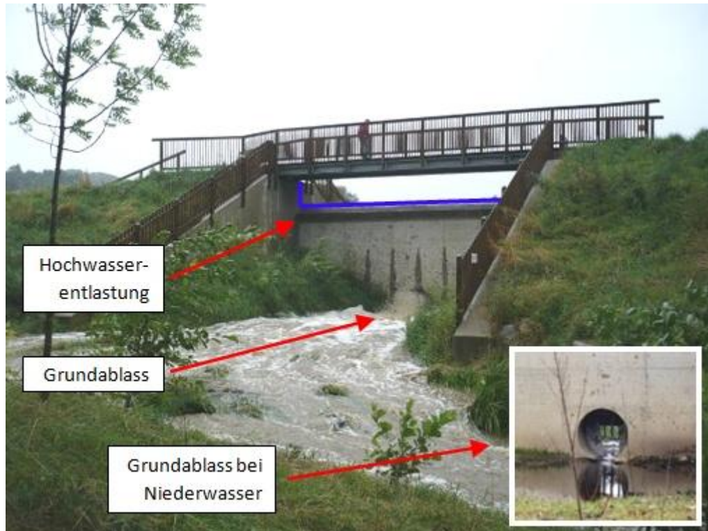
Abb. 58: Rückhaltebecken am Gabriachbach im Zuge eines Hochwasserereignisses im Juli 2009 [46] [3]
