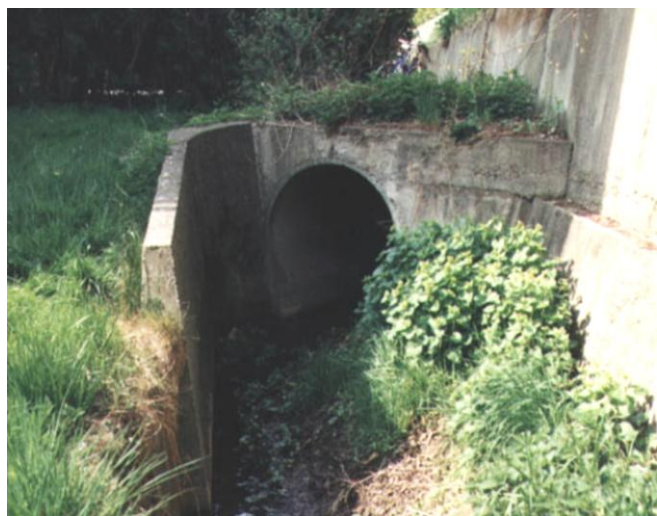
Abb. 48: Hydraulisch ungünstiger Durchlasseinlauf [54]
