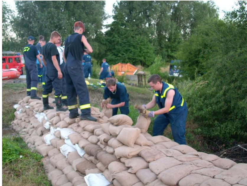
Abb. 20: Errichtung eines Sandsackdammes zur Löschwasserrückhaltung [90]
