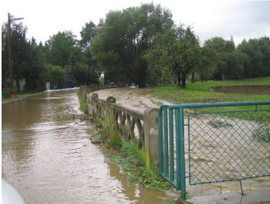
Abb. 31: Hochwasserabfluss am Schöckelbach, Höhe Schöckelbachweg Nr. 13, bachaufwärts [82]
