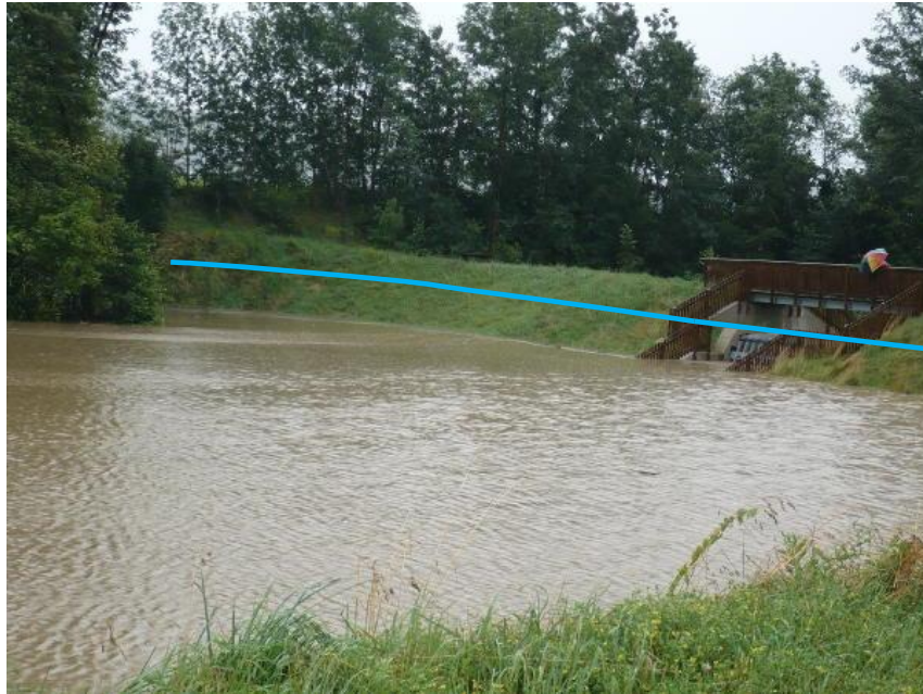
Abb. 59: Teilgefülltes Hochwasserrückhaltebecken am Gabriachbach, Hochwasser im Juli 2009 [46]
