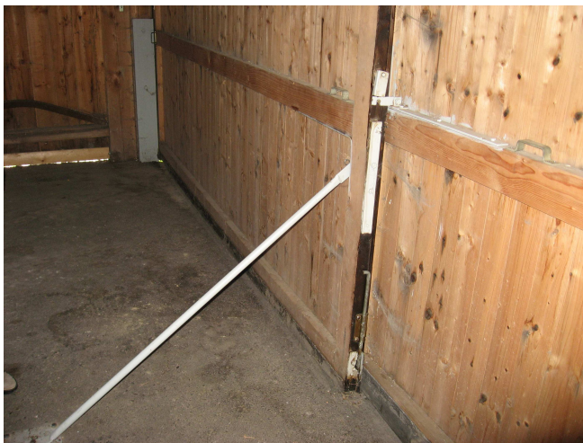
(a) Verstärkte Sicherung großer Tore gegen Winddruck
