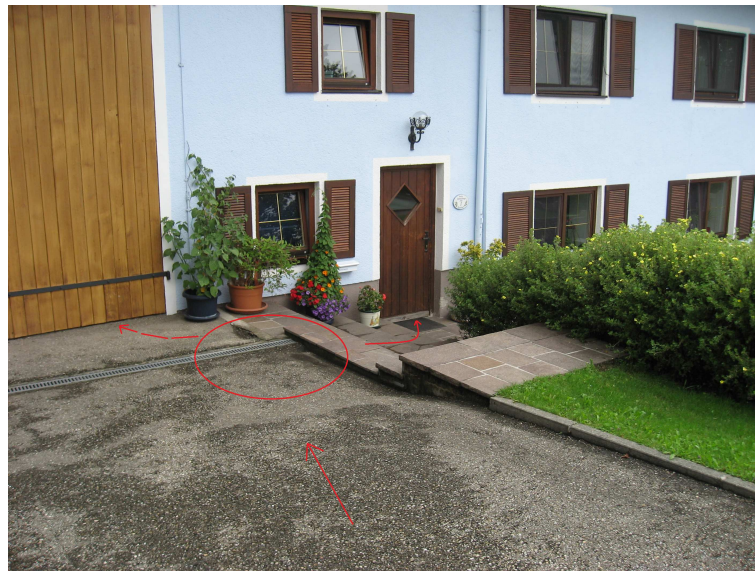
Abbildung 43: Wassereintritt ins Wohngebäude und oder Garage bei Verstopfung der Gitterrinne (Rigol) durch angeschwemmten Hagel, Unrat, etc.
