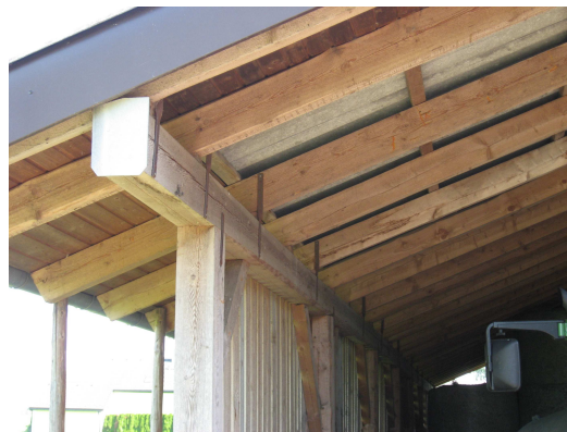
(b) Mögliche Ausführung einer Ständerbausicherung
