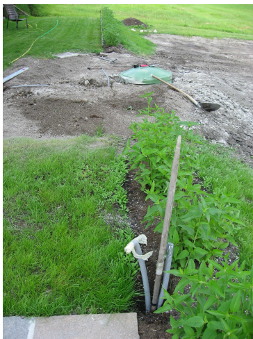
(a) Pelletstank mit 11m 3 Fassungsvermögen nach dem Einbau im Herbst
