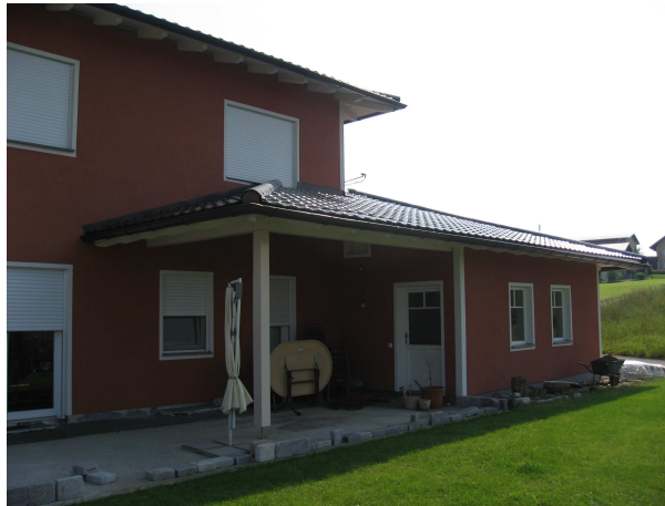
Abbildung 34: Staudruck unter dem Vordach, da der Wind nicht entweichen kann
