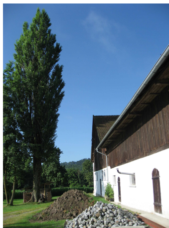
Abbildung 22: Zu geringer Abstand zwischen Bewuchs und Gebäude.
