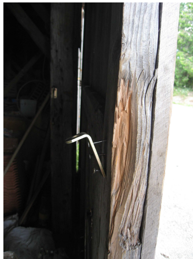
Abbildung 28: Durch Wind ausgeschlagene Türverankerungen
