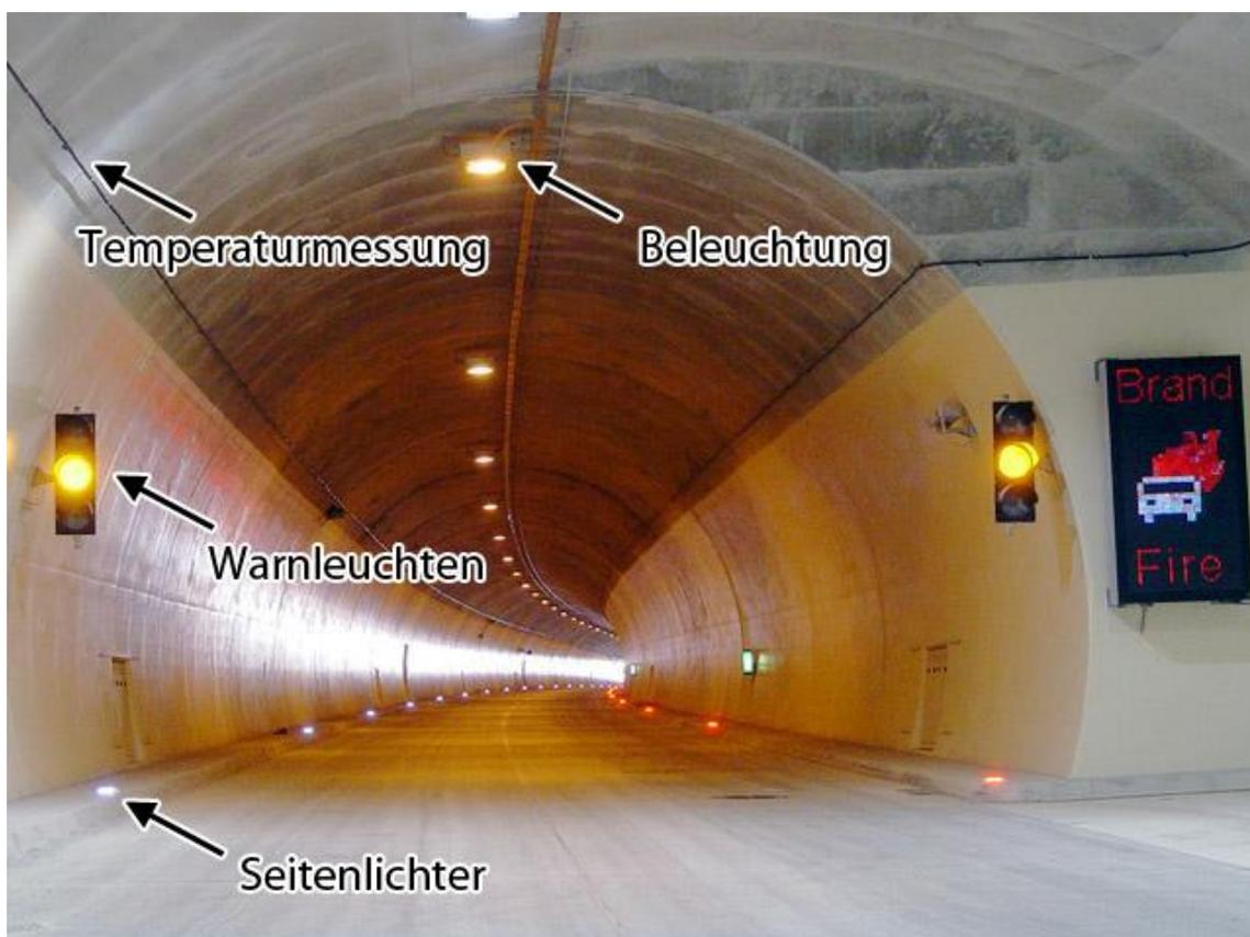
Abbildung 14: Signalelemente Autobahntunnel<sup>45</sup>
