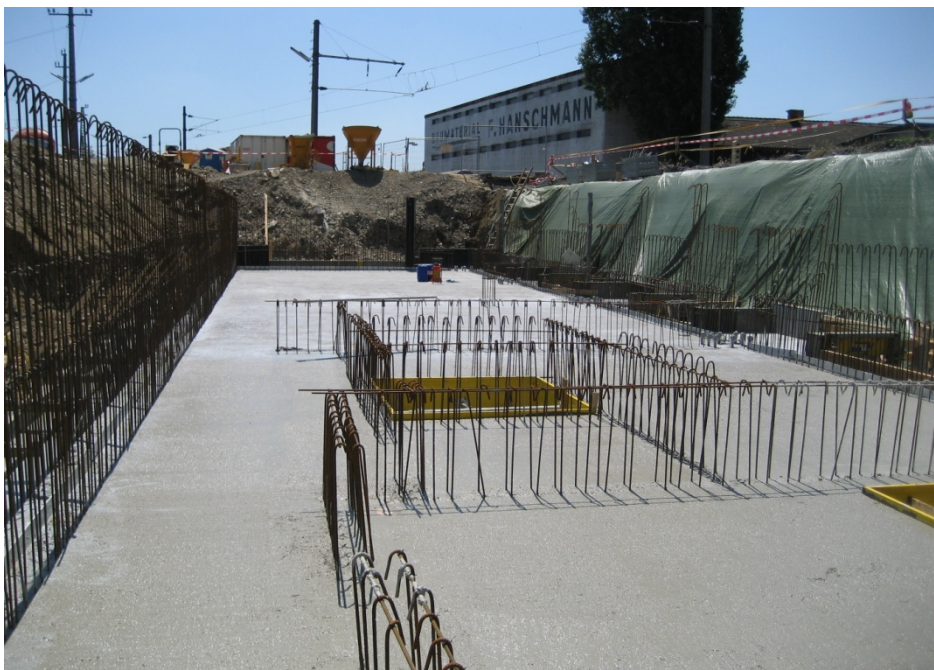
Abb. 9: Anschlussbewehrung für die Wände des Kellergeschosses, Projekt ÖBB-Traktion 60
