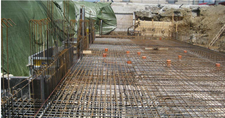
Abb. 7: Schlaaffe Bewehrung der Bodenplatte, Projekt ÖBB-Traktion 56
