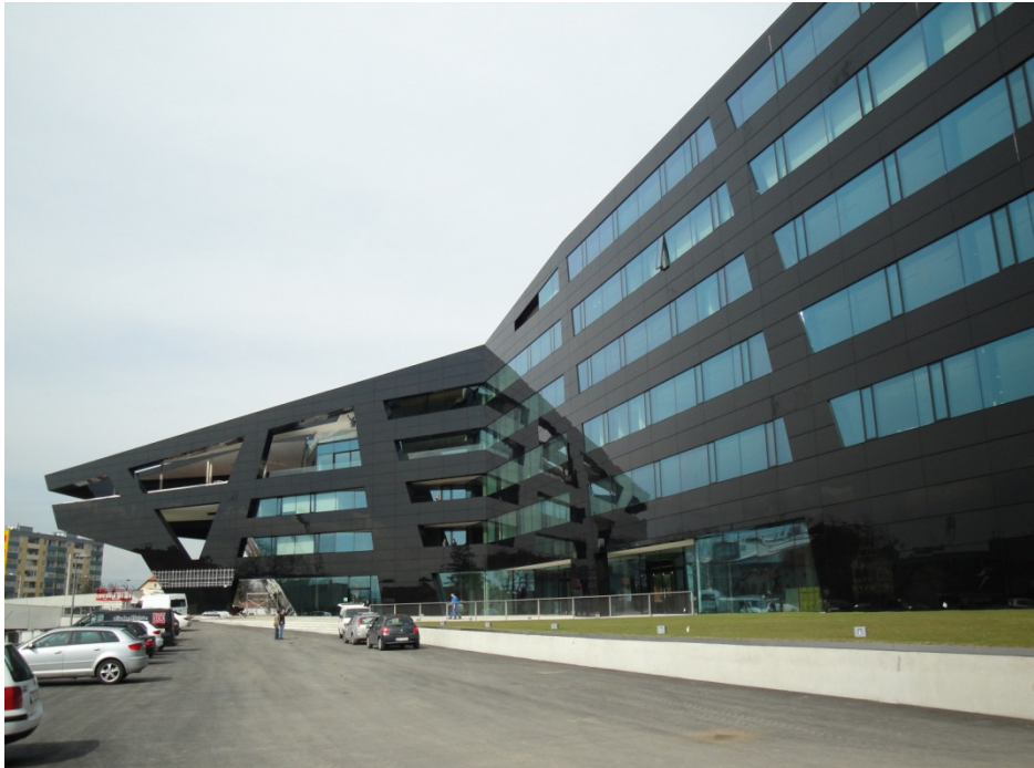
Abb. 27: Südwestansicht vom Headquarter der UNIOPT Pachleitner Gruppe 344
