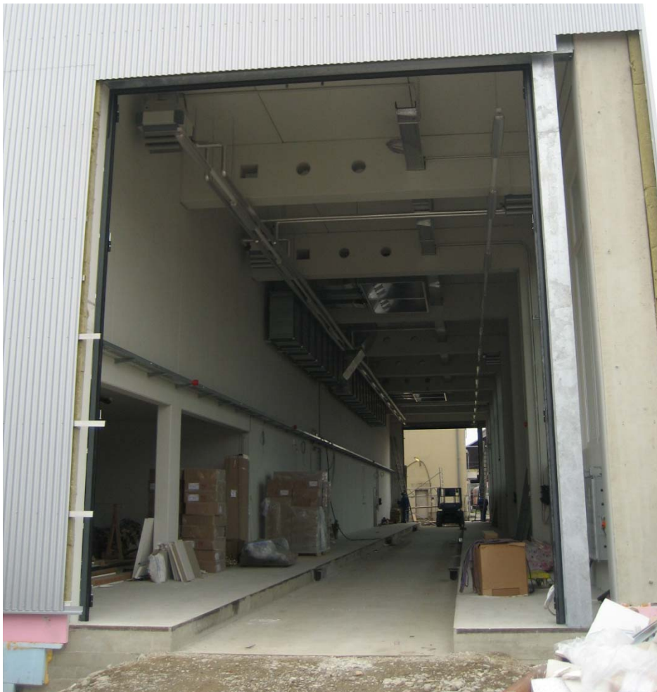
Abb. 33: Südseitige Halleneinfahrt (während der Bauphase) der ÖBB-Traktion 351
