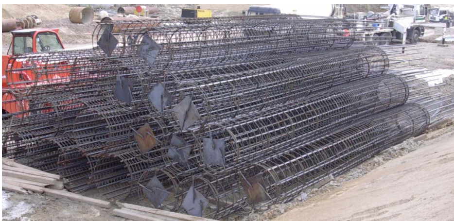
Abb. 8: Vorgefertigte Bewehrungskörbe für Bohrpfähle 58
