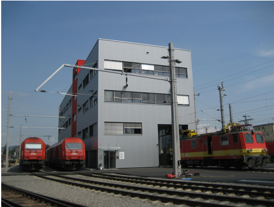
Abb. 32: Südwestansicht der ÖBB-Traktion 350
