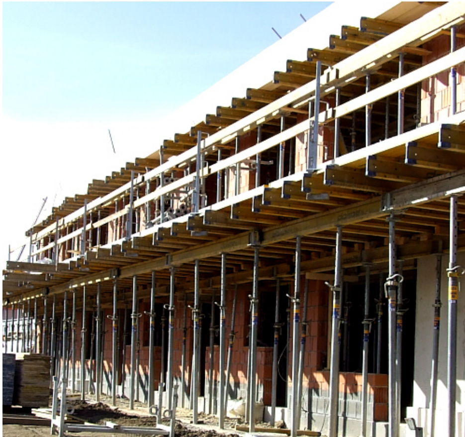
Abb. 6: Flexible Deckenschalung (Trägerschalung) am Beispiel von Haus 26 der Gartenstadt Marland 50
