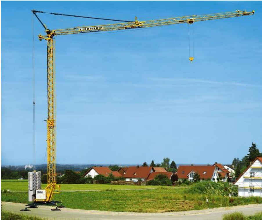
Abbildung 21: Turmdrehkran Liebherr 26 K 209
