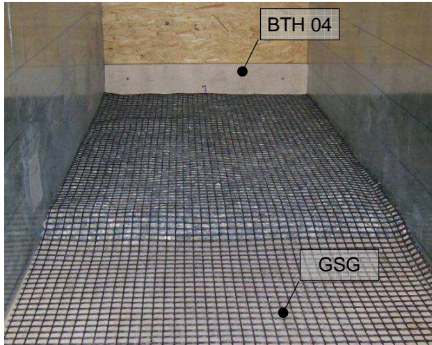
Abb. 5. 2 Geokunststoffgitter auf der Bodenschüttlage
