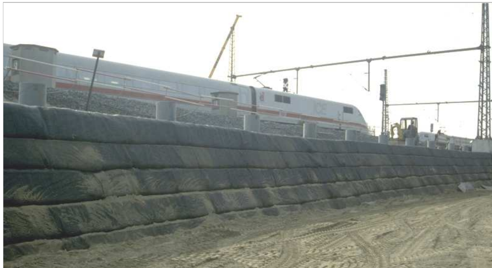
Abb. 1. 13 Geokunststoff im Eisenbahndammbau [7]
