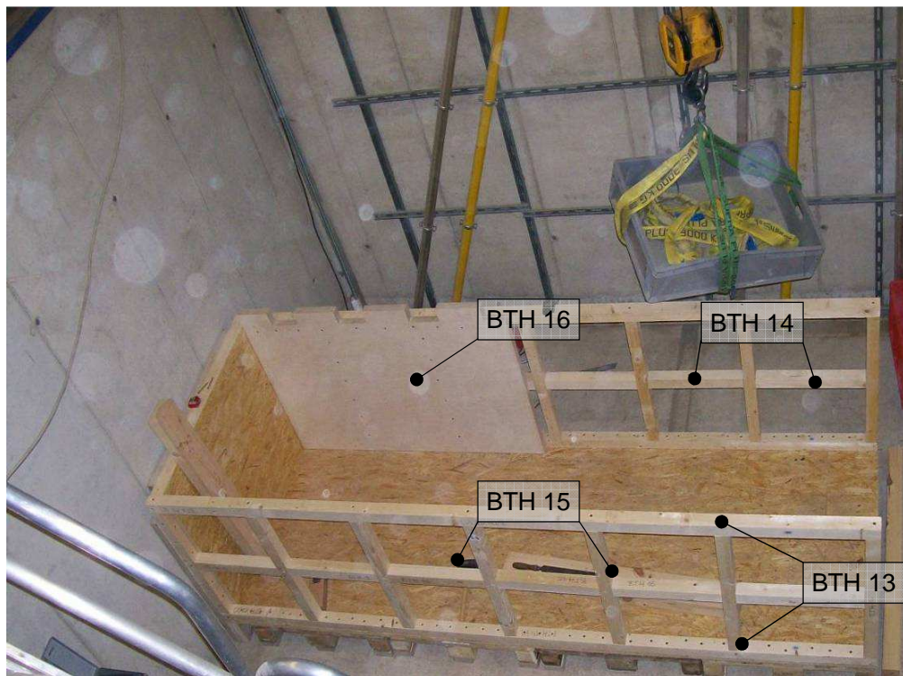
Abb. 3. 5 Seitenwände der Holzkonstruktion
