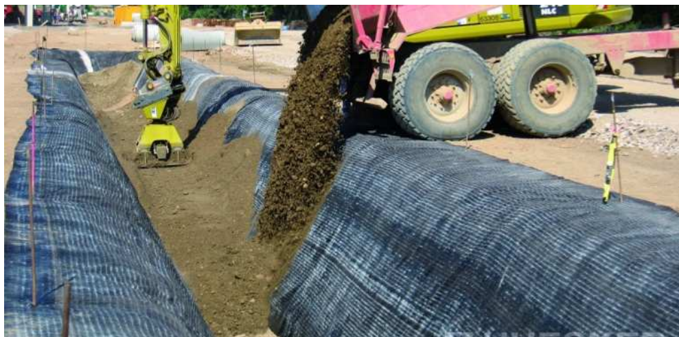
Abb. 1. 4 Sammeln und abführen des Sickerwassers [6]
