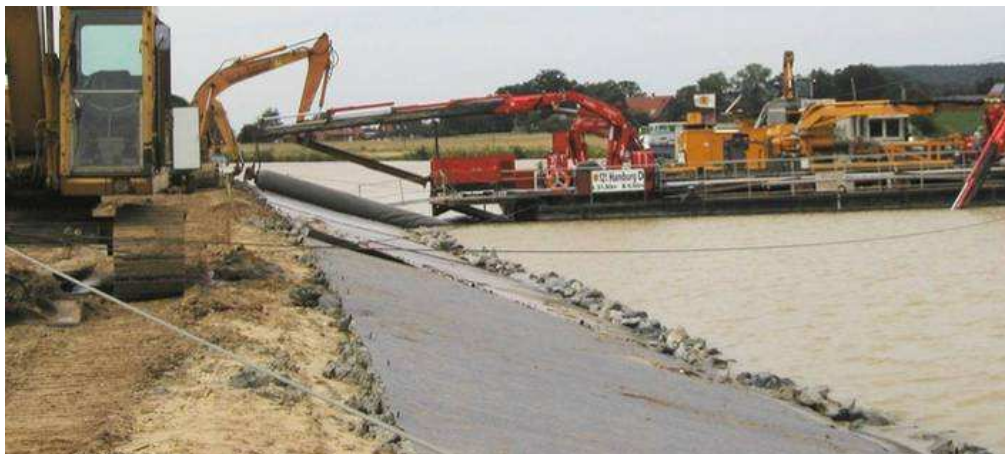
Abb. 1. 3 Geokunststoff als Filtrationsmaterial [7]
