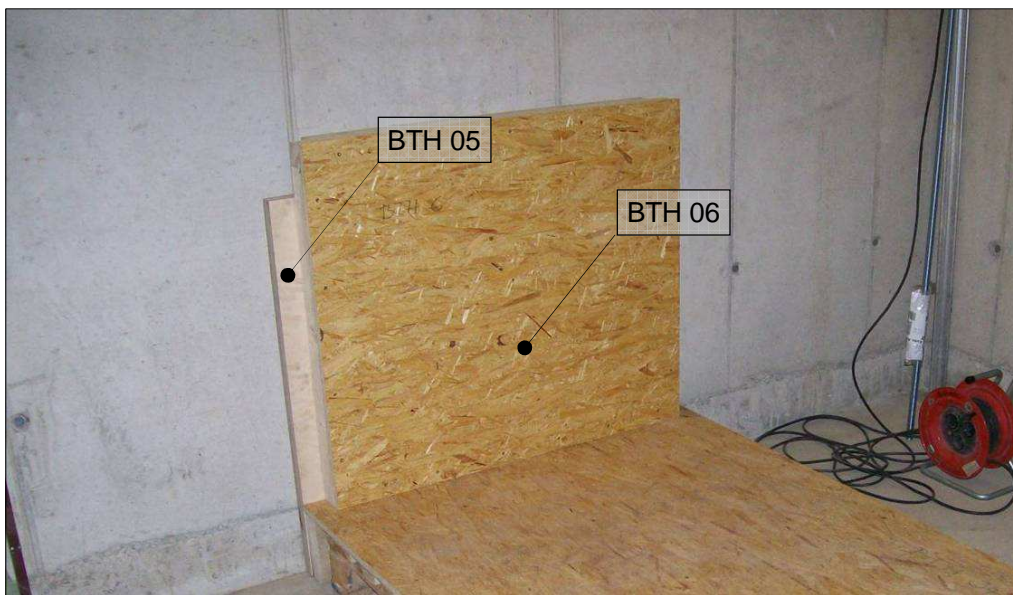
Abb. 3. 4 Außen- und Innenstirnwand der Holzkonstruktion
