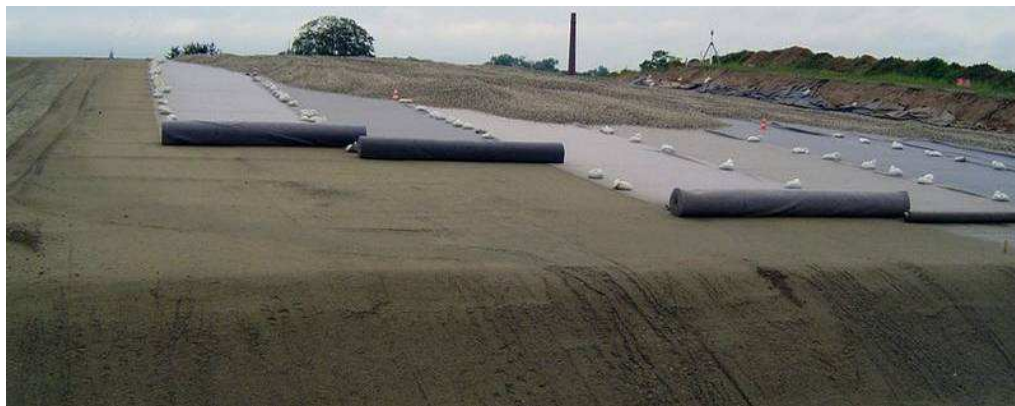
Abb. 1. 11 Schutzfunktion einer Böschung gegen Erosion [7]
