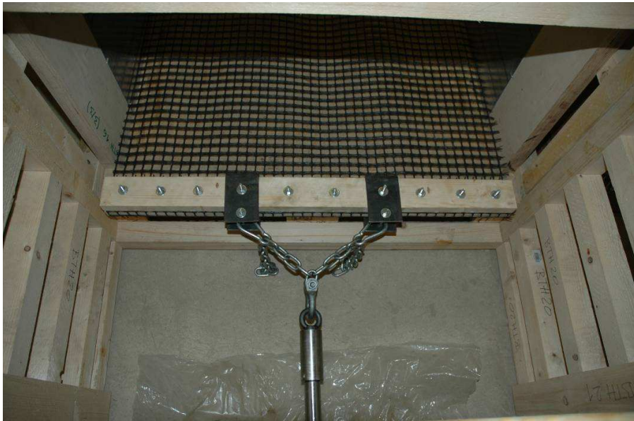
Abb. 11.4 Vorspannung des Geokunststoffgitter
