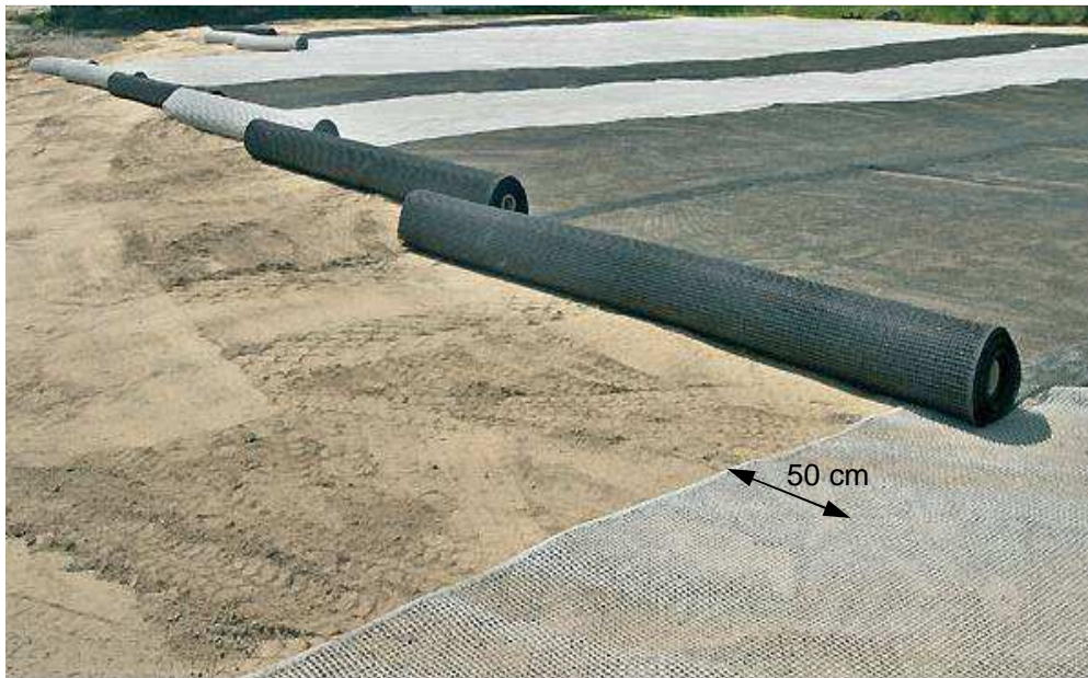
Abb. 1. 2 Überlappung der Geokunststoffbahnen [11]
