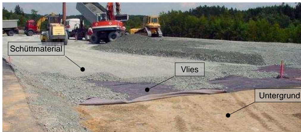
Abb. 1. 1 Trennung zwischen Untergrund und Schüttmaterial [7]
