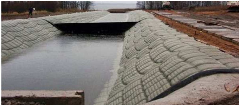
Abb. 1. 10 Schutzfunktion einer Abdichtung [7]
