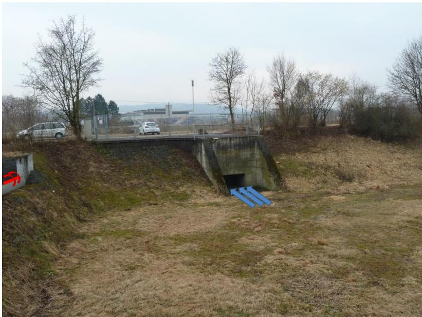
**Abbildung 2-6: Mischwasserrückhaltebecken Weikerlsee-Becken 3**
