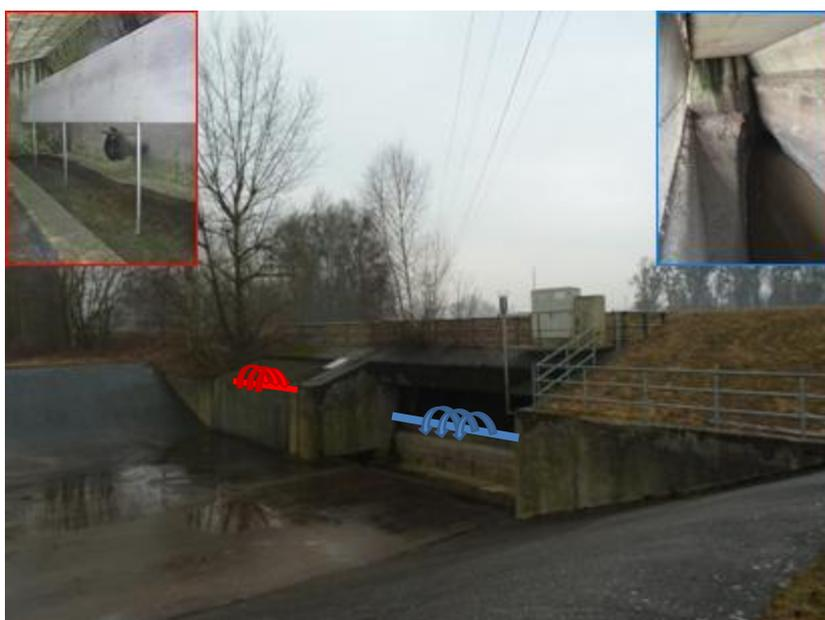
**Abbildung 2-4: Mischwasserüberlaufbecken Plesching\_2**
