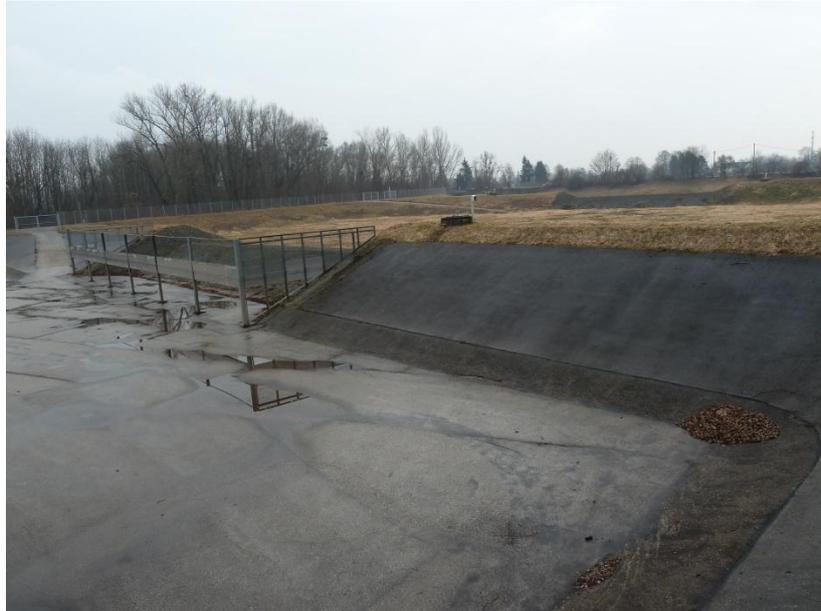
**Abbildung 2-5: Mischwasserrückhaltebecken Weikerlsee-Becken 1**
