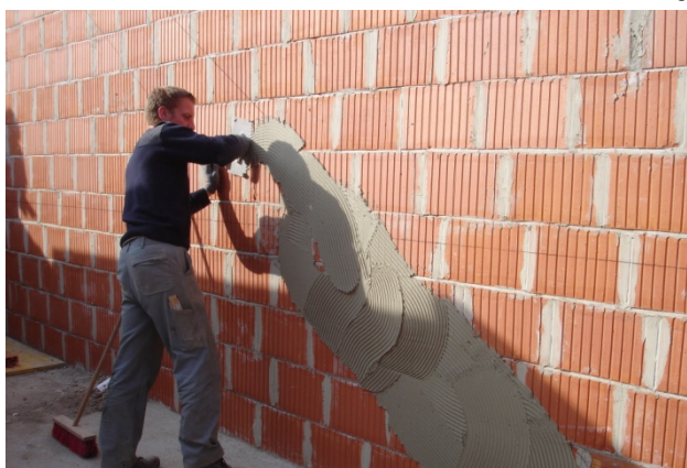
Abb. 3-41: Spachtelung der Stiegenwange bevor die Stiege betoniert wird, [3]
