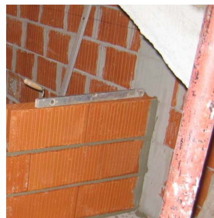
Abb. 3-40: Spachtelung für einen luftdichten Innenwandanschlusses, [3]
