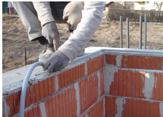
Abb. 3-46: Einlegen der Deckendichtschnur, [3]
