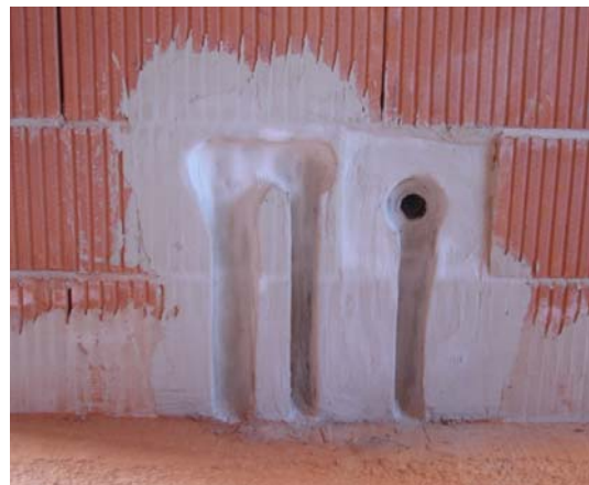
Abb. 3-45: Installationsschlitzte müssen verspachtelt werden, [3]
