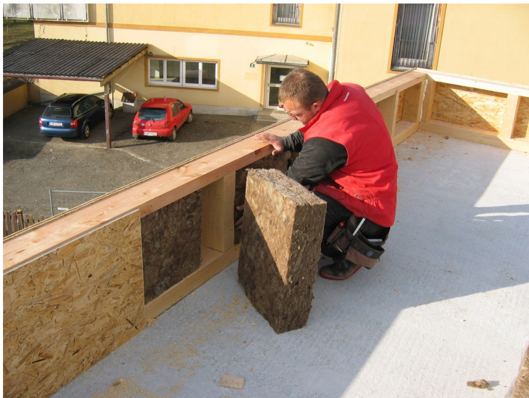
Abb. 3-48: Montage der Attika beim Passivhaus Singer, [3]
