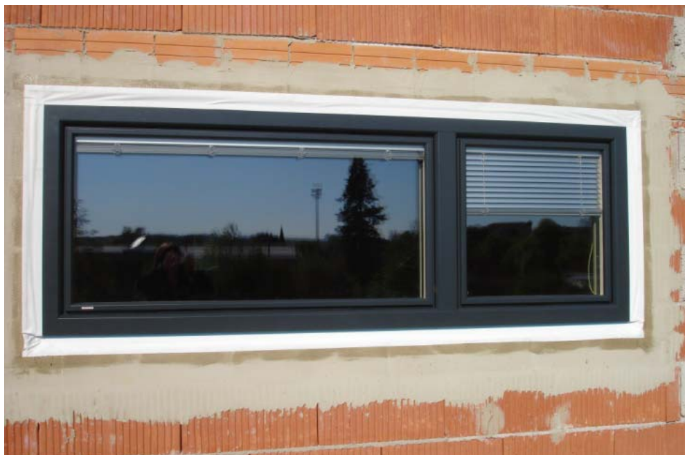
Abb. 3-43: äußerer Fensteranschluss verklebt, [3]
