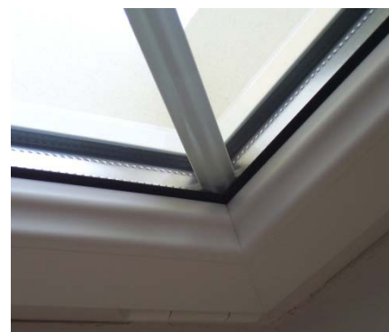
Abb. 3-28: Sprossen im Scheibenzwischenraum.
