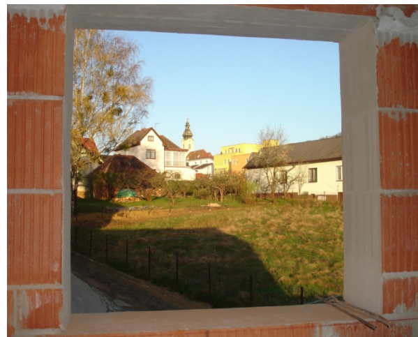
Abb. 3-39: Spachtelung der Fenstersturz-, Fensterparapett- und Fensterlaibungsfläche, [3]
