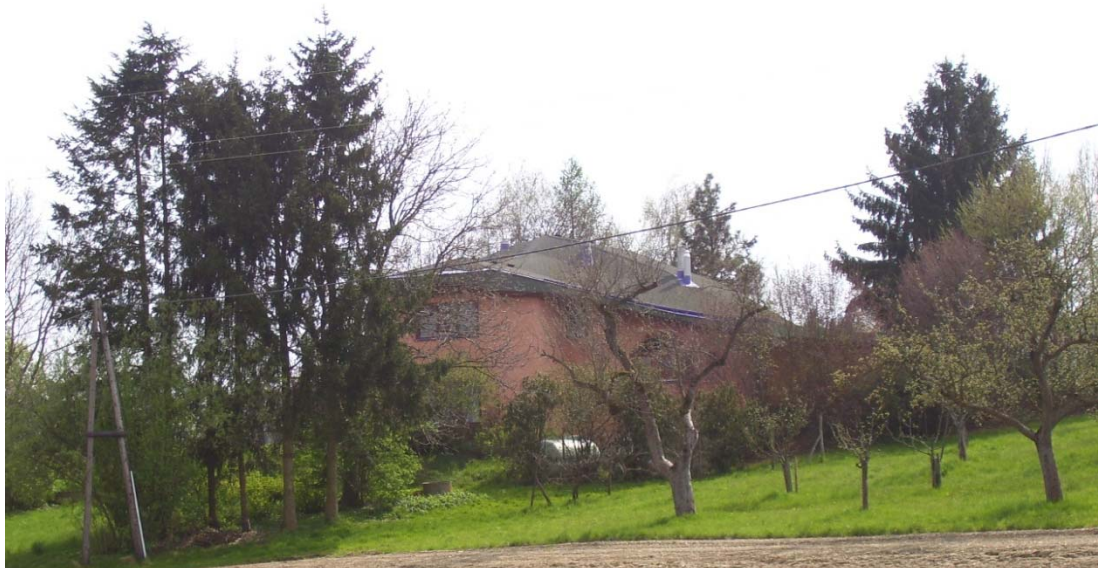
Abb. 3-11: Das Gebäude aus der Südsteiermark wurde leicht in den Hang gebaut, hat eine Windschutzbepflanzung auf der Luvseite und hat zusätzlich noch eine windschlüpfrige bzw. aerodynamische Gebäudehülle. Damit sind drei sehr gute windschutztechnische Prinzipien eingehalten worden.
