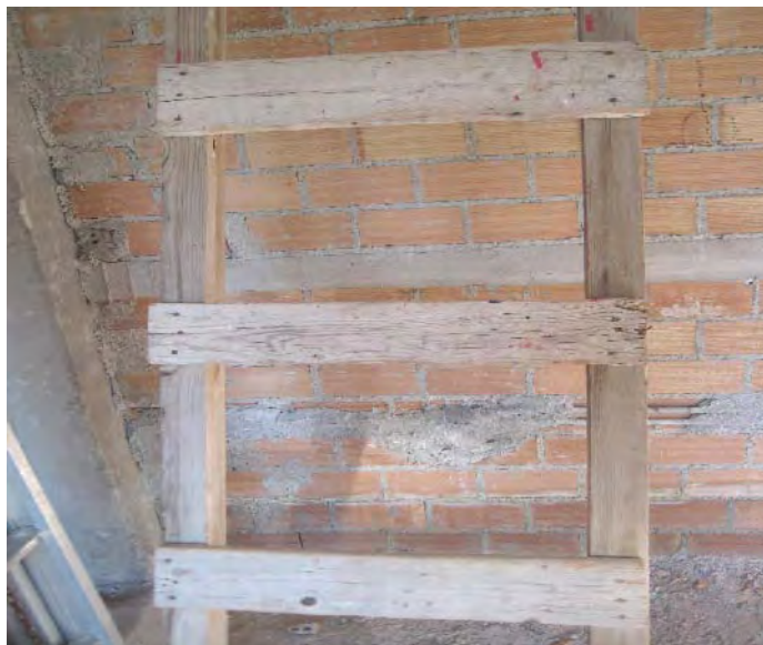
Abb. 27b: Baustelle Peloponnes, Kalonero, Nahaufnahme der Leiter
