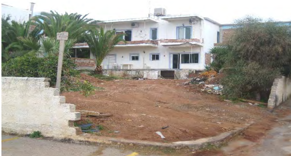
Abb. 24: Baustelle Peloponnes, Kalonero, Eingang
