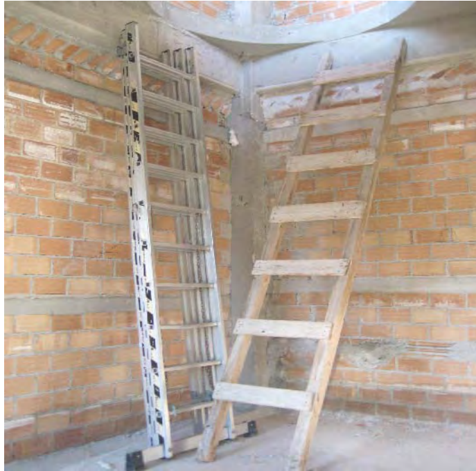
Abb. 27a: Baustelle Peloponnes, Kalonero, Leiter
