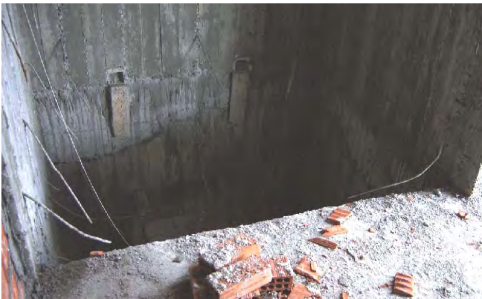
Abb. 20 b: Baustelle Athen, Bezirk Vouliagmeni, Schacht
