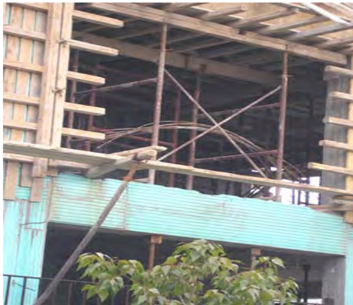
Abb.22: Baustelle Athen, Bezirk Melissia, Bauobjekt
