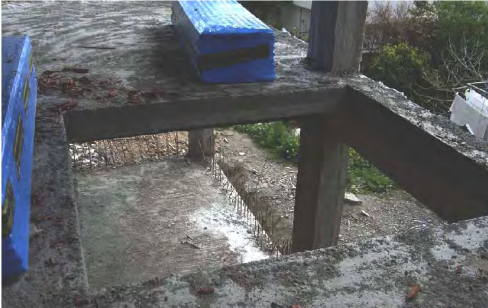
Abb. 20 a: Baustelle Athen, Bezirk Vouliagmeni, Deckenöffnung
