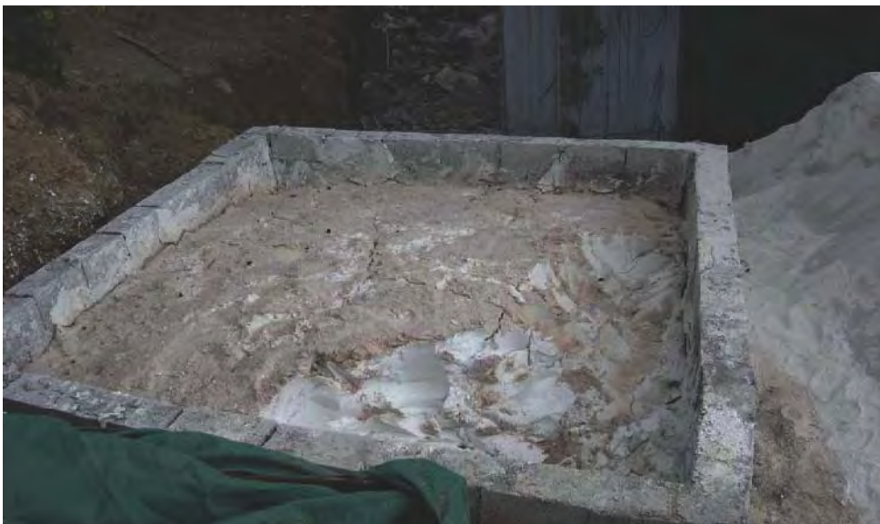
Abb. 18 d : Baustelle Athen, Bezirk Vouliagmeni, Materialien
