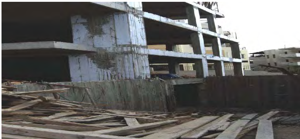
Abb. 16 a: Baustelle Athen, Bezirk Vouliagmeni, Bauobjekt
