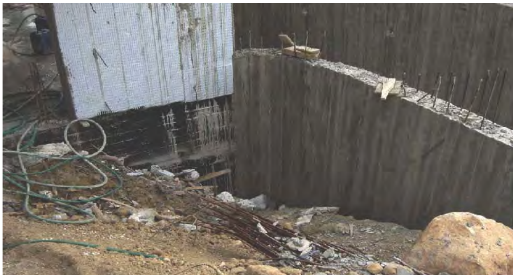
Abb. 21: Baustelle Athen, Bezirk Vouliagmeni, Kellereingang
