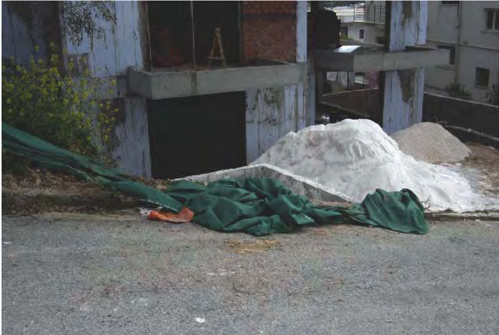
Abb. 18 c: Baustelle Athen, Bezirk Vouliagmeni, Bauobjekt
