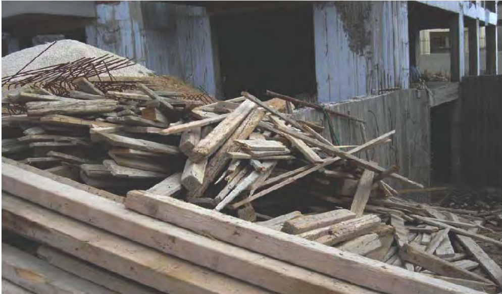
Abb. 16 b: Baustelle Athen, Bezirk Vouliagmeni, Zugang zum Bauobjekt
