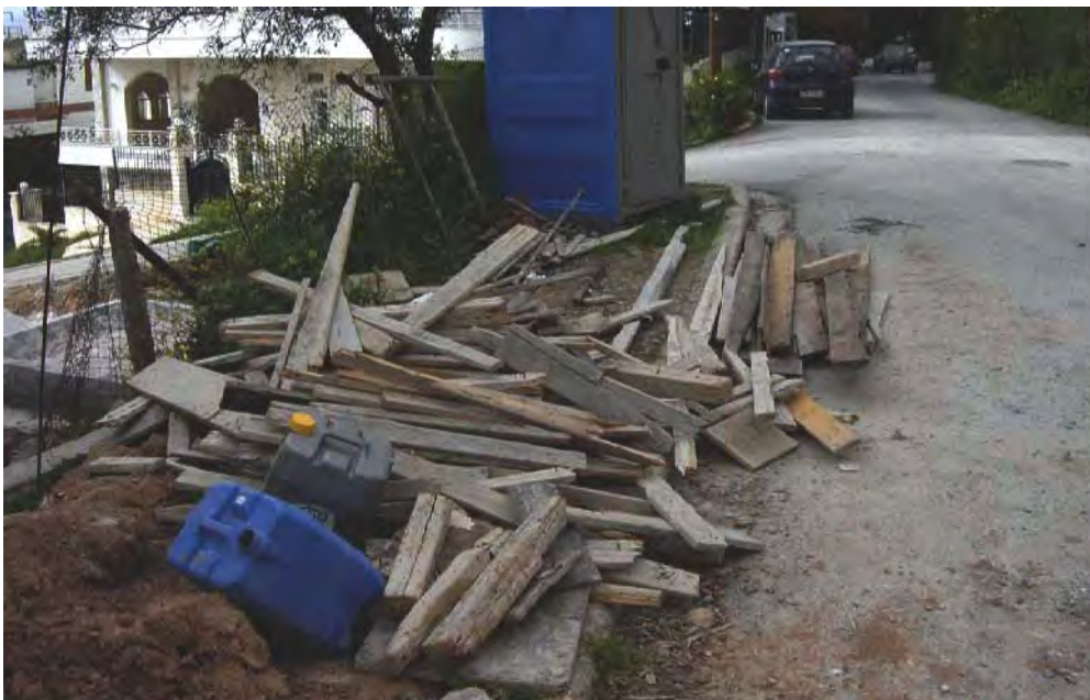
Abb. 18 b: Baustelle Athen, Bezirk Vouliagmeni, Strasse
