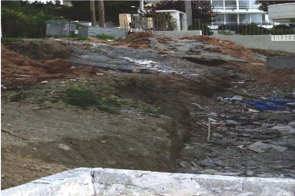
Abb. 18 a: Baustelle Athen, Bezirk Vouliagmeni, Baugelände
