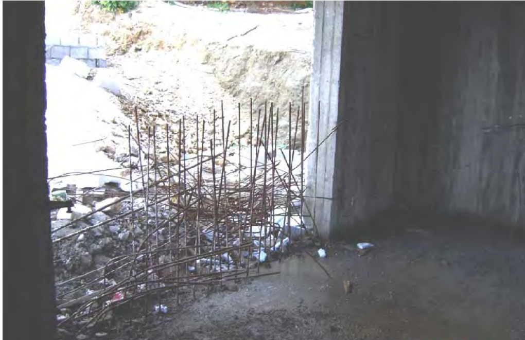
Abb. 20 c: Baustelle Athen, Bezirk Vouliagmeni, Bewehrungsstäbe
