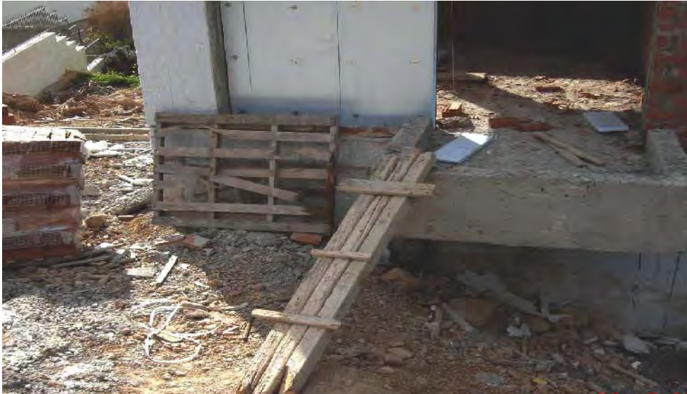
Abb. 17: Baustelle Athen, Bezirk Vouliagmeni, Leiter
