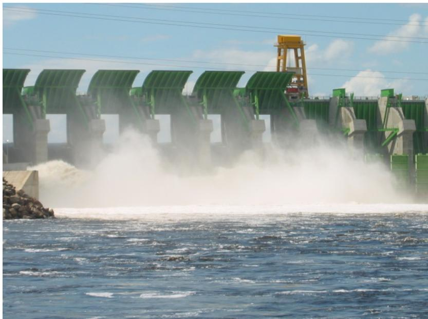
Abb. 4: eingebaute Radialschütze im geöffneten Zustand [22]
