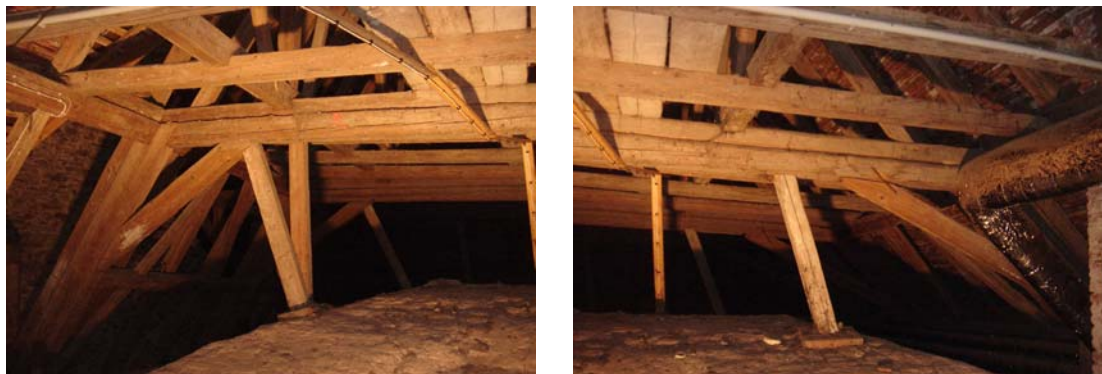
Abb. 5.33: Abstützung auf Gewölbe: Osten (links), Westen (rechts)
