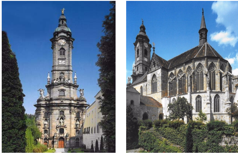
Abb. 1.3: Die Kirche des Stiftes Zwettl: links Westansicht, rechts Südostansicht [44]
