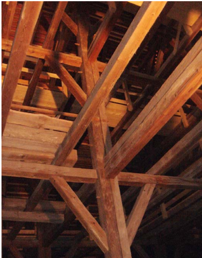
Abb. 5.59: Zweigeteilte Stütze mit Kopfbändern
