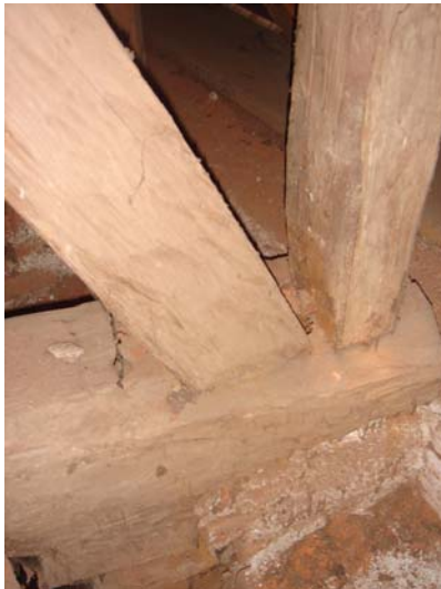
Abb. 11.4: Geschädigter Sparrenfuß: visuell nicht erkennbar (links), erkennbar (rechts) (siehe Abb. 11.1)
