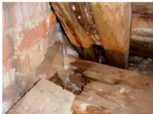
Abb. 5.5: Rissbildung im südöstlichen Turm (siehe Abb. 5.2) (links), vermorschte Mauerbank (rechts)
