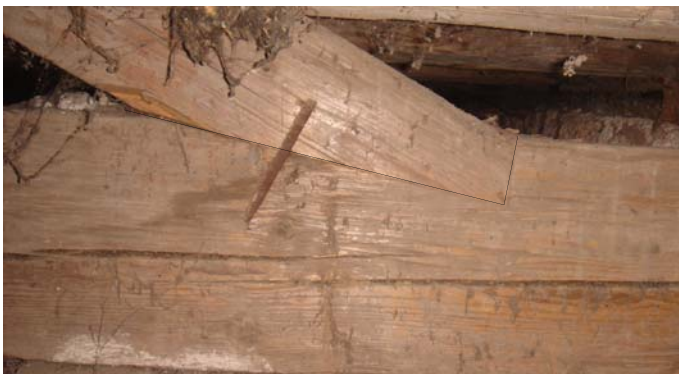
Abb. 5.13: Versatz im Hängewerk (links), Querszugversagen des zu geringen Vorholzes (rechts)
