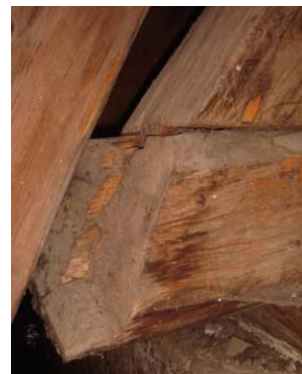
Abb. 5.13: Versatz im Hängewerk (links), Querszugversagen des zu geringen Vorholzes (rechts)
