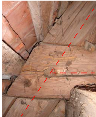
Abb. 10.4: Sparren-Kehlbalkenanschluss
