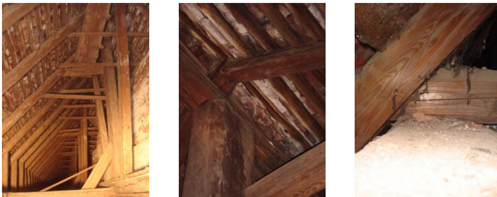
Abb. 5.18: Firstbereich (links, Mitte), Sparren/Kehlbalken/Rähm (rechts)
