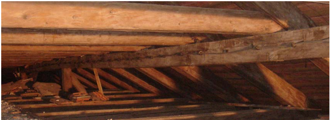
Abb. 5.28: verformtes Rähm
