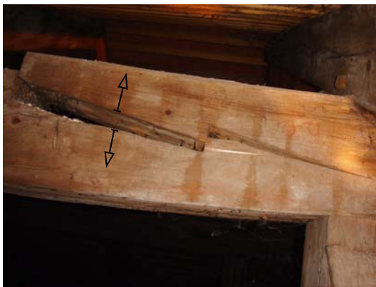
Abb. 5.29: klaffende Rähmverbindung (links), SP/BT-Anschluss
