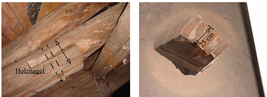
Abb. 5.20: Sparrenverlängerung (links), Gewölbeaussparung (rechts)
