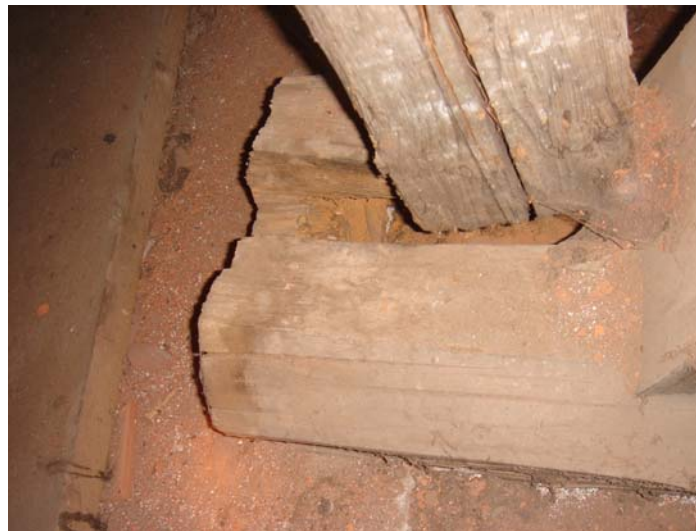
Abb. 11.4: Geschädigter Sparrenfuß: visuell nicht erkennbar (links), erkennbar (rechts) (siehe Abb. 11.1)
