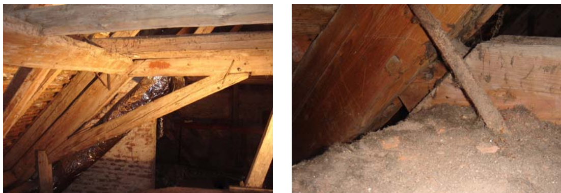
Abb. 5.34: lange Kopfbänder mit Klammer (links), offene Verbindung mit Klammer (rechts)
