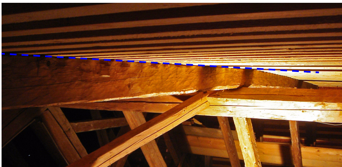
Abb. 5.47: Verformter Sparren
