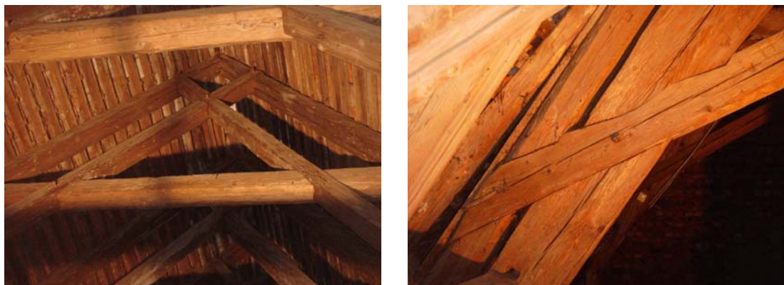
Abb. 5.49: Schwertstreben (links), Kopfbandanschluss (rechts)
