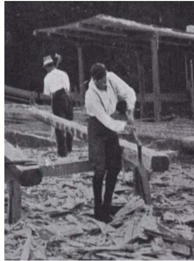
Abb. 3.1: Beschlagen der Kerben (links), Bearbeiten mit Axt (rechts)
