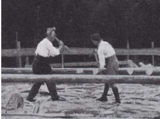
Abb. 3.1: Beschlagen der Kerben (links), Bearbeiten mit Axt (rechts)
