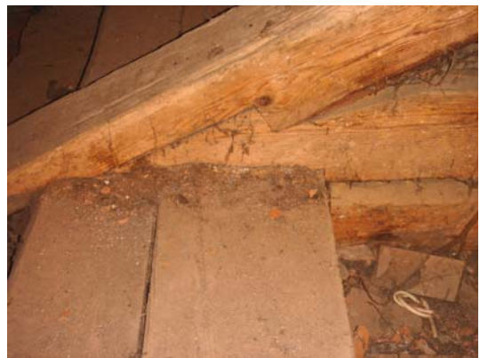
Abb. 5.29: klaffende Rähmverbindung (links), SP/BT-Anschluss
