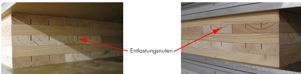
Abb. 2.6 Entlastungsnuten (Fotos: holz.bau forschungs gmbh)
