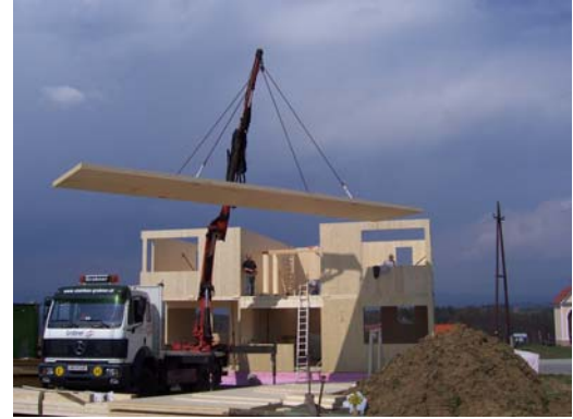
Abb. 5.1 Montage eines Einfamilienhauses in BSP (Fotos: holz.bau forschungs gmbh)
