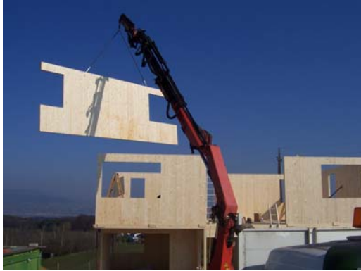
Abb. 5.1 Montage eines Einfamilienhauses in BSP (Fotos: holz.bau forschungs gmbh)
