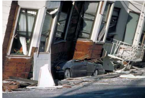
Abb. 3.1 links: Loma Prieta Erdbeben 1989 Kalifornien [50] rechts: Loma Prieta Erdbeben 1989 Kalifornien [50] | Auto vom dritten Stock eines Wohnhauses eingeklemmt. Der erste und zweite Stock sind aufgrund des Einsturzes und von Bodenverflüssigung nicht mehr zu sehen
