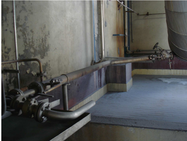
Abbildung 6-3: Position der Probenahme am Reaktorboden
