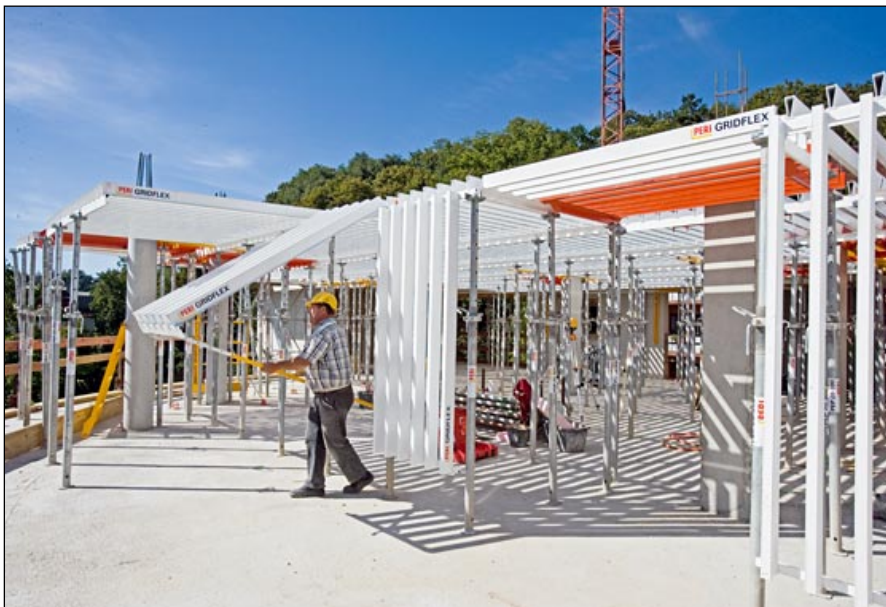
Bild 13.27 Aufbau einer Trägerrostschalung 513
