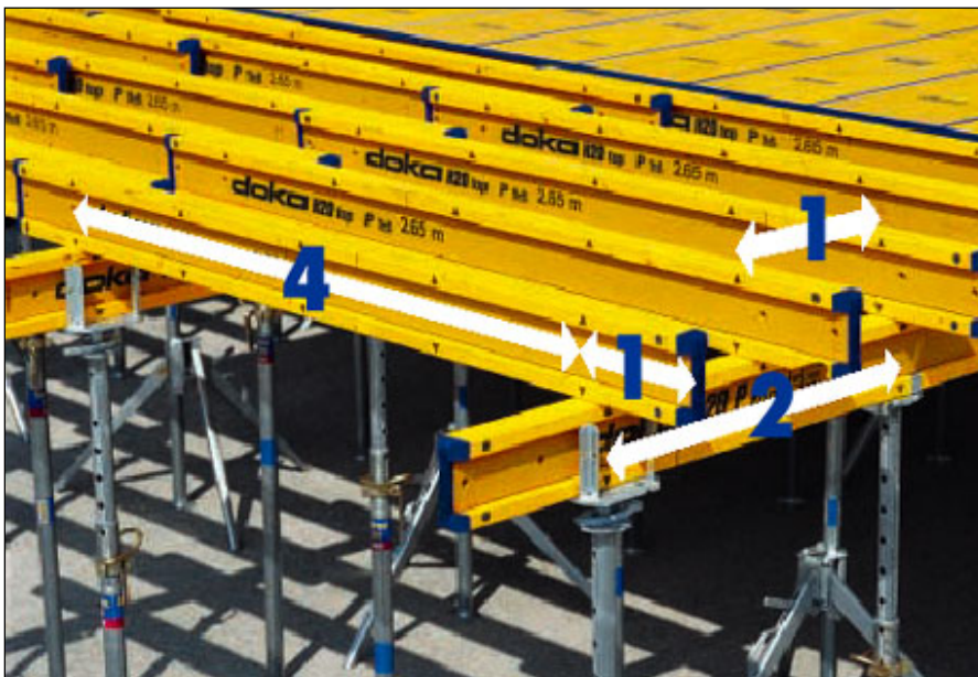
Bild 13.8 Trägerschalung ohne Fallkopf – Dokaflex 1-2-4 480
