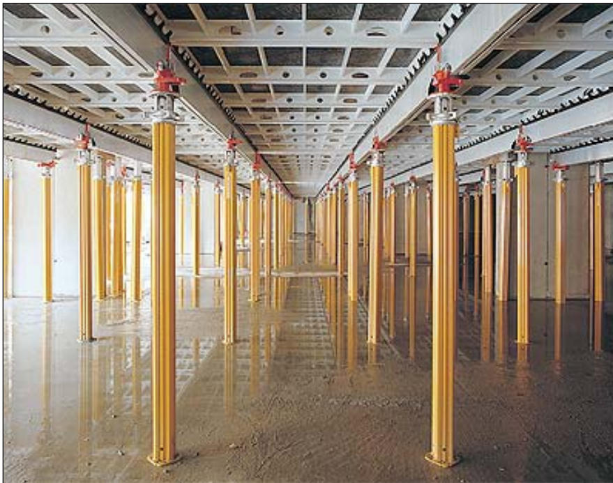
Bild 13.24 Rahmenschalung mit Fallkopf 505
