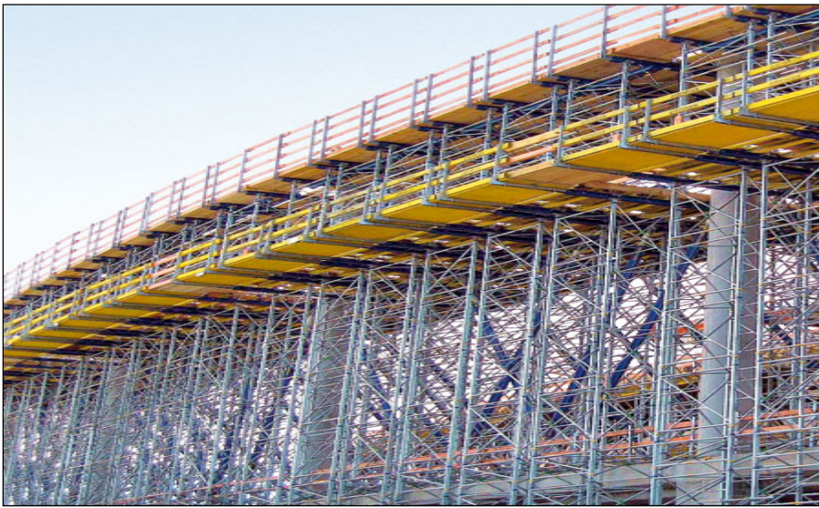
Bild 13.10 Traggerüste in der Praxis 482
