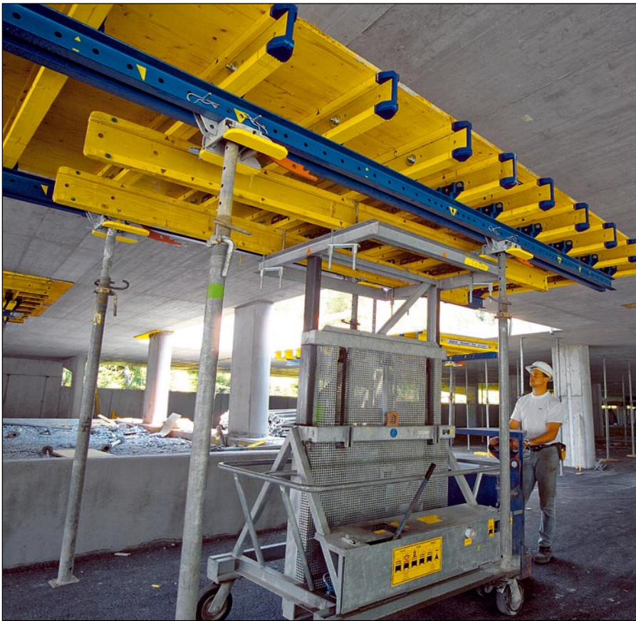
Bild 13.29 Deckentisch mit Längsträgern aus Stahlprofilen 524
