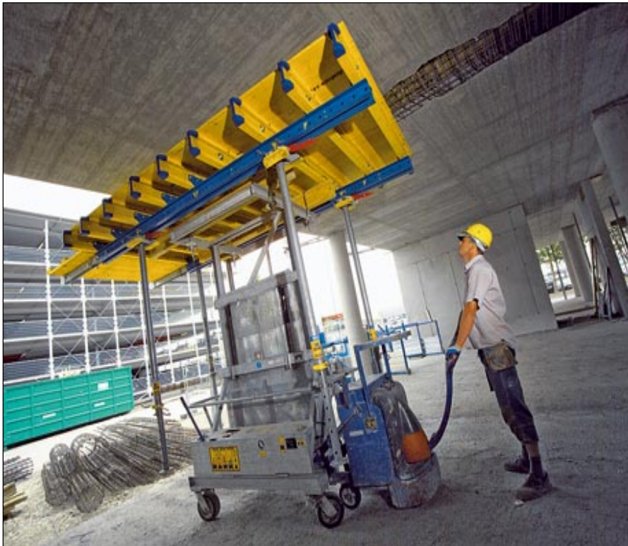
Bild 13.28 Horizontales Umsetzen eines Deckentisches 517
