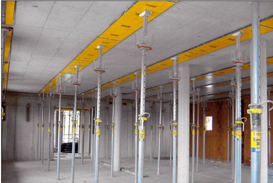
Bild 13.17 Anwendung des Systems Doka Xtra in der Praxis nach der Phase des Frühausschalens 489
