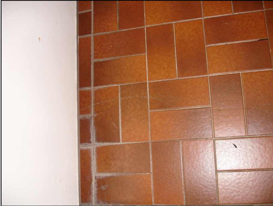
Abbildung 6-7 Abnutzung der keramischen Bodenbeläge
