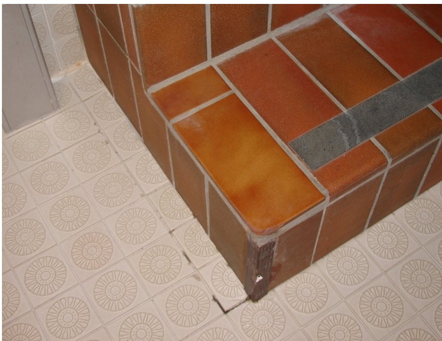
Abbildung 6-12 Abnutzungserscheinungen Stiege
