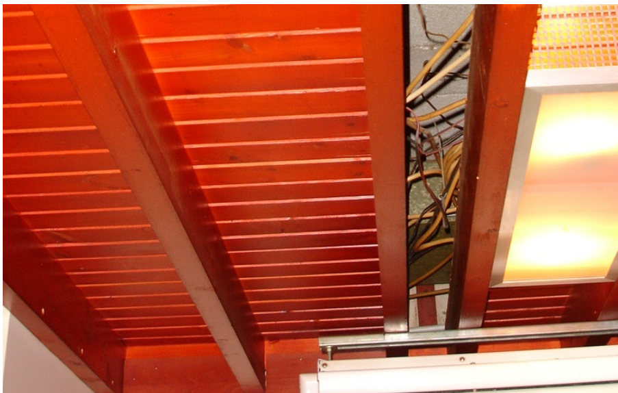
Abbildung 6-4 Abgehängte Decke Bereich Buffet Erdgeschoß
