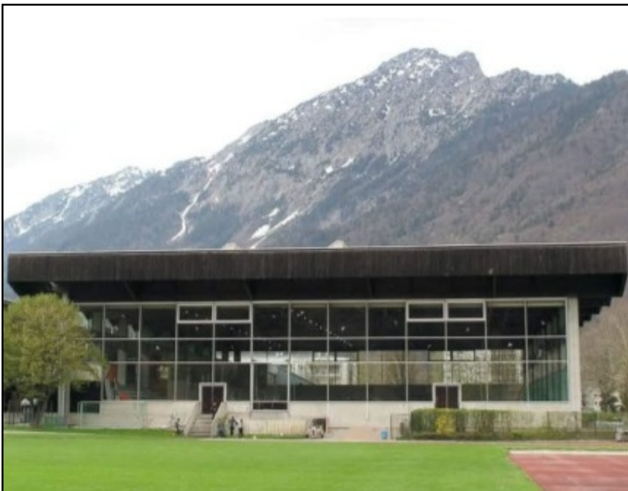
Abbildung 3-6 Eissporthalle Bad Reichenhall 53
