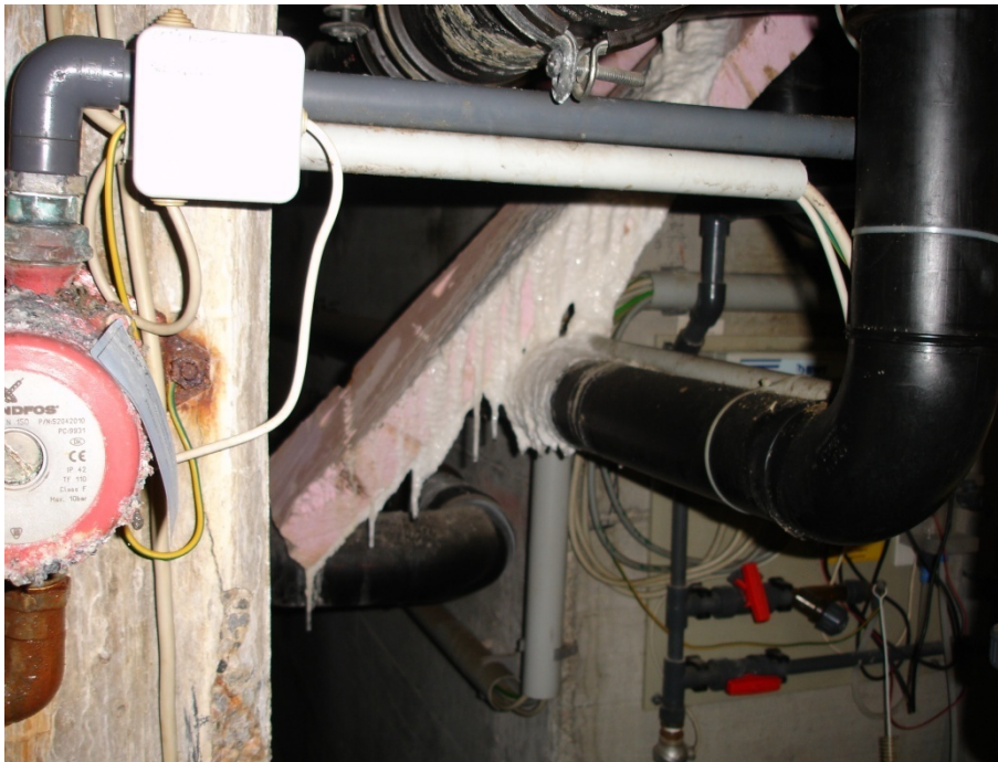
Abbildung 6-15 Versinterung im Bereich des Beckenunterbaus
