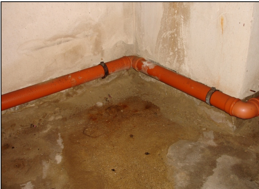
Abbildung 6-8 Boden des Untergeschoßes, sichtbare Durchfeuchtung
