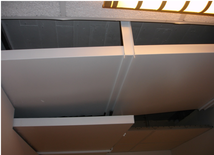
Abbildung 6-5 Notdürftige Konstruktion um eintretendes Wasser abzuleiten
