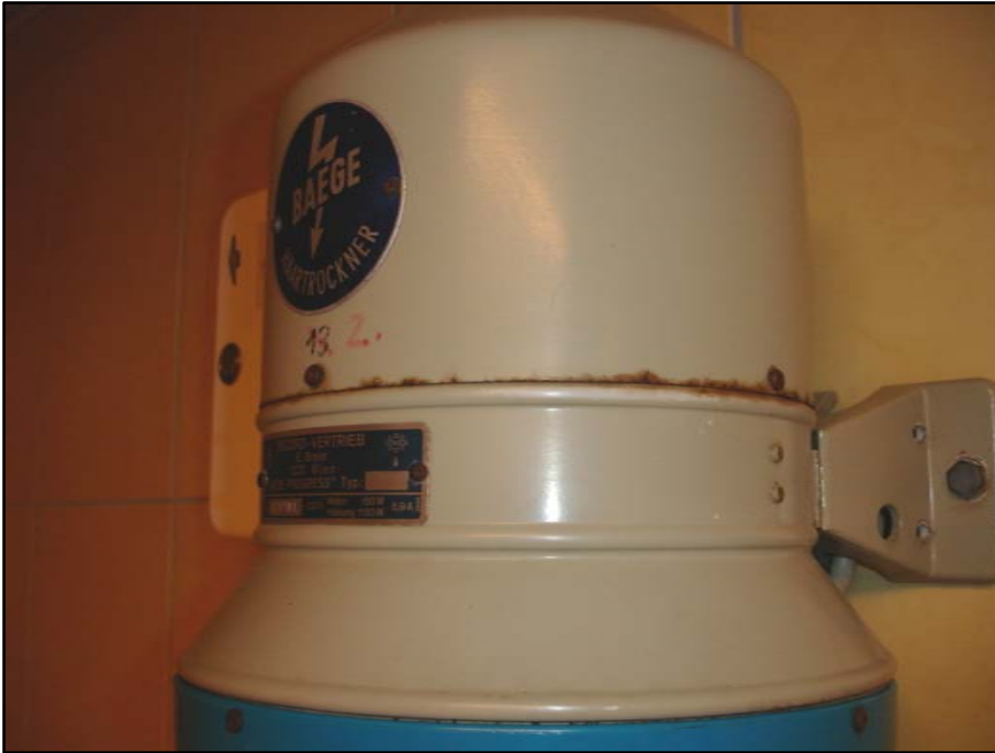
Abbildung 6-25 Haartrockner mit Rostspuren
