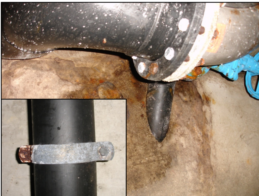
Abbildung 6-19 Korrodierte Leitungsschellen und Undichtigkeiten
