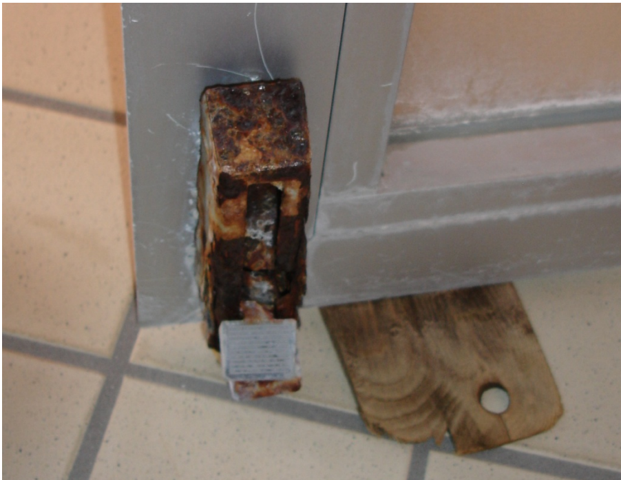
Abbildung 6-16 Türfeststeller der Dampfbadkabinentür, stark korrodiert
