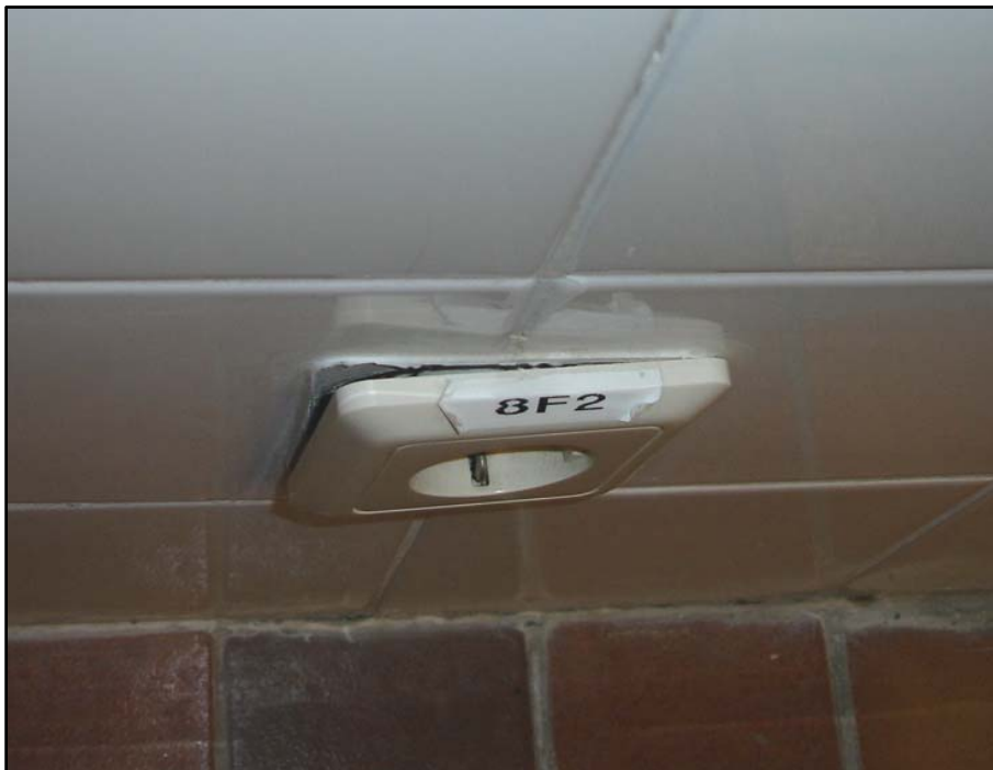
Abbildung 6-24 Lose Steckdose, neben der Dusche
