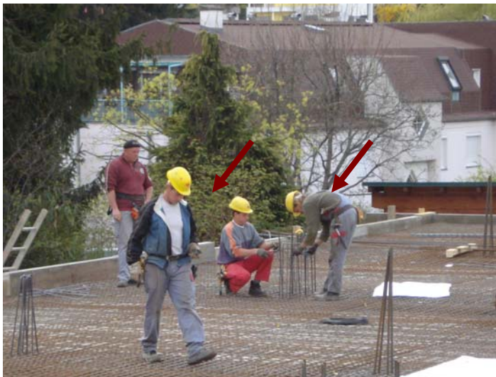
Abbildung 5.4: Beispiel für das Einfädeln der Anschlussbewehrung
