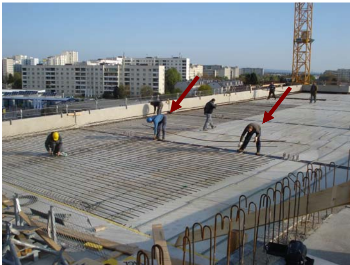
Abbildung 5.2: Beispiel für das Auflegen der unteren Hauptbewehrung
