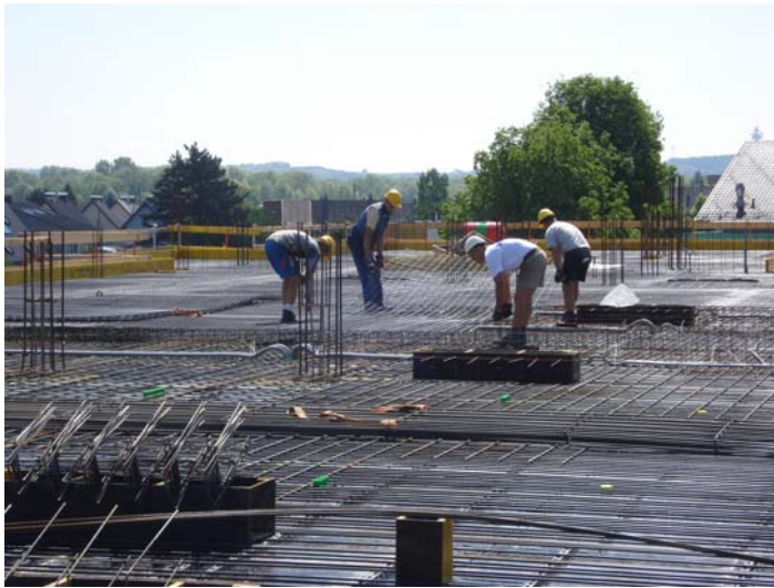
Abbildung 5.3: Beispiel für das Auflegen von Bewehrungsmatten
