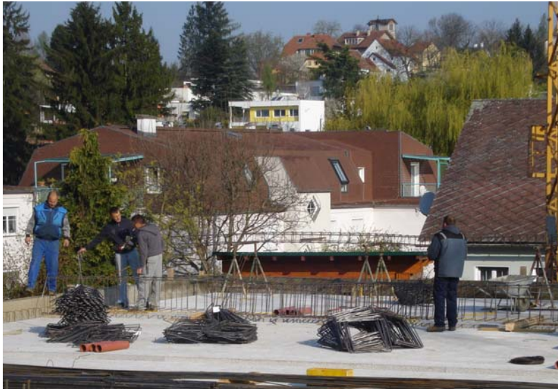
Abbildung 5.8: Arbeiter beim Bewehren eines Trägers
