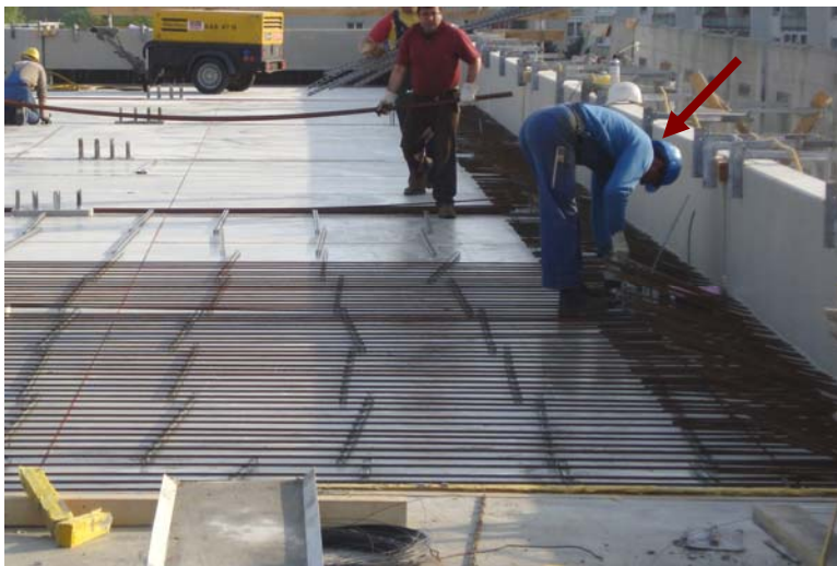
Abbildung 5.9: Arbeiter beim Vorbereiten der Anschlussbewehrung
