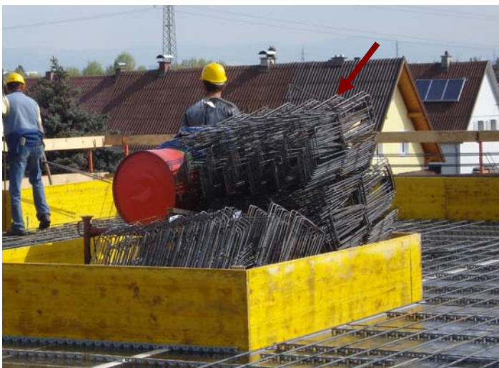
Abbildung 5.6: Zusammengefasste Randbügel als vorgefertigte Elemente
