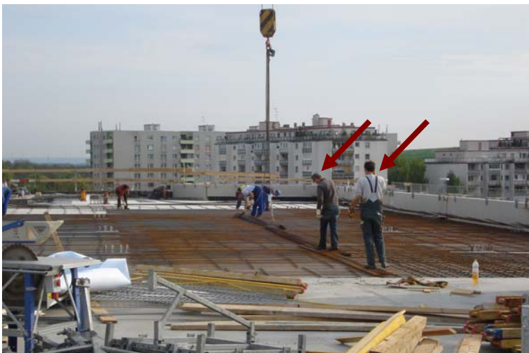
Abbildung 5.13: Arbeiter beim Vorbereiten der Bewehrung am Arbeitsplatz
