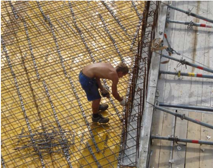
Abbildung 5.5: Arbeiter beim Verlegen von einzelnen Randbügel
