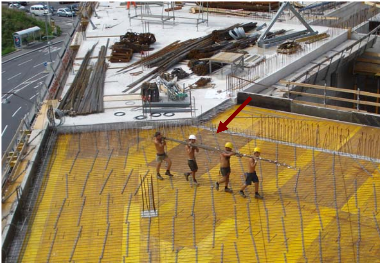
Abbildung 5.14: Transport der Bewehrung zur Einbaustelle (ohne Kran)
