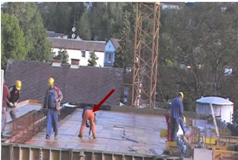
Abbildung 5.12: Arbeiter beim markieren von Stababständen
