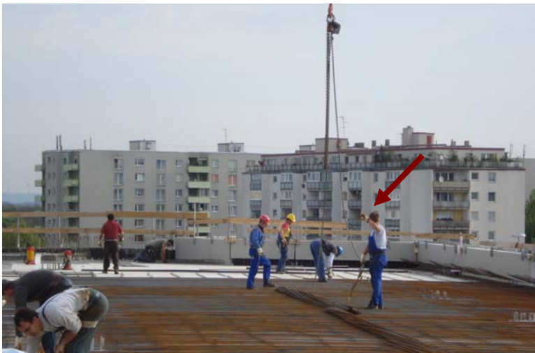
Abbildung 5.15: Vorarbeiter der Bewehrung mit Kranunterstützung vorbereitet
