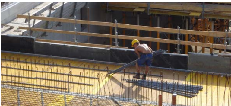
Abbildung 5.10: Arbeiter beim Verlegen von Abstandhaltern
