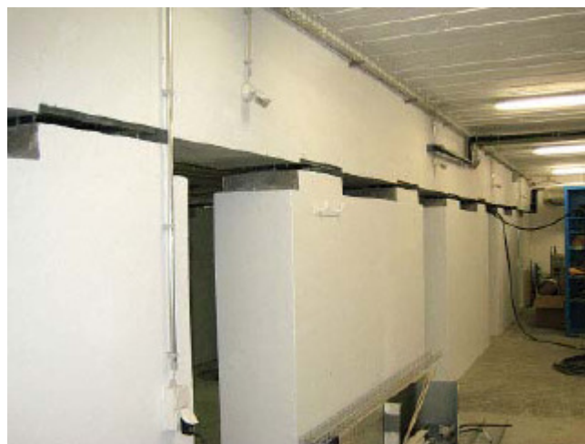
Abbildung 2.12: Gleitlager im Kellergeschoss auf den horizontal durchgeschnittenen Innenwänden [11]
