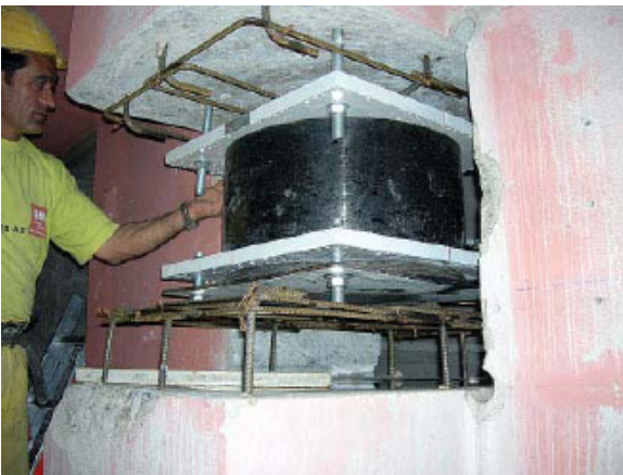
Abbildung 2.10: Einbau eines Erdbebenlagers mit Flachpresse (unten) und Spreizbewehrung [11]
