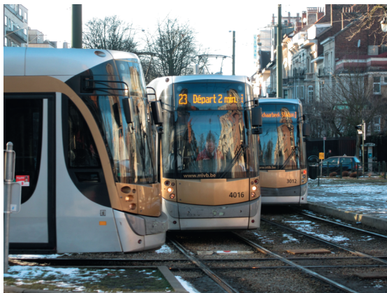
Abbildung 6.1.: Neue Straßenbahnwagen am Südenende des Prémétrotunnels in Brüssel
