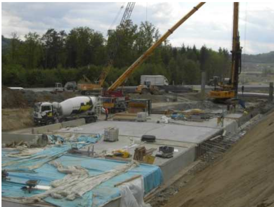
Abbildung 1: Baustellenbereich der ARGE Hengsbergtunnel im April 08
