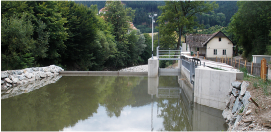
Abbildung 1.24: KW Zwischenwässern: Wehranlage - oberwasserseitig
