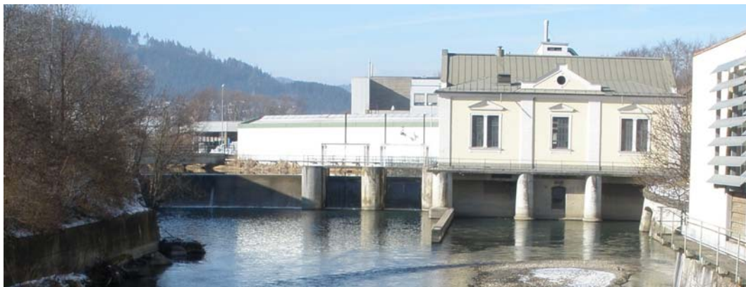
Abbildung 1.30: KW TCW: Wehr und Krafthaus - unterwasserseitig
