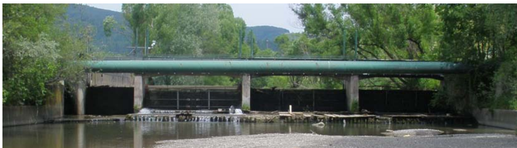
Abbildung 1.32: KW Tilly: Wehranlage - unterwasserseitig
