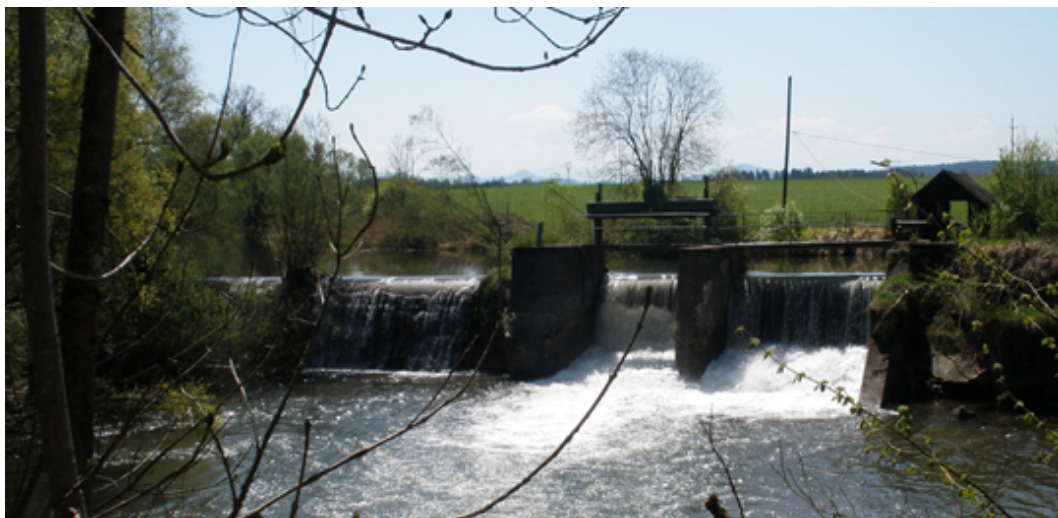
Abbildung 1.34: KW Brugga: Wehranlage - unterwasserseitig
