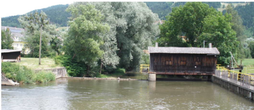
Abbildung 1.42: KW Donau Chemie: Wehranlage - oberwasserseitig
