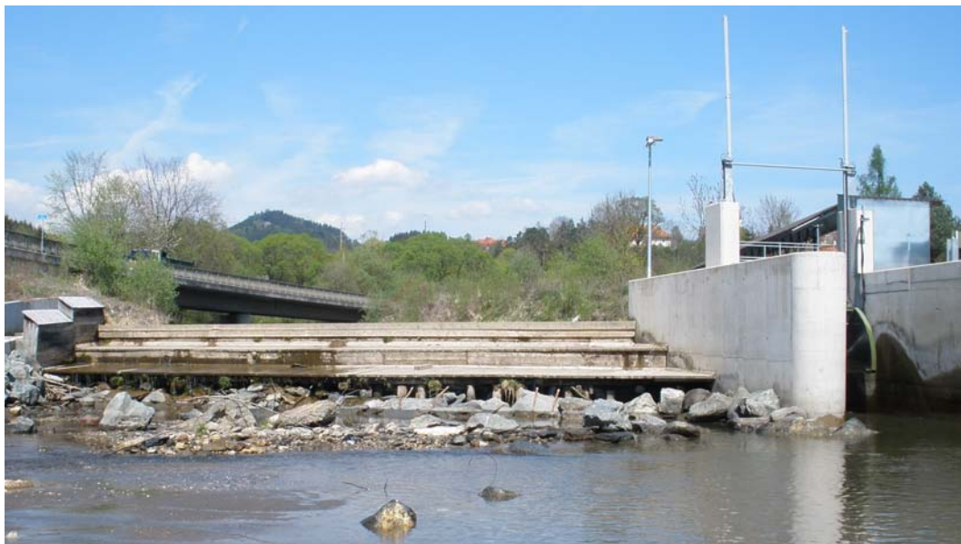
Abbildung 1.26: KW Bistum Pöckstein: Wehranlage - unterwasserseitig
