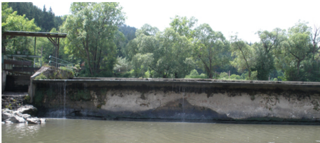
Abbildung 1.38: KW Pölling: Wehranlage - unterwasserseitig
