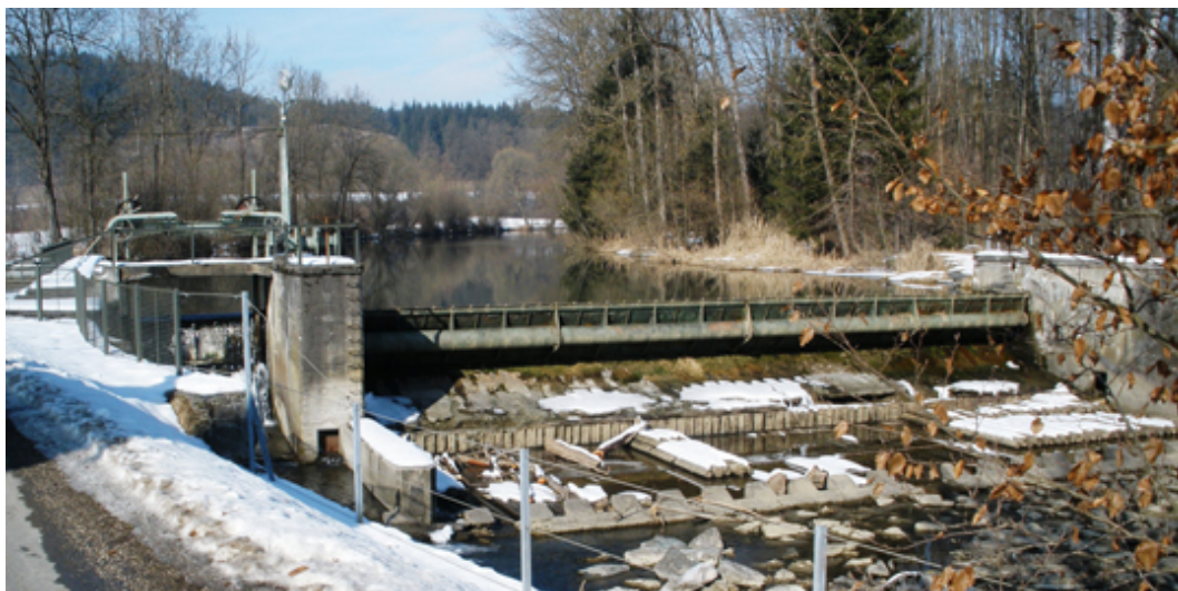
Abbildung 1.40: KW Launsdorf: Ausleitungswehr - unterwasserseitig
