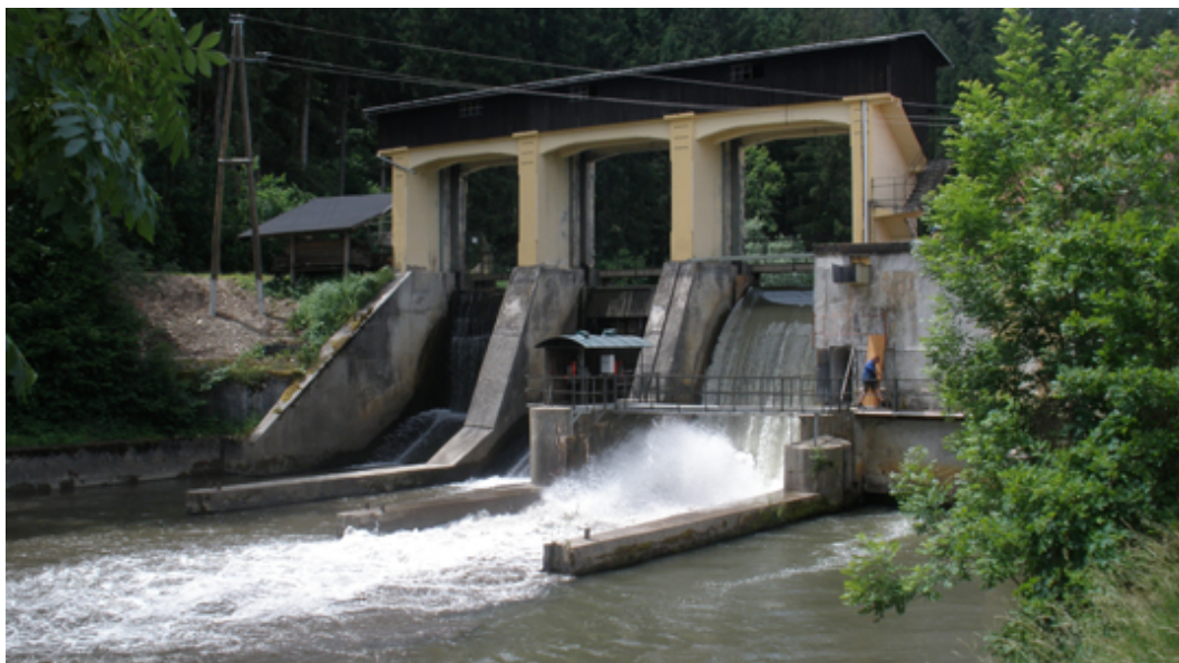
Abbildung 1.36: KW Passering: Wehranlage - unterwasserseitig
