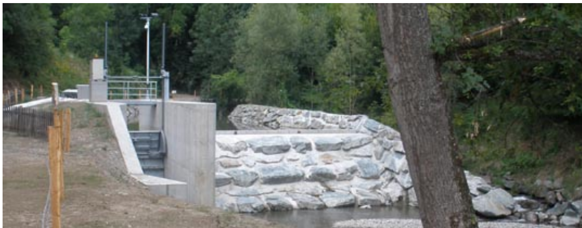
Abbildung 4.12: Wehranlage vom Unterwasser aus gesehen
