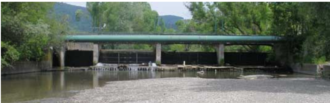
Abbildung 4.30: Wehranlage vom Unterwasser
