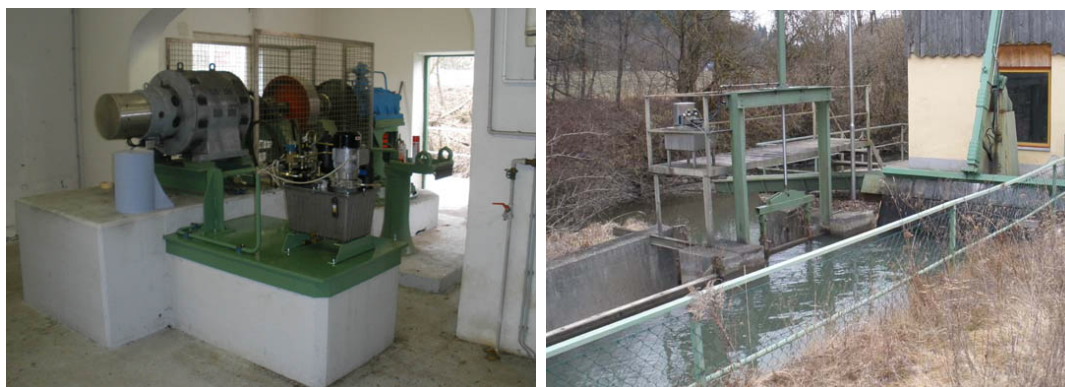
Abbildung 4.8: Maschinenraum, Einlauf Krafthaus
