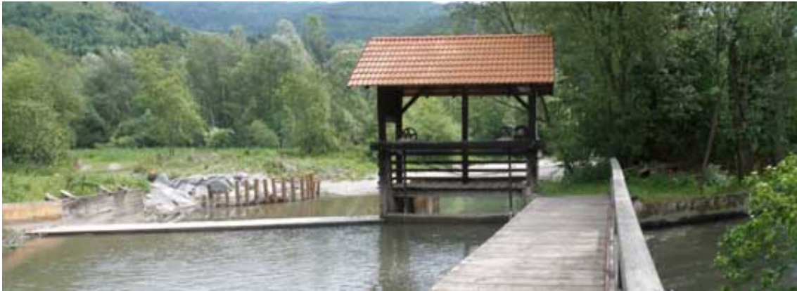
Abbildung 4.2: Wehranlage mit Grundablass-Schütz und Ausleitung
