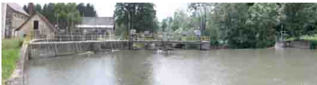
Abbildung 4.22: Wehranlage mit Zuleitung zum Krafthaus
