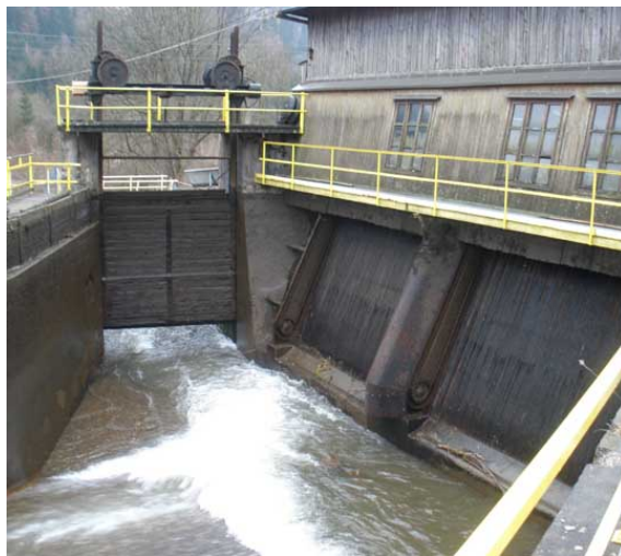
Abbildung 4.54: Einlaufbauwerk vom Kanal in den Druckstollen
