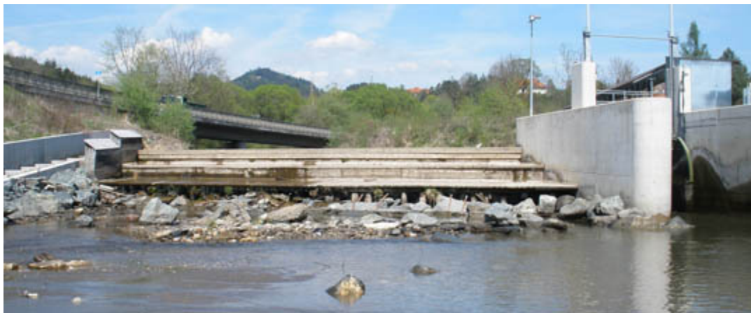
Abbildung 4.17: Wehrfeld vom UW mit Klappe
