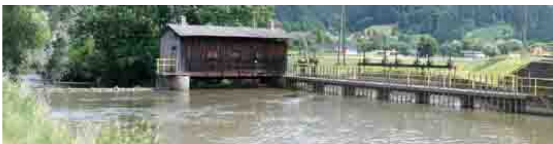
Abbildung 4.53: Wehranlage mit Ausleitung(rechts)
