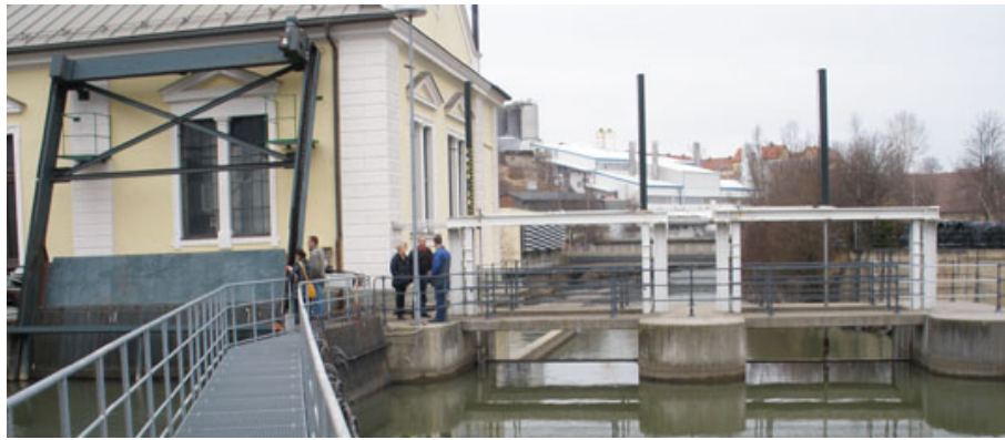
Abbildung 4.27: Einlauf Krafthaus, Tafelschütz II (links) und III(rechts)
