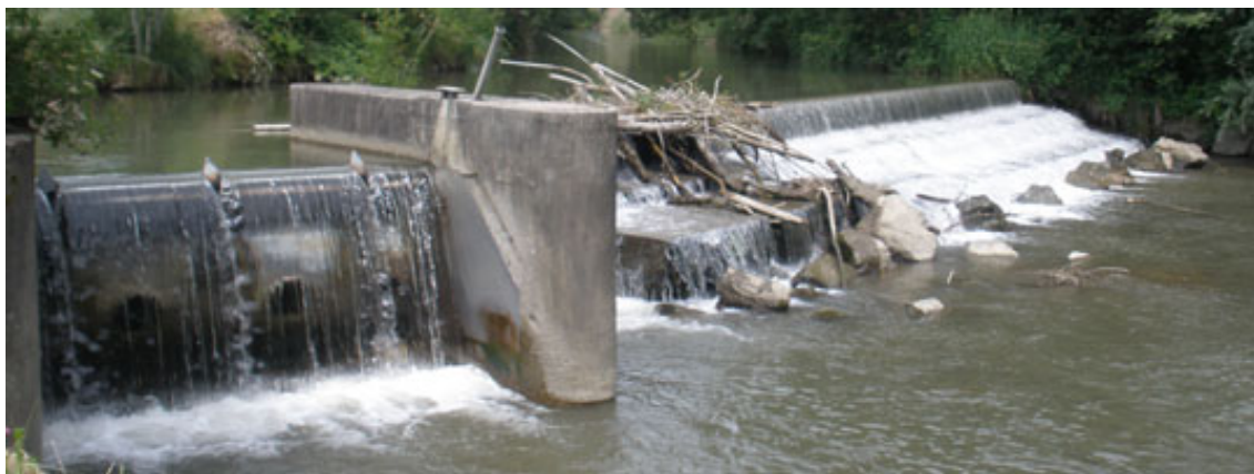
Abbildung 4.7: Wehranlage vom Unterwasser aus gesehen
