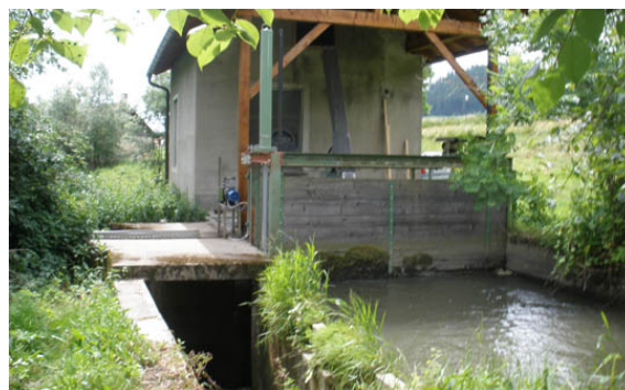
Abbildung 4.3: Einlauf Krafthaus mit seitl. Überlauf
