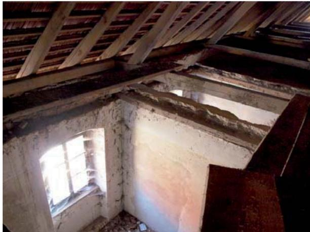
Abb. 246: Dachboden, eingestürzte Decke
