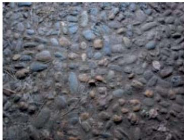
Abb. 251: Kugelstein-Pflasterung,
