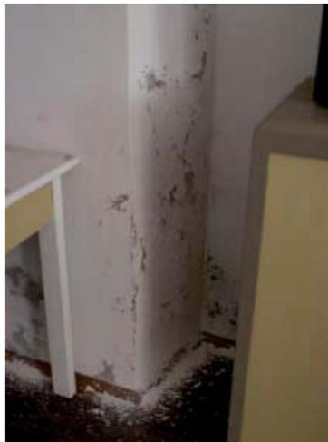
Abb. 380: Wasserschaden,
