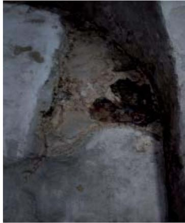
Abb. 396: Wasserschaden, Durchfeuchtung, Raum 05
