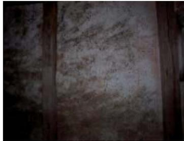
Abb. 308: verputztes MW, Spuren von Lagergut, Holzstützen, Raum 11
