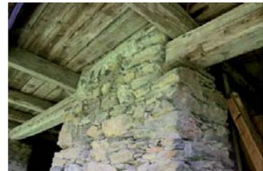
Abb. 365: Bruchstein-Mauerwerk,
