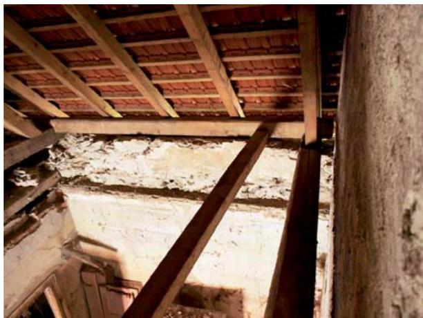
Abb. 247: Dachboden, eingestürzte Decke
