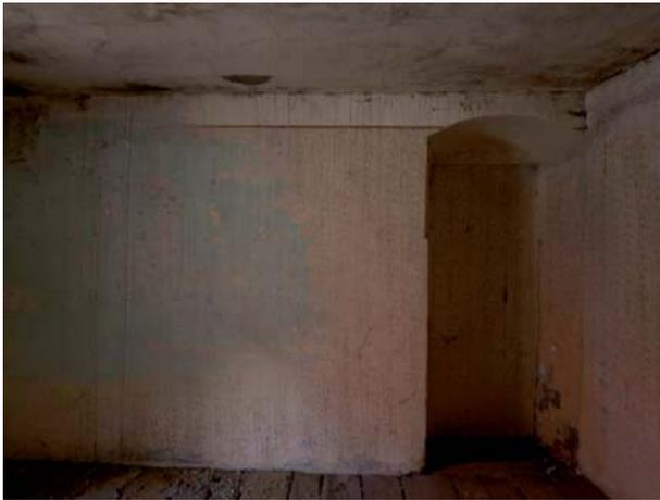
Abb. 239: Zugemauerter Durchgang mit Rundbogen, Raum 15
