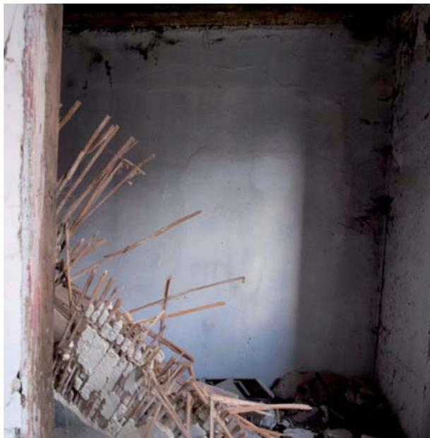
Abb. 226: Zimmer mit eingestürzter Decke, Raum 07
