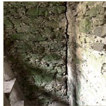
Abb. 86: Bruchsteinmauer
