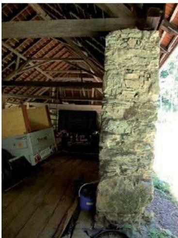
Abb. 375: Bruchstein-Mauerwerk, Raum 01
