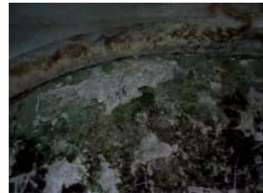
Abb. 398: Wasserschaden, Durchfeuchtung, Raum 02
