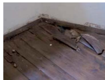
Abb. 383: Wasserschaden,
