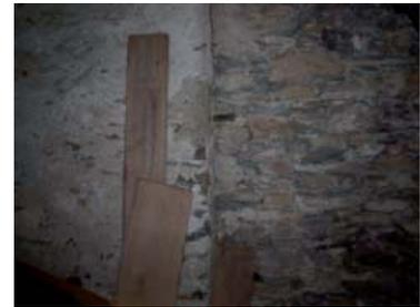
Abb. 309: Bruchstein-MW, links verputzt, rechts freigelegt, Ausgang zu Raum 10
