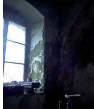
Abb. 399: Wasserschaden, Durchfeuchtung, Raum 02
