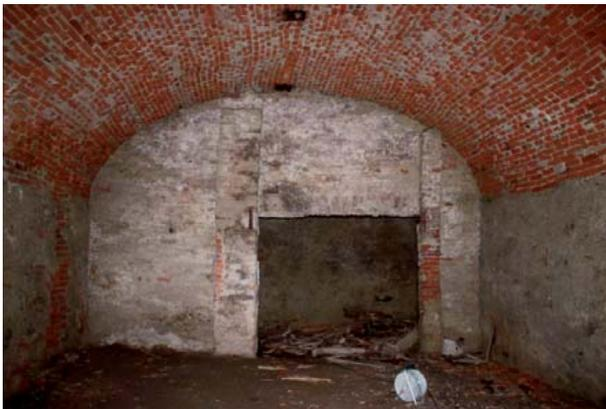
Abb. 212: „Bier-Lagerkeller“ mit großer Öffnung zum vorderen Teil des Kellers, Raum 03
