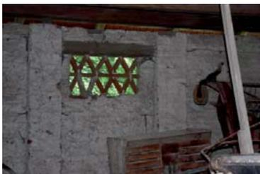
Abb. 373: Ziegelmuster in Maueröffnung und grob verputztes Ziegelmauerwerk, Raum 01
