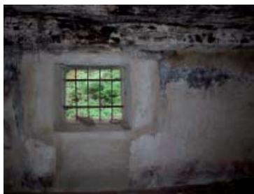
Abb. 407: Wasserschaden im oberen Bereich der Mauer und an der gesamten Decke, Raum 14
