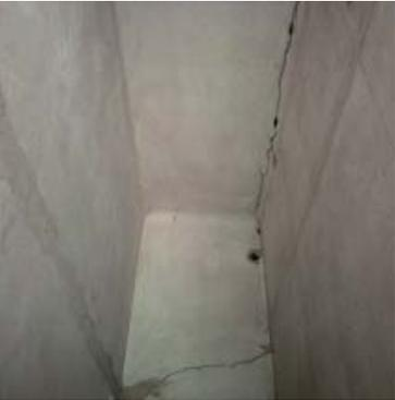
Abb. 389: Setzungsrisse, Wasserschaden, Raum 18
