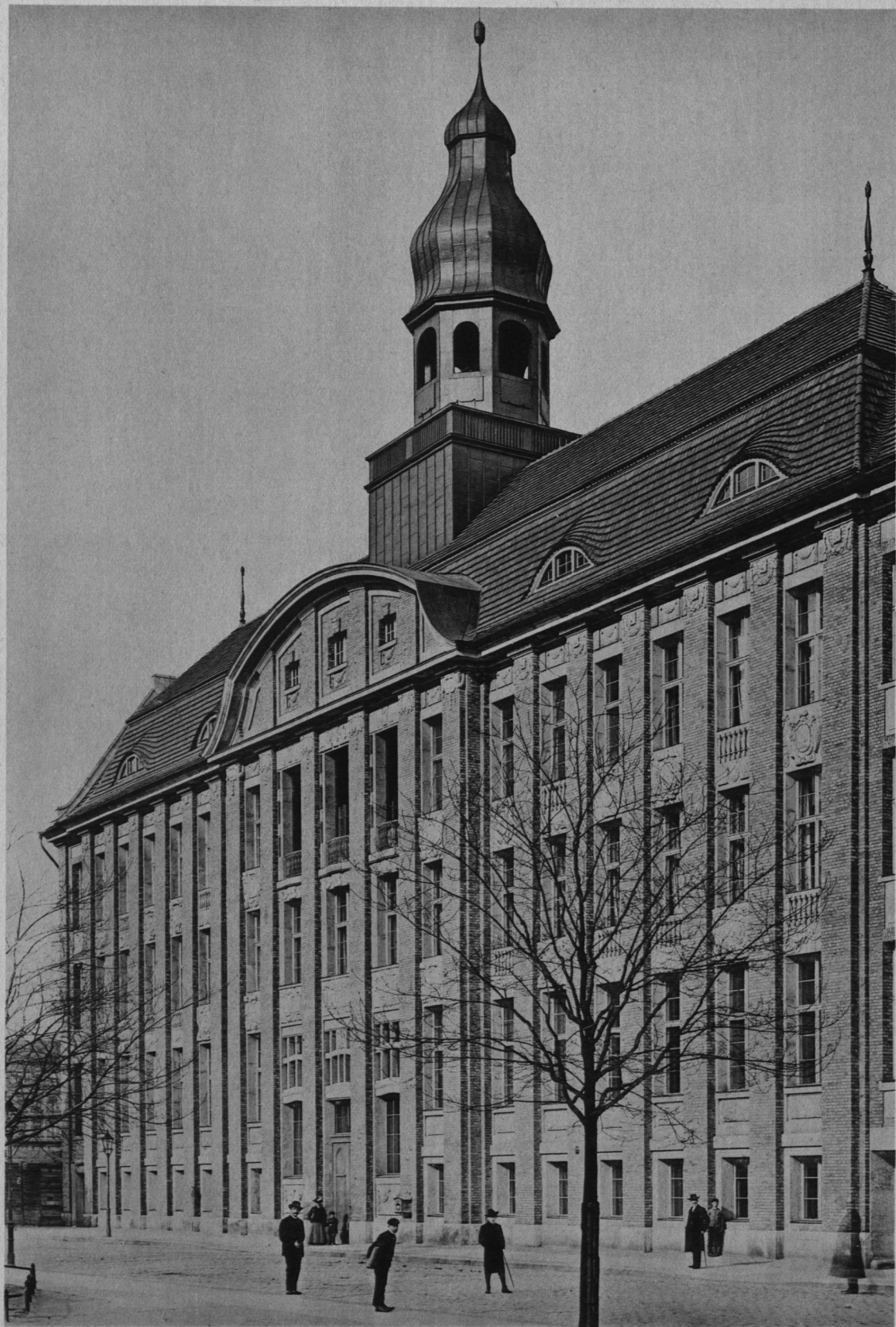
LANDESVERSICHERUNGSANSTALT IN BERLIN ANSICHT DER STRASSENFRONT ARCHITEKT: ALFRED MESSEL
