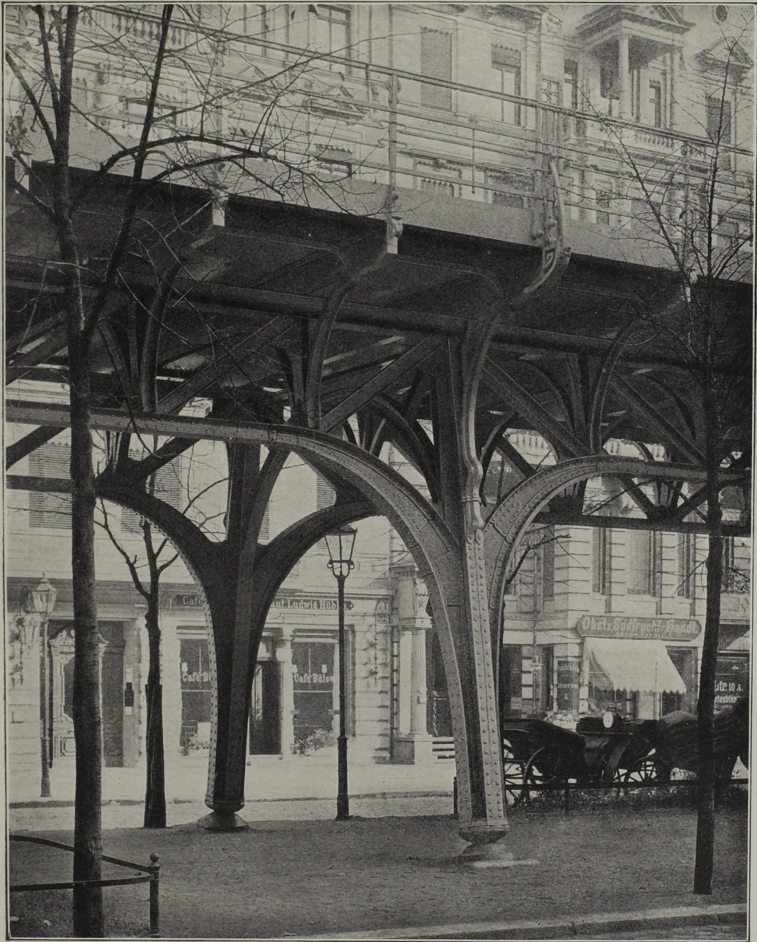
Hochbahnpfiler und -Geländer zwischen Potsdamer- und Frobenstrasse in Berlin
